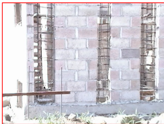
Fig. 4.117 columnas y nervios para prepararlos y moldearlos.
