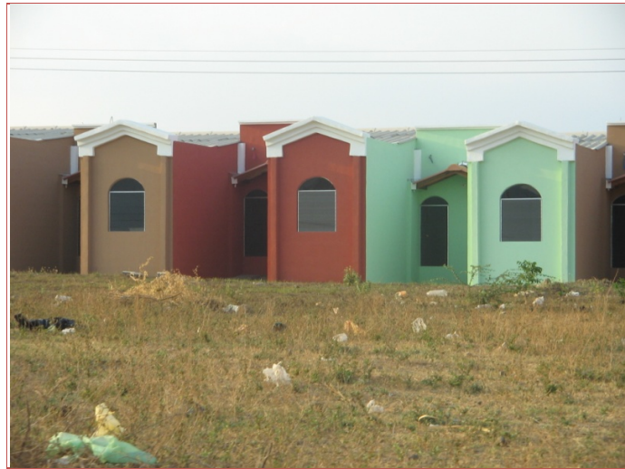
Fig. 3.88 Vivienda con su acabado completo.
