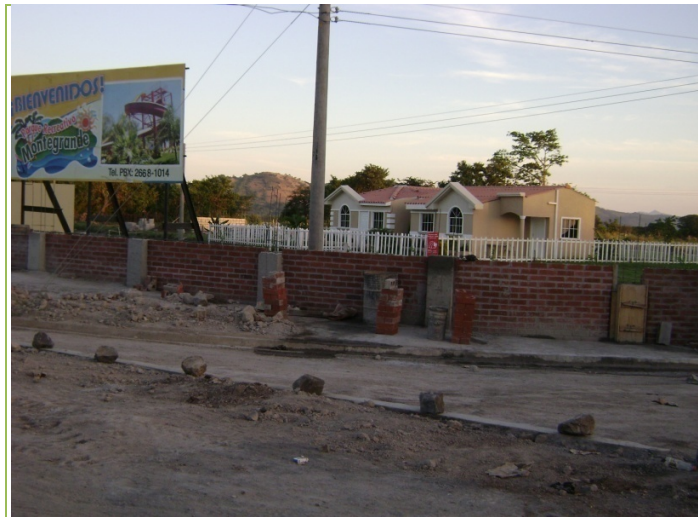
Fig.3.45 Obra de protección.
