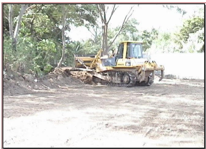
Fig. 4.91. Corte de la capa vegetal superficial
