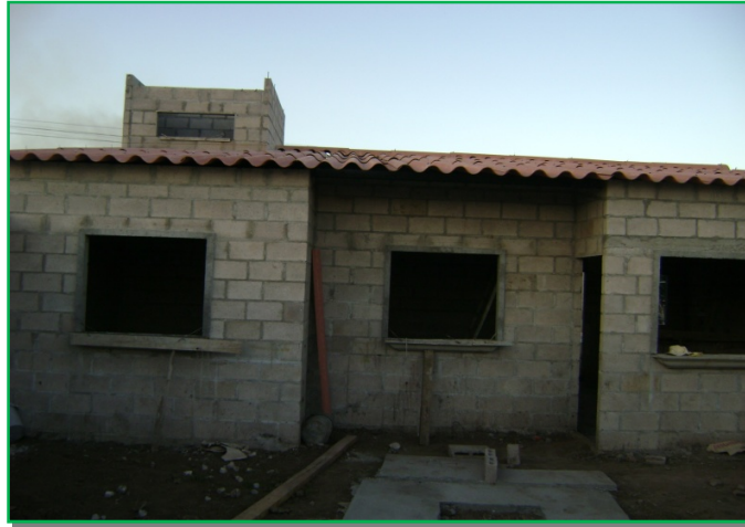
Fig. 4.123. Cubierta de techo, Lamina de asbesto cemento
