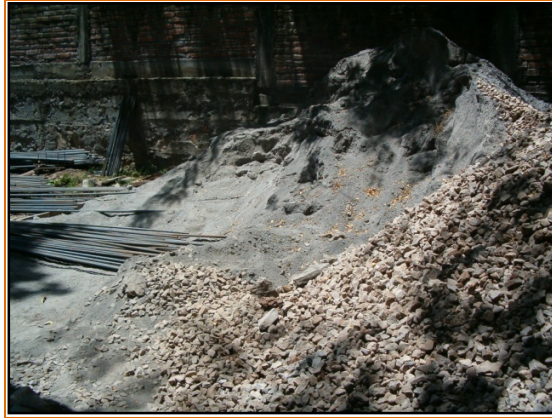
Fig.3. 26 Grava, arena y acero de refuerzo en el mismo depósito.
