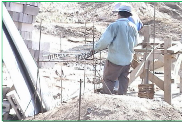
Fig.3.64 Armado de solera de fundación.
