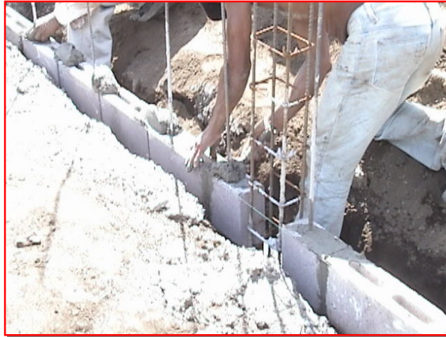
Fig. 4.119 Pegado de bloques.
