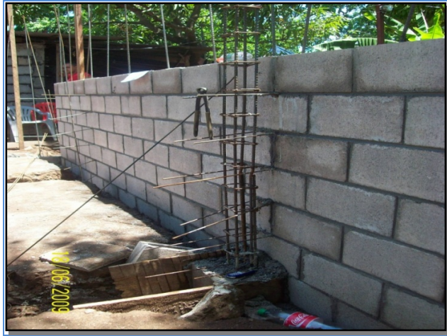
Fig.3.69 Solera intermedia y columna.
