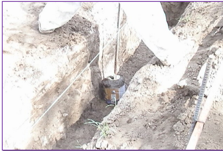
Fig.3.38 Compactación sobre la tubería de forma manual.
