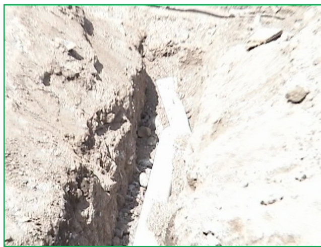
Figura 3.37 Colocación de tubería
