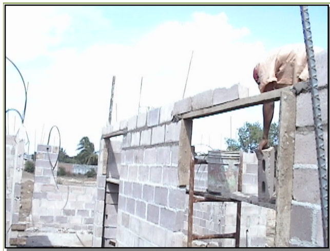
Fig. 4.126 paredes con sus respectivos ductos.
