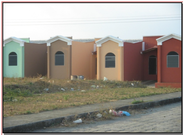
Fig. 3.89 Viviendas con su respectiva pintura.
