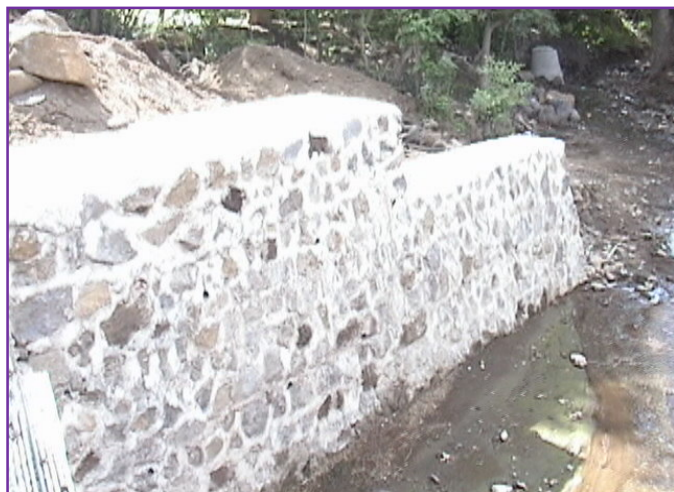
Fig. 3.46 Muro de piedra
