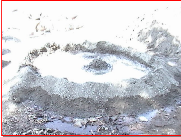
Fig. 4.121. Forma incorrecta de elaboración de mortero.
