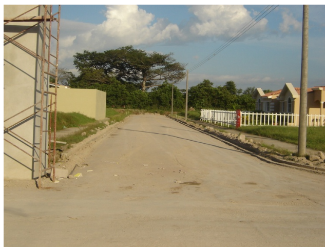
Fig. 4.107 Compactaciones de la subrasante en la calle de una urbanización
