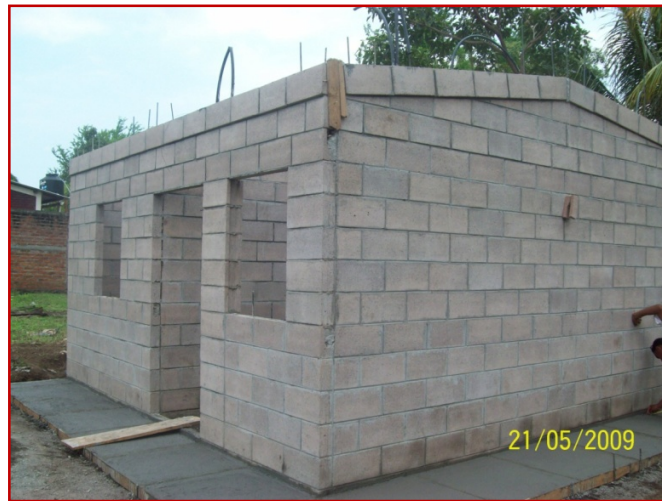
Fig. 3.73 Vivienda con paredes terminadas.
