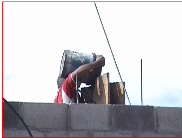
Fig. 4.118 colado de columna.
