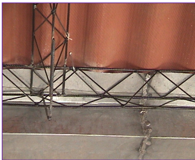
Fig.3.74 Estructura de techo polín espacial y lámina de asbesto – cemento
