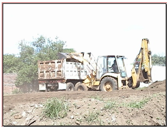
Fig. 4.92 Desalojo de la capa vegetal superficial.
