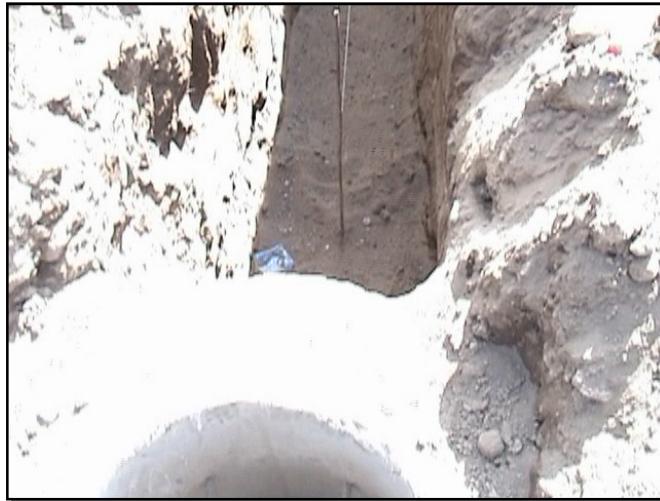
Fig. 3.40 Compactación en tubería.
