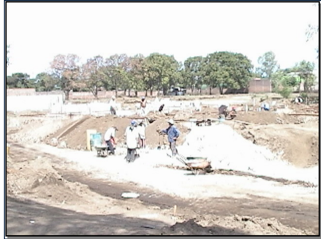
Fig. 4.96 Compactación en una urbanización.
