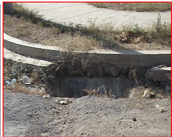
Fig.4.105 Calle y Cordón cuneta Fig.4.106 Cordón Cuneta con su respectiva caja colectora.
