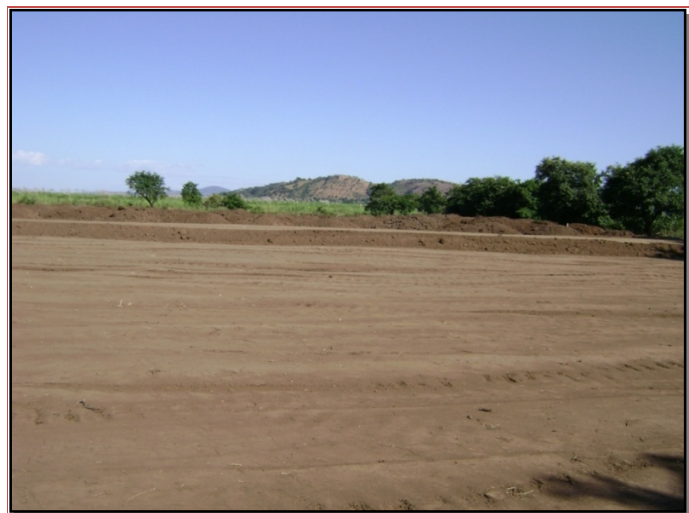
Figura 3.20 Preparación del terreno formando terrazas
