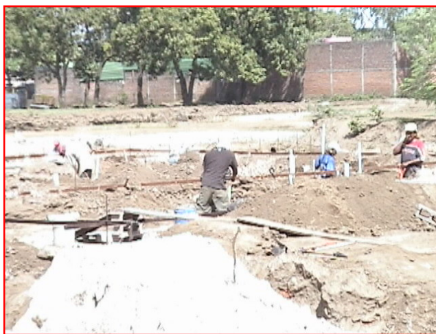
Fig. 4.111. Compactación de soleras de fundación de viviendas.
