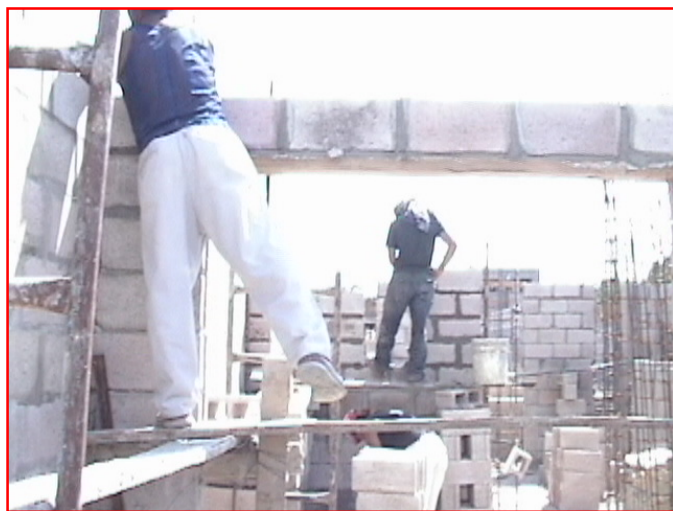
Fig. 4.120. Construcción de solera de coronamiento.
