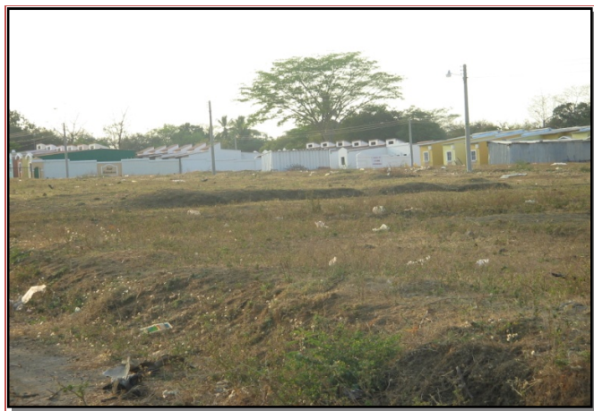
Fig. 3.90 Viviendas terminadas en la urbanización.
