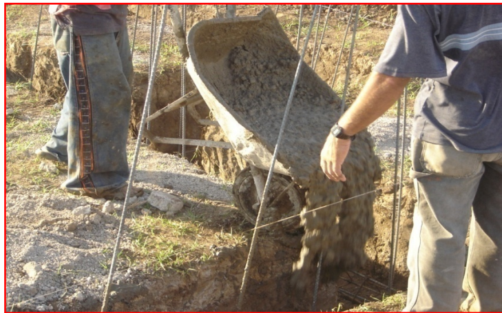
Fig. 3.66. Colado de fundación de una vivienda en urbanización.
