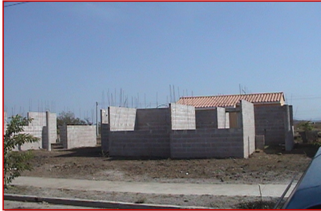
Fig. 3.72 Construcción de paredes de bloque en una urbanización
