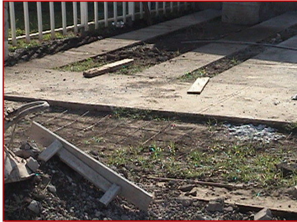
Fig. 104 Acera de una vivienda y la otra parte tiene que prepararse para colar.
