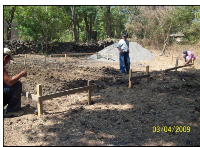
Figura 3.61 Trazo de una vivienda individual
