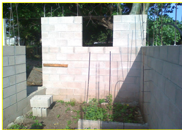
Fig.3. 71 Pared a nivel de ventana.
