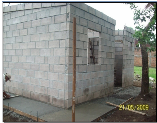
Fig. 3.49 Colado de una acera en una vivienda.
