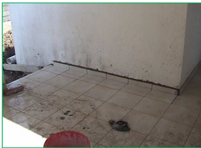
Fig. 3.79 Colocación de piso
