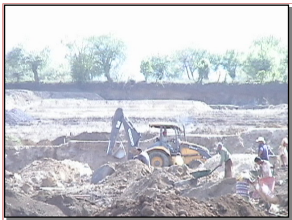
Fig.4.93 Excavación de tuberías de aguas negras, lluvias y potable.
