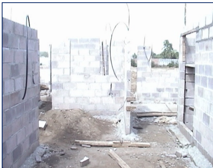
Fig. 3.81 Paredes con sus respectivos ductos.
