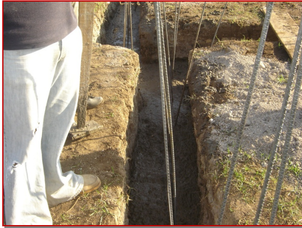
Fig. 4.114 colado de solera de fundación en una vivienda.
