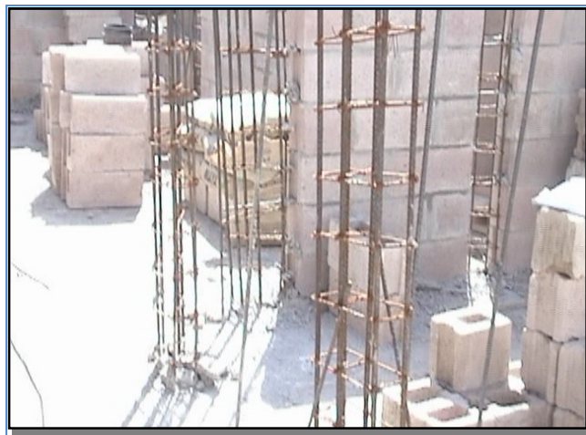
Fig. 3.70 Preparar las columnas para luego ser moldeadas.
