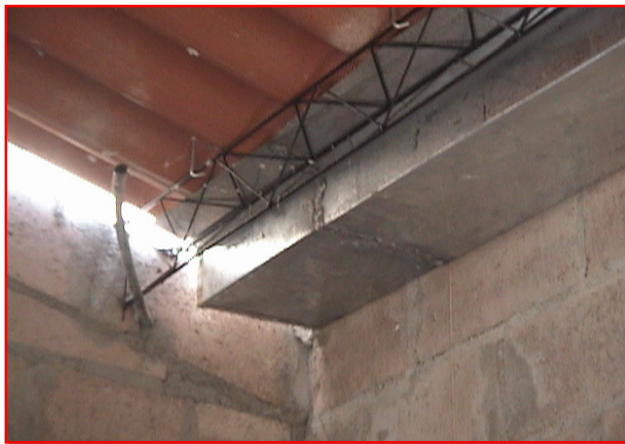
Fig. 4.122 Estructura de techo polín espacial, con su canaleta.
