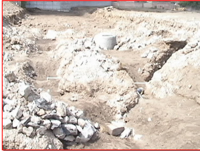
Fig. 4.98 Acometida de aguas potable y pozo de aguas negras.
