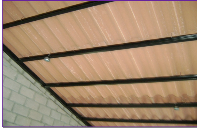
Fig.3.76 Estructura de techo Polín "C" y lámina de asbesto –cemento
