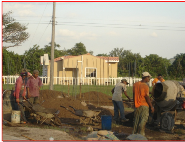
Fig.4.113 Elaboración de concreto para depositarlo en una solera de fundación.
