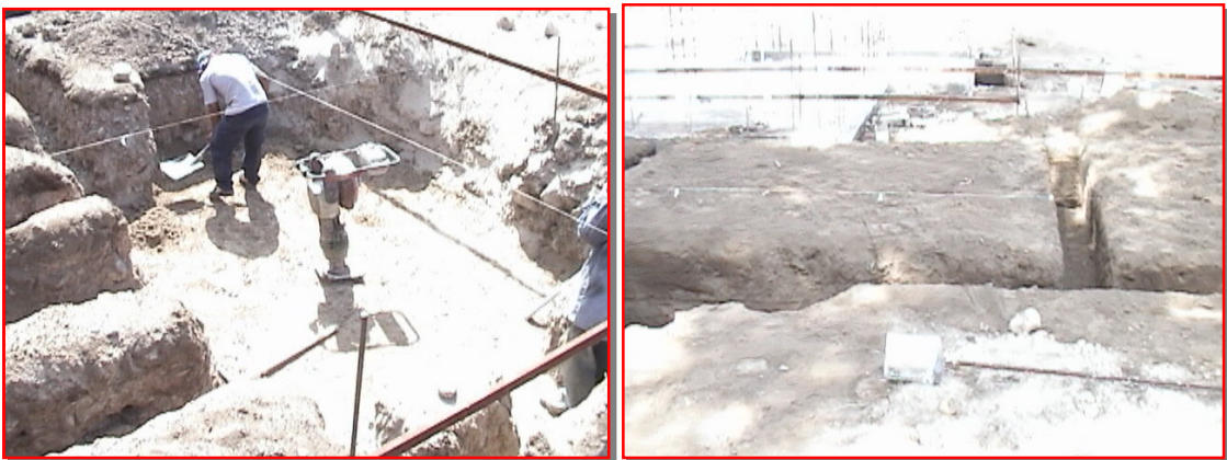
Fig. 4.110 Excavación de viviendas.
