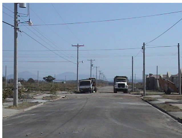
Fig. 4.108 EL Imprimado de la calle lo están curando con una capa de arena..
