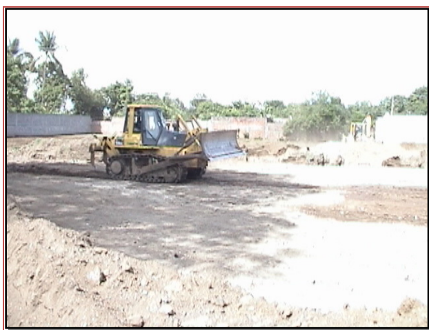
Fig. 4.94 Corte en terraza
