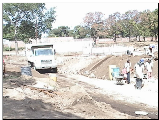
Fig. 4.95 Transporte de material selecto
