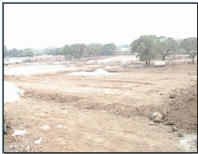
Figura 3.19 Preparación del terreno
