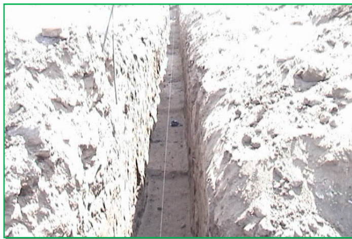
Fig. 3.36 Excavación de tuberías en una urbanización.
