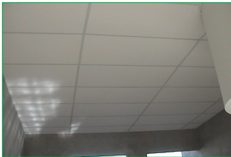
Fig. 3.78 Cielo falso terminado.
