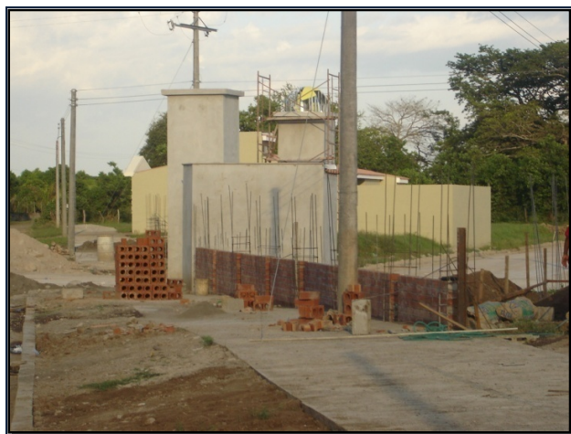
Fig. 4.102 Construcción de muros de protección.
