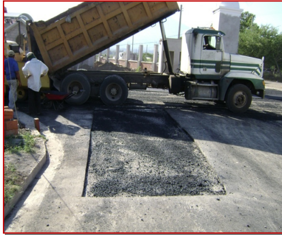
Fig.3.54 Hechura y colocación de pavimento
