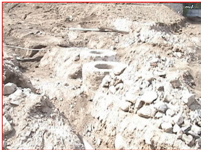
Fig. 4.98 Acometida de aguas potable y pozo de aguas negras.
