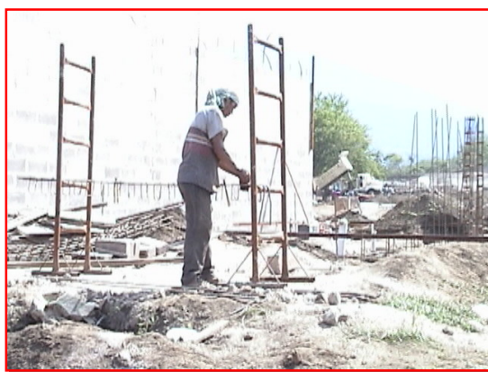
Fig. 4.116 armado de elementos estructurales.
