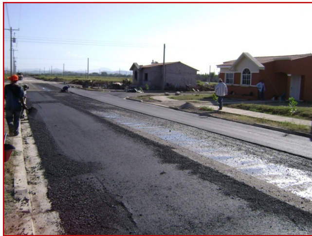
Fig.3.55 Imprimado y pavimentación en calles
