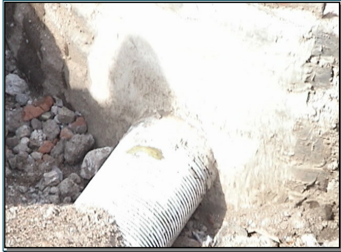
Fig. 3.41 Colocación de tubería Sanitaria
