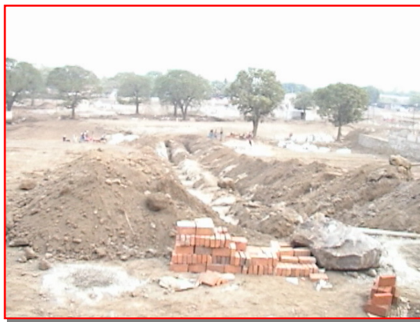
Fig. 4.97 Construcción de tubería de aguas lluvias.
