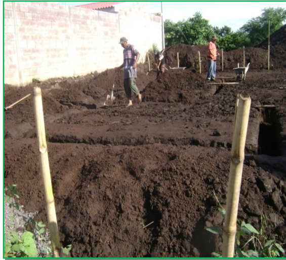
Fig. 3.62 Excavación de viviendas con sus respectivas compactaciones.
