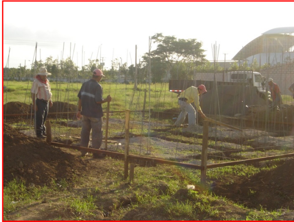
Fig. 4.12. Solera preparada para colar.
