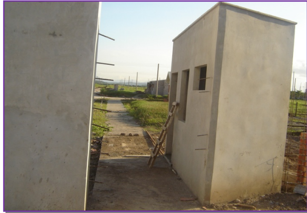
Fig. 3.48 Acera construida en una urbanización
