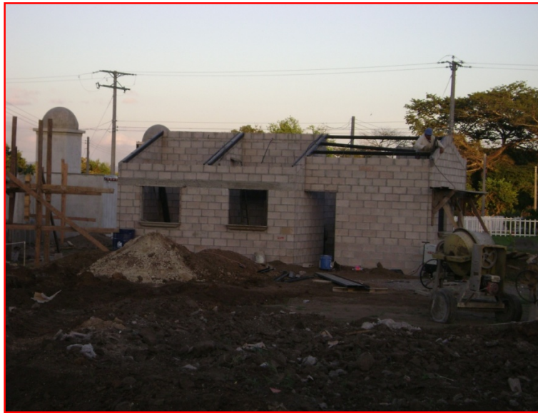
Fig.3.77 Colocación de estructuras de techo
