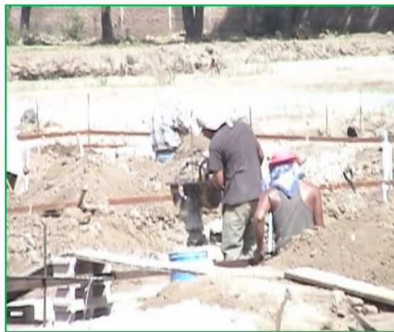
Fig. 3.63 compactaciones en las viviendas.
