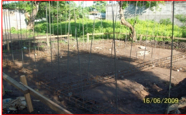
Fig. 3.65 Preparación de fundación en una vivienda
