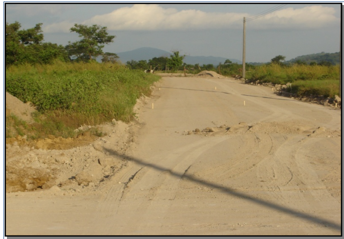
Fig. 3.23 Se observa la línea de referencia con sus respectivos trompos.
