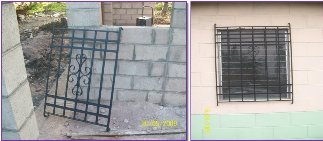
Fig.3.86. Balcón de ventana listo para colocar, y ventana completa.
