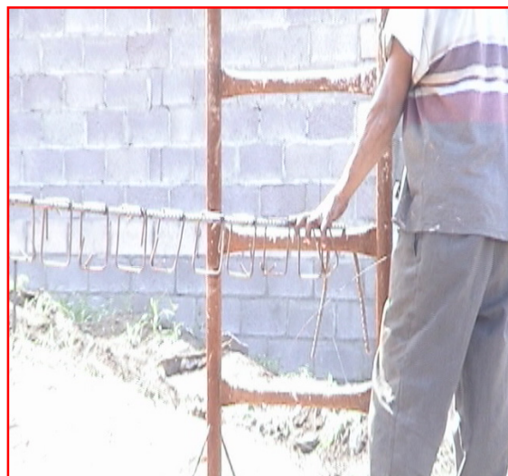
Fig. 3.68 Armado de nervadura.
