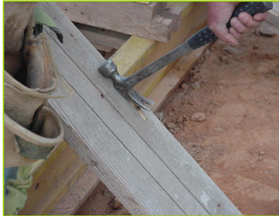
Fig.3. 30 Retirar los clavos de la madera
