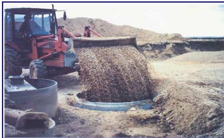
*Figura 3.4.10. Pozos colgados rellenado con grava para reducir el efecto de colmatación*
