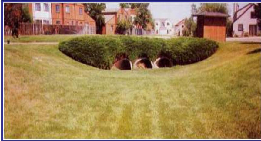
Figura 3.5.22. Canal de pasto con alcantarilla bajo calzada
