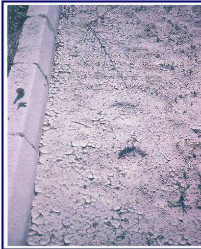
*Figura 3.4.13. Disposición de los sólidos en suspensión que lleva el agua.*
