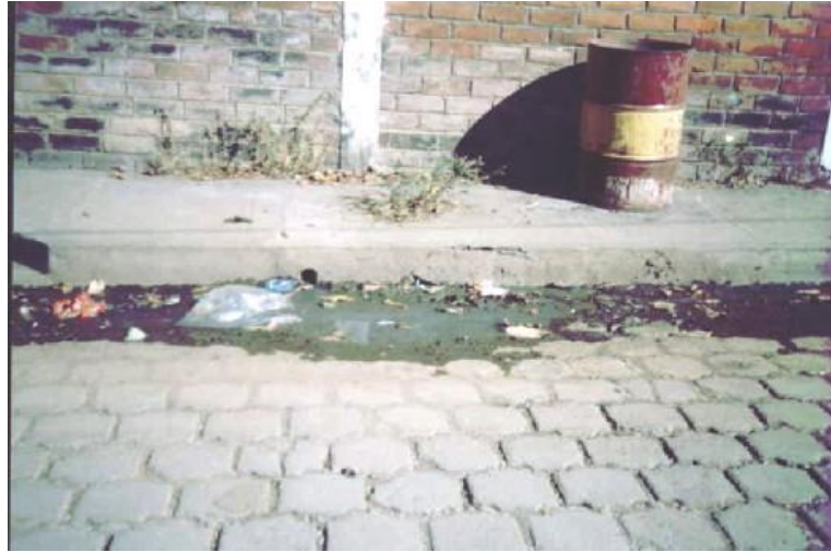
Fotografía 2.1: En la fotografía se puede observar como las aguas desechadas del uso doméstico son arrojadas directamente a las calles, generándose estancamientos.
