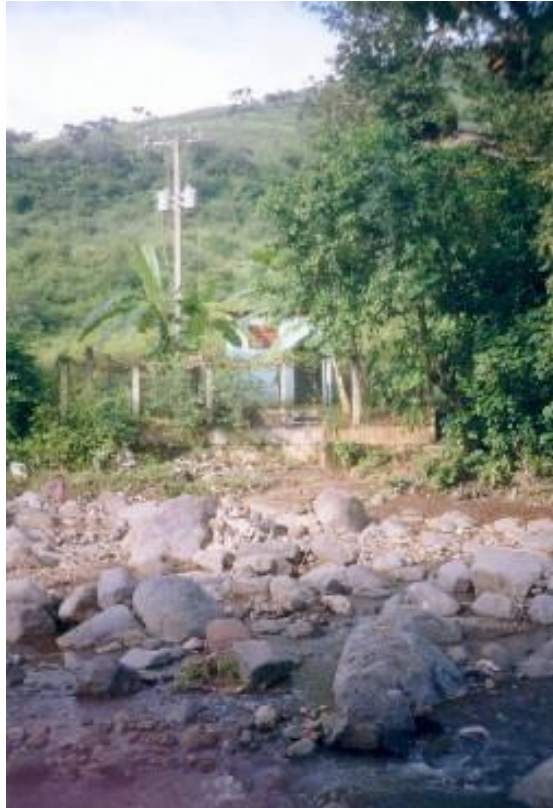
Fotografía 6.5: La fotografía muestra una de las estaciones de bombeo de agua potable, ubicada aguas abajo del punto de descarga propuesto.
