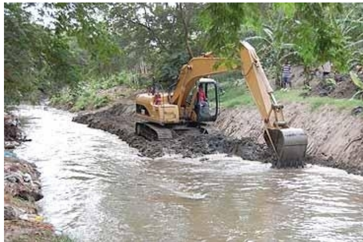
Fotografía 6.4: Pala mecánica utilizada para la rectificación del cauce de un río.
