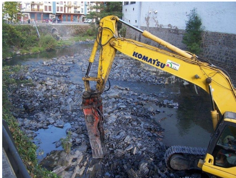
Fotografía 6.3: Pala mecánica utilizada para el dragado de troncos del cauce del río Oria en Beasain, España.
