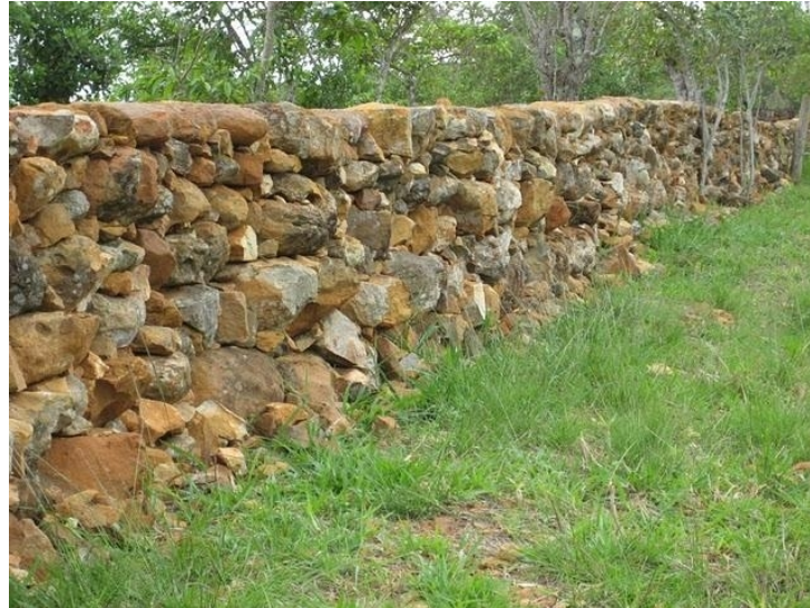
Fotografía N° 6.9. Muro de piedras
