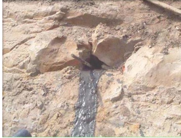
Fotografía 6.12. Detalle de método Soil Nailing
