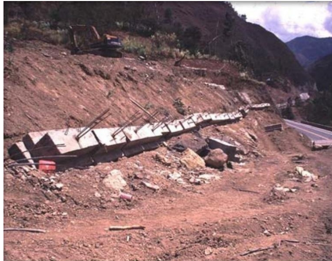
Fotografía 6.11. Esquema de estructuras ancladas.
