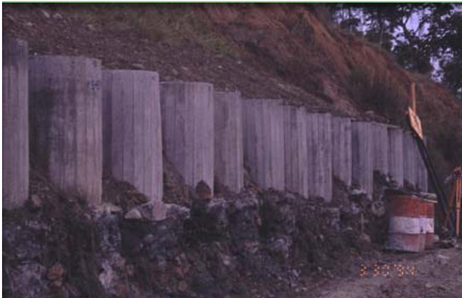
Fotografía 6.15. Esquema del planteamiento de una pila como muro de contención.
