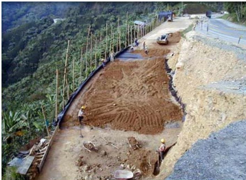
Fotografía 6.10. Estructuras de tierra reforzada.
