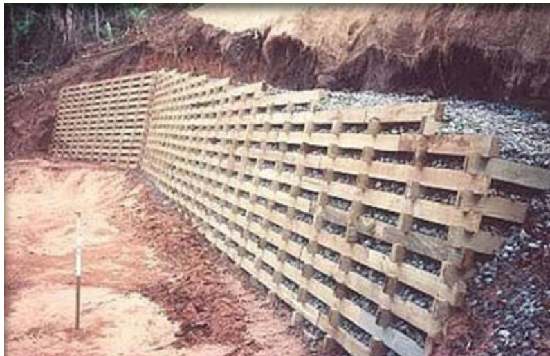
Fotografía 6.8. Esquema general de los muros criba.
