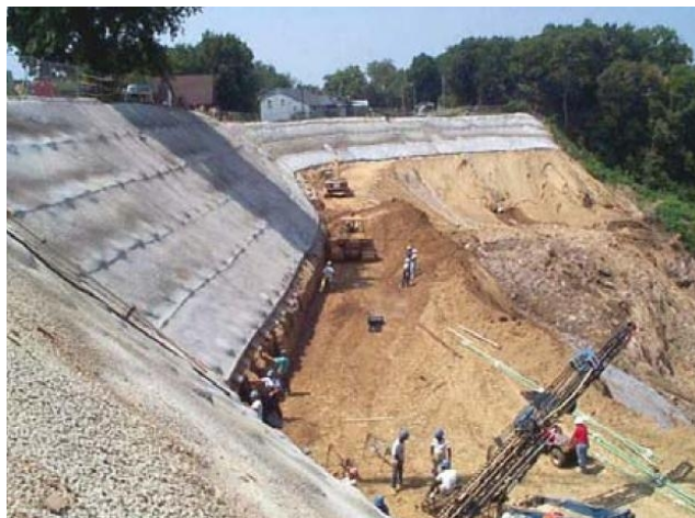
Fotografía 6.13. Esquema terminado de Soil nailing.
