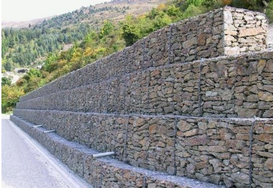
Fotografía 6.7. Esquema de un muro de gaviones.
