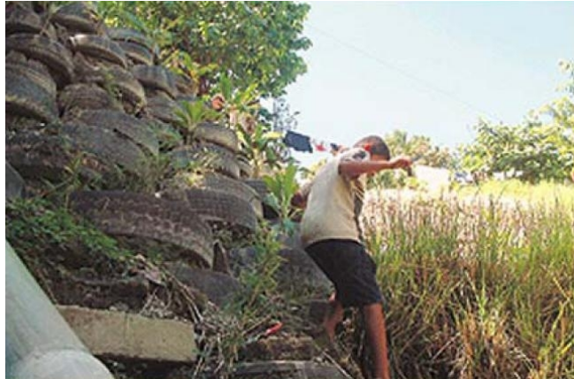
Fotografía 6.6. Muro de llantas, ejemplo de muro flexible.
