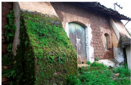
Vista lateral del templo, observese el acceso lateral y los contrafuertes.
