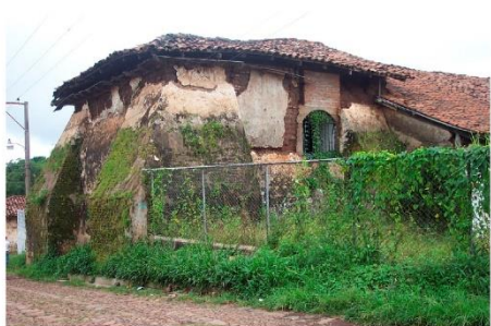
Vista del Abside, la cual presenta daños graves, los cuales fueron causados por los sismos del año 2001.
