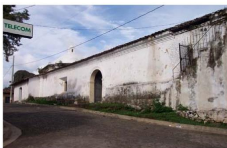
Vista de la Fachada Norte.
