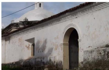
Detalle del acceso ubicado en la fachada Norte.
