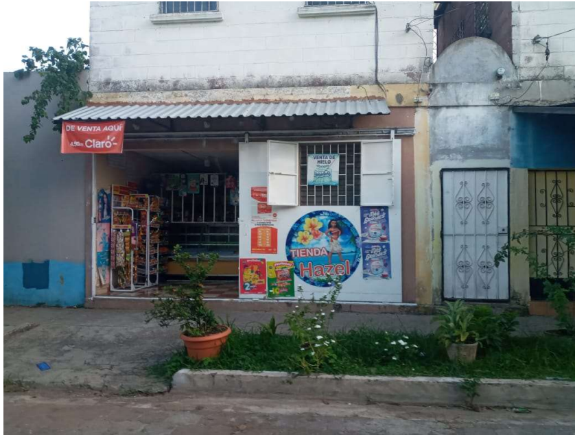
Fotografía 4. Uso Mixto (Comercio En El Primer Nivel y Vivienda en el Segundo Nivel)
