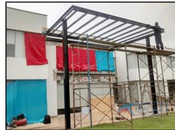
Ilustración 7. Estructura metálica de techo. Fuente: <https://www.macart.com.pe/proyectos/techometal.php>
