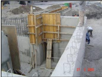
Ilustración 6. Encofrado de paredes de concreto. Fuente: <http://mispreciosunitarios.blogspot.com/2009/01/conceptos-por-uot-pisos-losas-muros.html>
