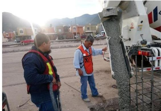
*Ilustración 10/ colado de zapata aislada. Ref. imagen ilustrativa de Rodos Construcción #602849*
