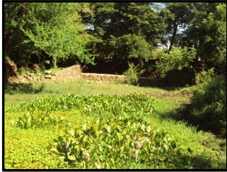
Fotografía 3.8 Muro de Obstrucción. Construido hace mas de 20 años funcionaba como vertedero y evitaba que los peces se escaparan. Obstruye la conexión entre el Río La Pelota y la Laguna de Olomega
