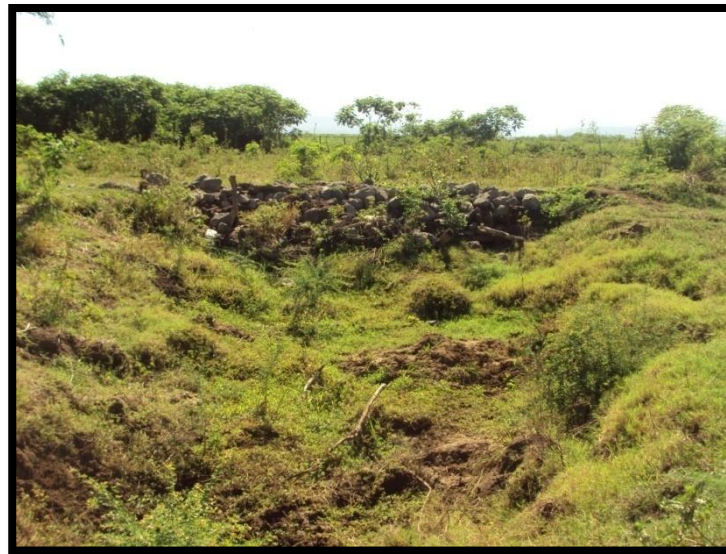
Fotografía 3.7 Obstrucción en el cauce. Los dueños de las tierras por donde pasa el desagüe alternativo lo han obstruido para evitar que la laguna les siga erosionando el suelo.
