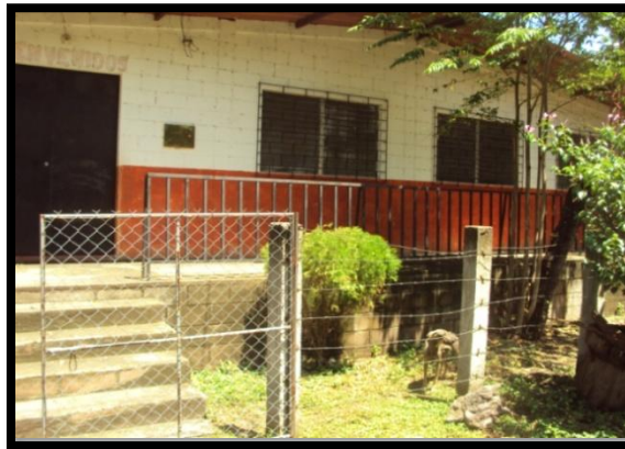
Fotografía 5.3 Albergue Centro Comunitario en la comunidad caserío la Pelota, Financiado por APSIES 76 y Comunidad Suiza.
