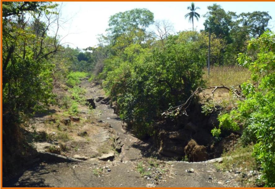
**Figura 4-34, Vista panorámica hacia aguas abajo del dique donde es notable el descenso de nivel del lecho de la quebrada.**
