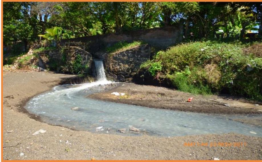
**Figura 3-14, Punto de descarga de aguas residuales del Municipio de El Tránsito sin tratamiento debido, generando problemas de contaminación. (Noviembre 2011).**
