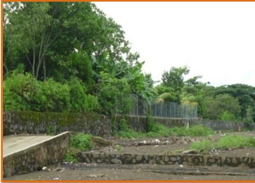
**Figura 2-31, Muro construido en el Municipio de San Jorge para evitar el ingreso de la corriente de agua al casco urbano. Septiembre 2011**
