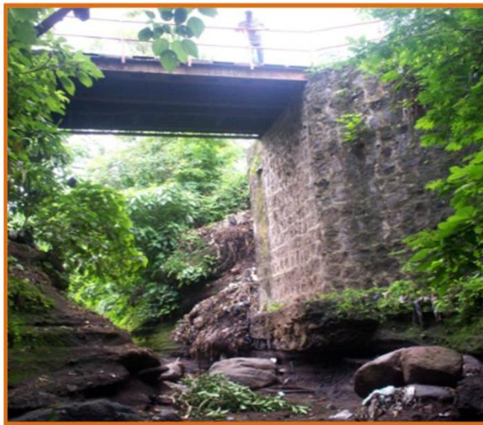
**Figura 2-11, Erosión en la base del estribo de un puente que conduce hacia el Cementerio Municipal del Municipio de San Jorge. Junio 2011**
