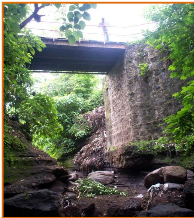
**Figura 4-22, En la imagen anterior y en esta se aprecia el alto grado de socavación presente en los estribos del puente dejándolo propenso a colapsar.**
