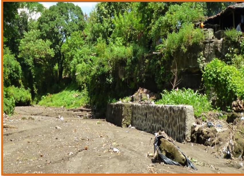
**Figura 2-32, Muro Longitudinal construido sobre la Quebrada El Tránsito para la defensa de las viviendas en la ribera. Septiembre 2011.**
