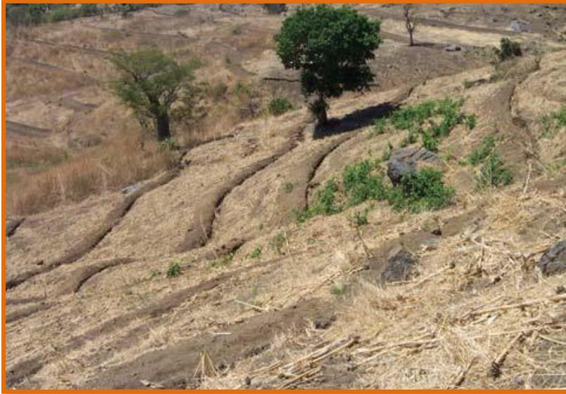
**Figura 4-3, Zanjas de ladera recién construidas en la cuenca alta de la Quebrada El Transito, se observa el suelo extraído depositado hacia abajo de la zanja.**
