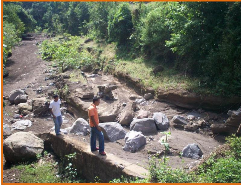
**Figura 4-24, Vista hacia aguas abajo del dique, se aprecia la erosión que se tiene presente y las rocas de grandes dimensiones que son las únicas que mantienen el nivel de la base del dique**
