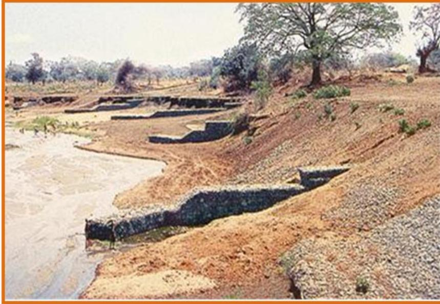
**Figura 2-23, Espigón con su extremo inclinado en dirección al curso de agua.**
