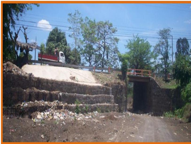
**Figura 1-3 Construcción de muro gavión para protección de Puente en la intersección con la Carretera El Litoral.**
