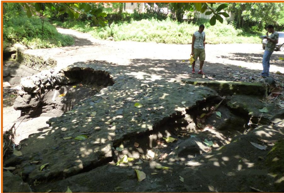
**Figura 4-38, Al fondo se observa el camino que es protegido por esta obra, al colapsar quedaría inhabilitado el paso vehicular y peatonal hacia los caseríos de la zona.**
