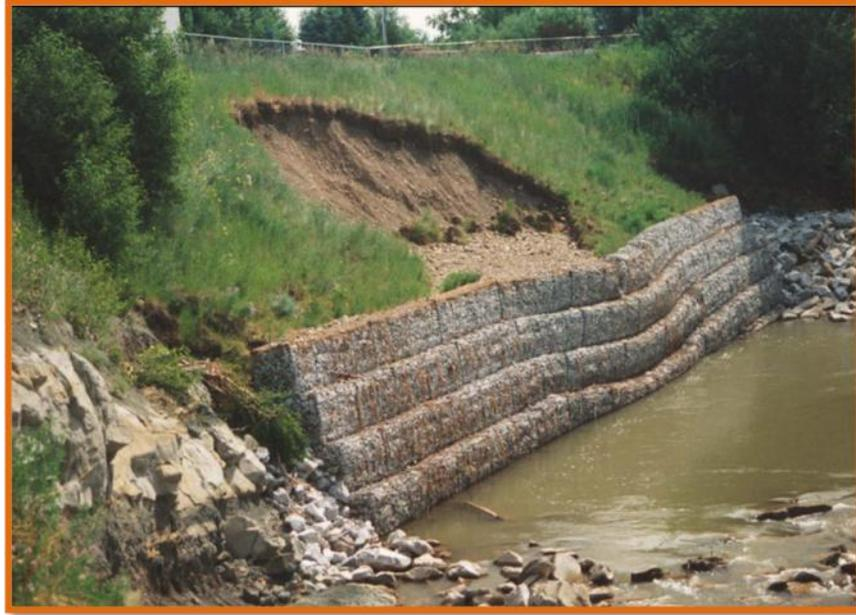
**Figura 2-17, Con el colapso del talud el gavión simplemente se deforma.**
