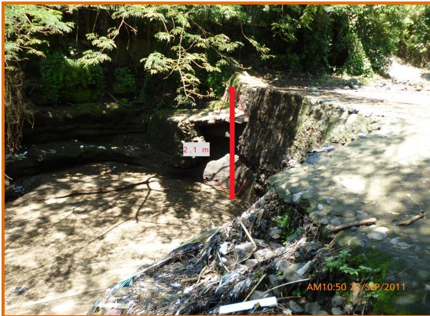
**Figura 4-35, Vista lateral donde se puede notar la altura total del dique el mal estado en el que se encuentra.**
