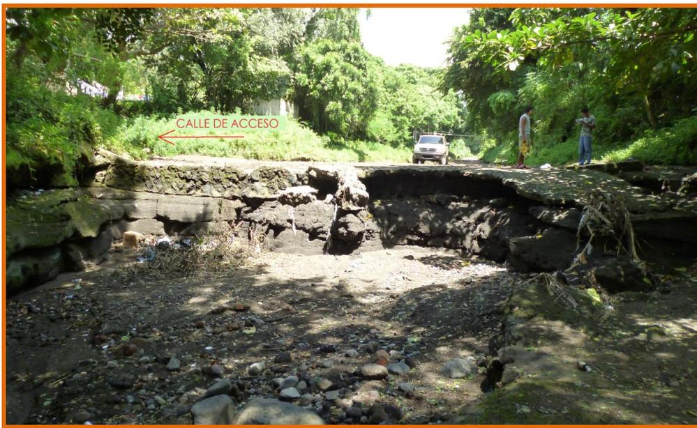
**Figura 4-36, Esta obra se puede notar el mal estado ya que ha perdido gran parte de su estructura por el paso del agua.**
