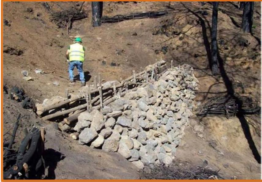
**Figura 2-45, Barrera construida para retener sedimentos en los terrenos.**
