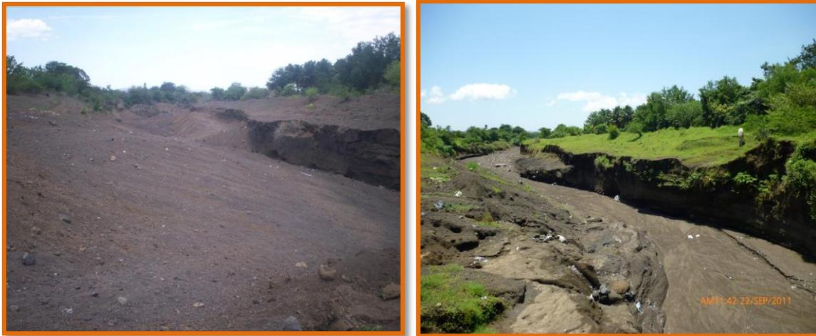
**Figura 4-54, La imagen izquierda fue captada cuando era conformada la borda con un tractor de banda, a la derecha se observa luego del paso del invierno.**
