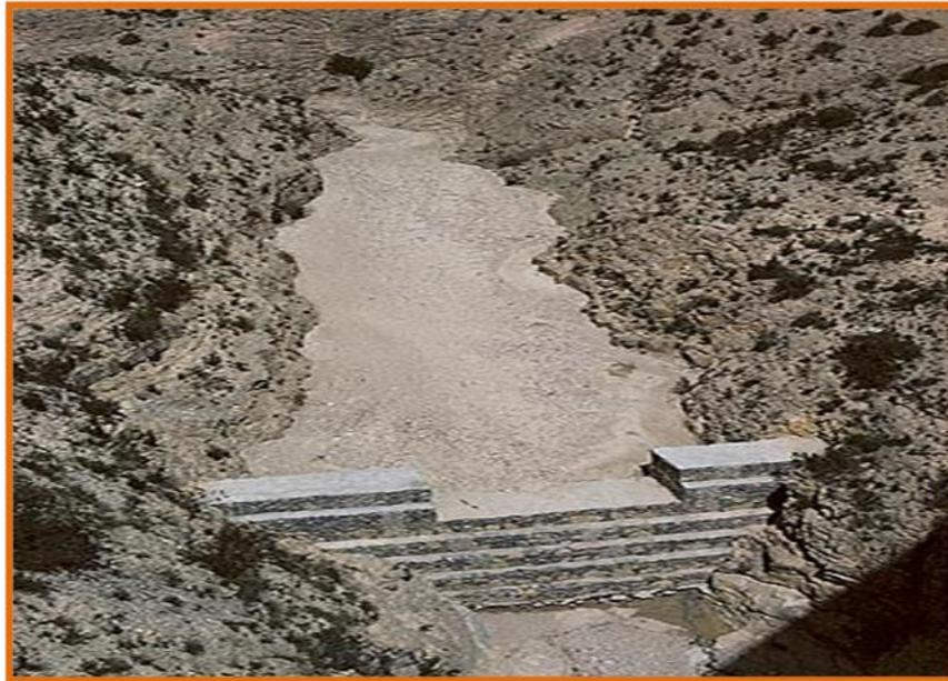
**Figura 2-29, Dique de retenida de sedimentos \***.
