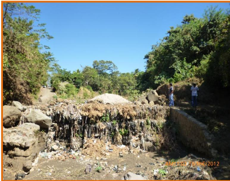
**Figura 4-23, Este dique de Mampostería Gavionada ha sufrido desprendimientos de rocas producto del deterioro de la malla que lo compone.**
