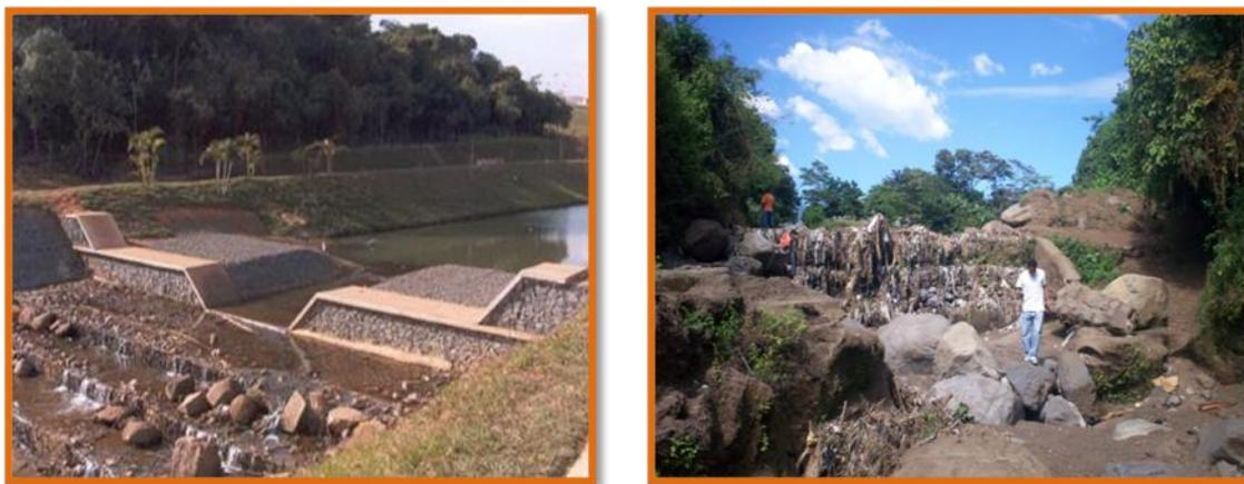
**Figura 2-21, La figura izquierda muestra un dique de gavión con recubrimiento de concreto y a la derecha un dique construido sobre la Quebrada El Tránsito con alto contenido de desechos\*.**
