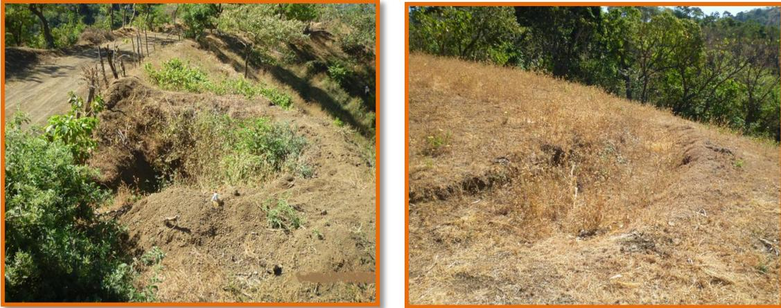
**Figura 4-5, A la izquierda se observa un pozo de infiltración sin mantenimiento al igual que a la derecha se tiene una zanja de ladera sin extraerle el material depositado dentro de ella.**
