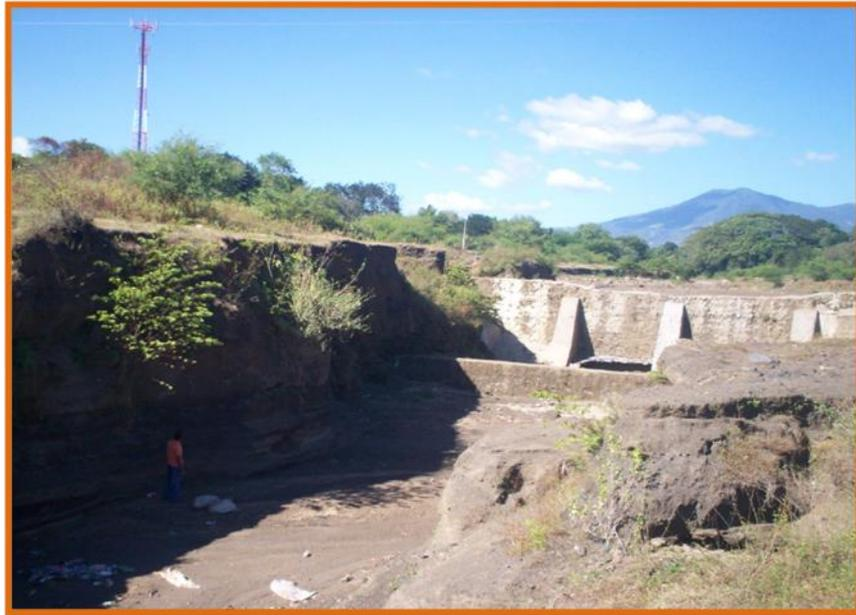
**Figura 2-12, Erosión aguas abajo de un dique sobre La Quebrada El Tránsito en el límite entre los Municipios de San Rafael Oriente y El Tránsito. Marzo 2011.**
