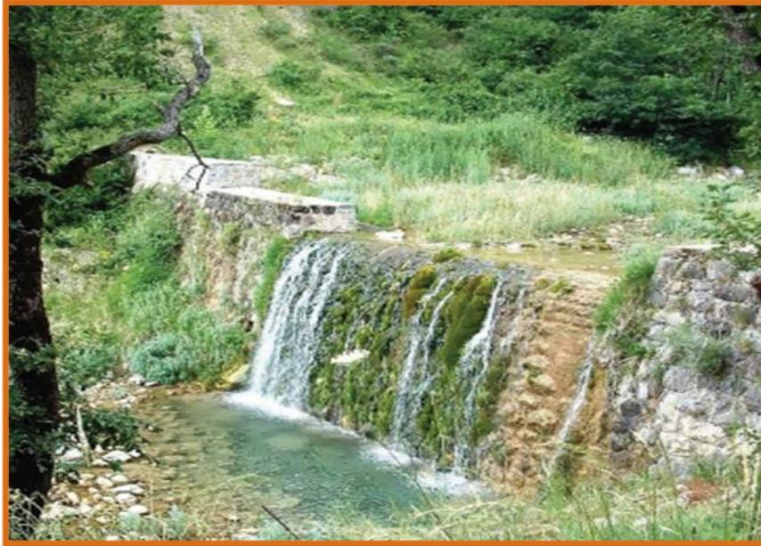
**Figura 2-28, La menor pendiente del aterramiento formado disminuye la velocidad del agua y su capacidad de erosión.**
