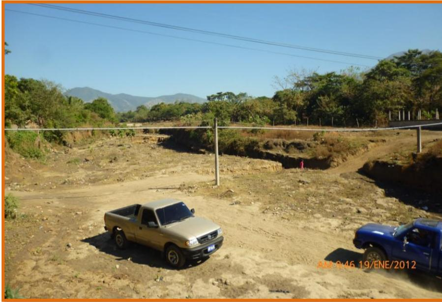
**Figura 4-40, Vista hacia el Norte desde la 4ª Ca Oriente, se aprecia la formación de cárcavas a lo largo de este tramo.**
