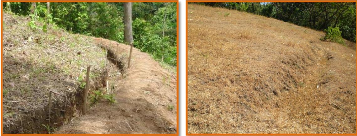
**Figura 4-4, La imagen izquierda muestra una zanja con poco tiempo de ser construida y a la derecha ya con cobertura vegetal que ayuda a evitar su propia erosión.**
