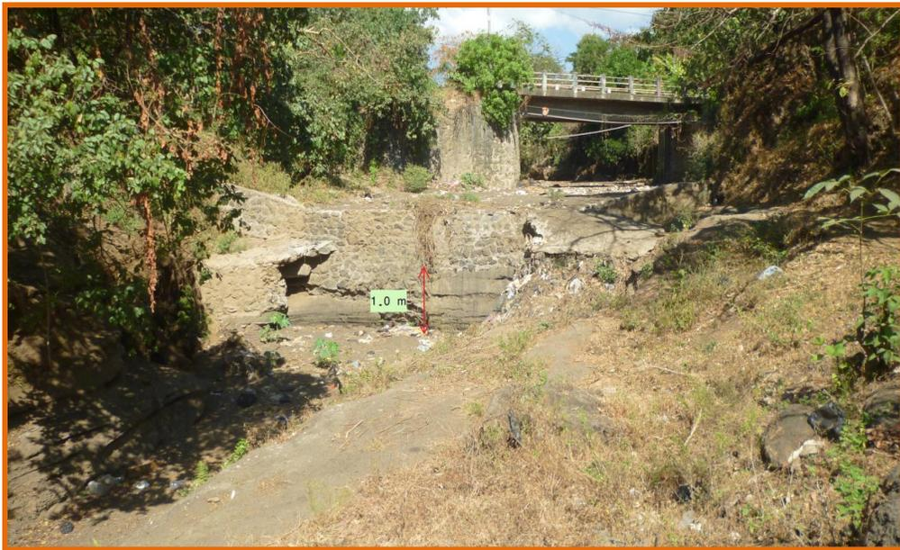
**Figura 4-33, Este dique fue construido para mantener el nivel de la base del puente que se observa al fondo de la figura.**
