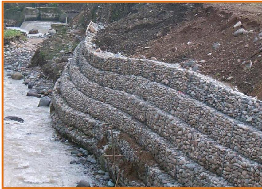
**Figura 2-15, Estructura gruesa de tipo Gavión Caja.**
