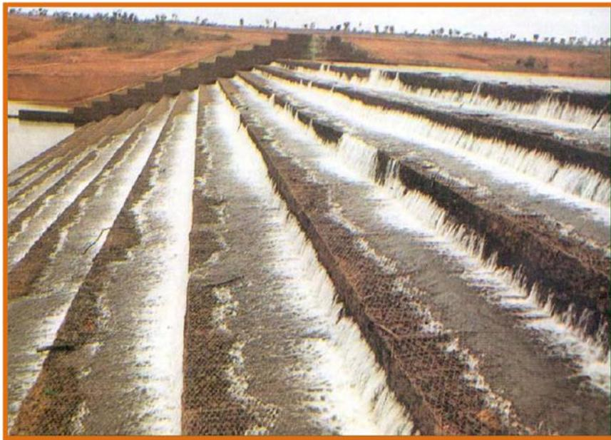
**Figura 2-26, Escaleras disipadoras de energía para cambios bruscos de nivel \*.**
