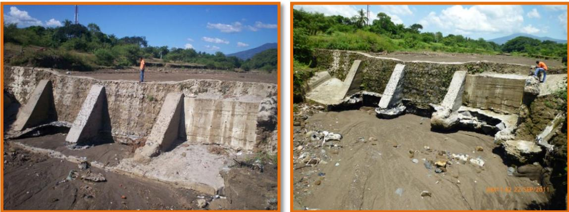
**Figura 4-44, Imágenes comparativas donde se presenta el deterioro sufrido por la estructura con el paso de un invierno, la figura izquierda fue captada a inicios del año 2011 y la derecha en enero del año 2012.**
