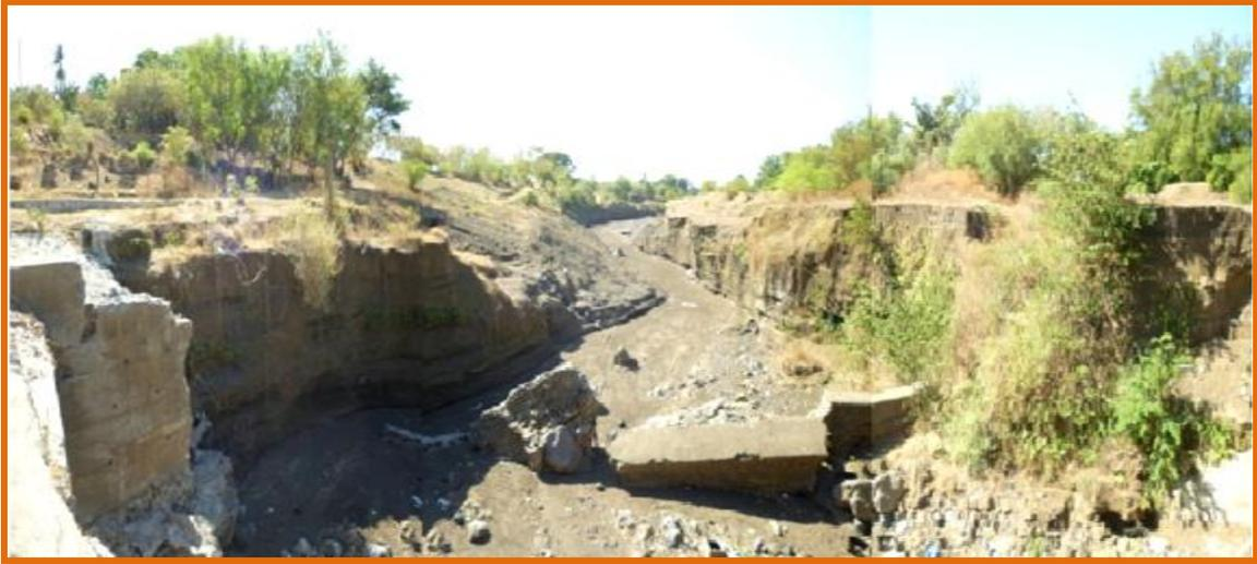
**Figura 4-43, Aguas debajo de la estructura se aprecia el alto grado de erosión debido a exceso de altura que posee la obra sin presencia de disipadores de energía.**
