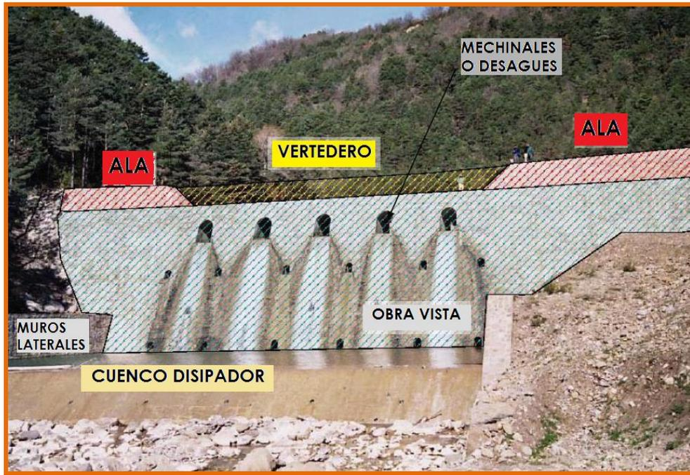
Figura 4-59, Elementos que componen un dique de retenida de sedimentos.
