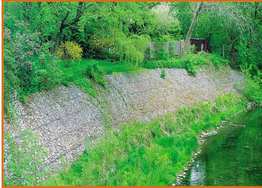
**Figura 2-16, Estructura delgada tipo Colchón.**
