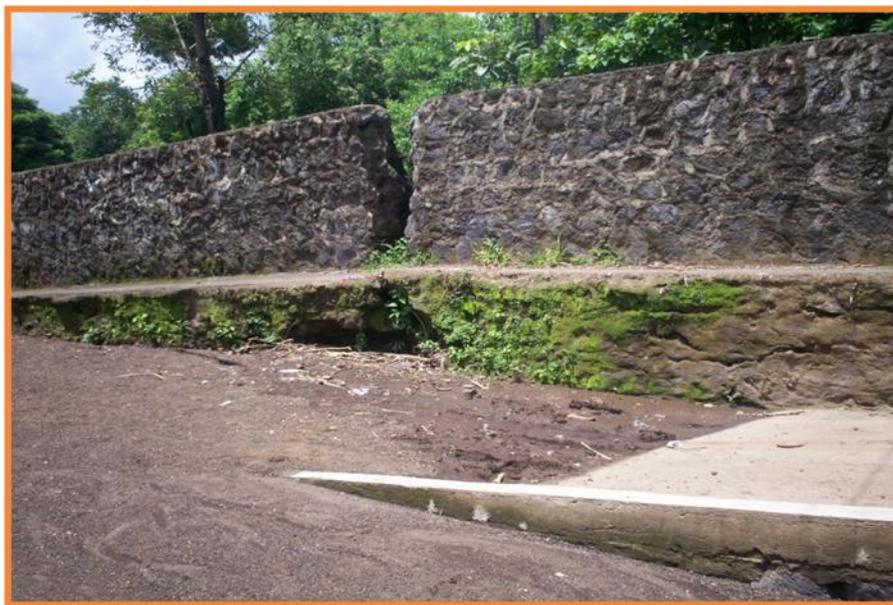
**Figura 3-15, Daños ocasionados a un muro de protección transversal construido en el Barrio Concepción de San Jorge, para evitar el ingreso del agua a las viviendas aledañas. (Junio 2011).**
