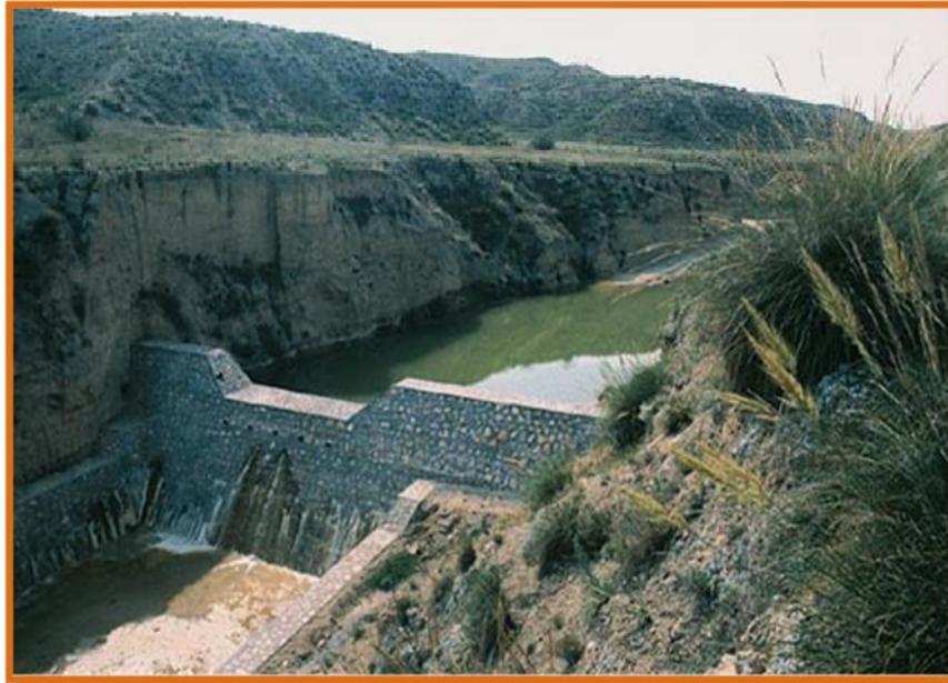
**Figura 2-27, El efecto de embalse provoca el depósito de los sedimentos en el dique.**
