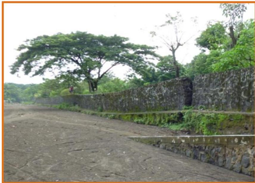
**Figura 2-18, El muro rígido con deformaciones en su base tiende a colapsar.**
