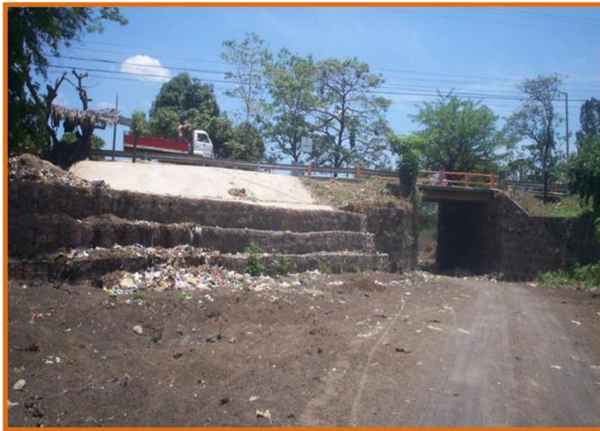
**Figura 2-19, Muro longitudinal de mampostería gavionada construido sobre la Quebrada El Tránsito. Mayo 2011.**
