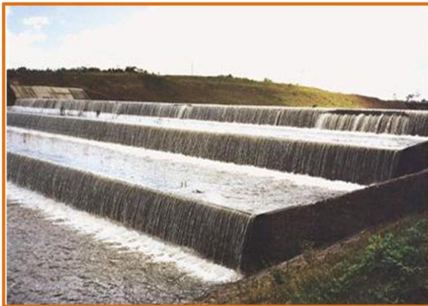
**Figura 2-25, Gradas disipadoras de energía.**
