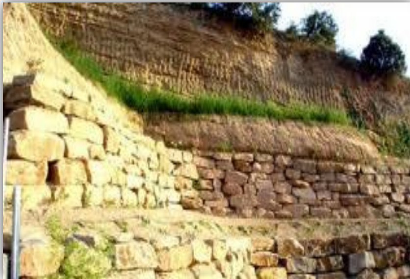
Fotografía 6.10: Muro de piedra.
