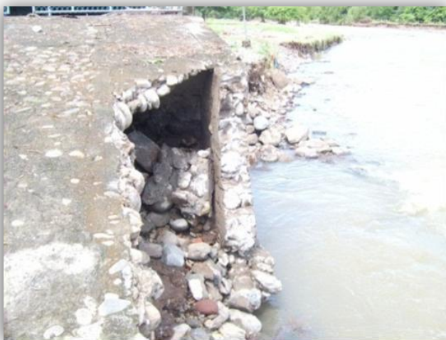
Fotografía 4.4 Obstrucción de tuberías de aguas negras Fuente: Grupo de Investigación
