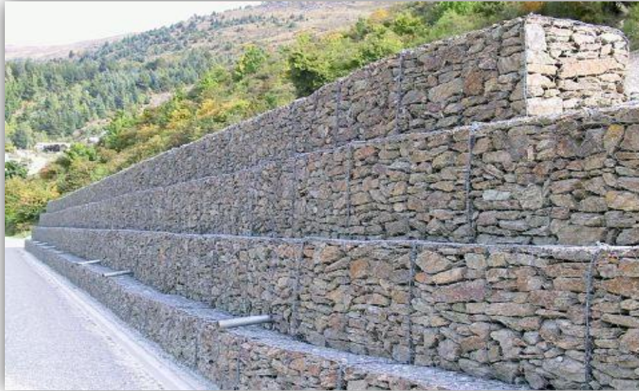
Fotografía 6.8: Muro de Gaviones.
