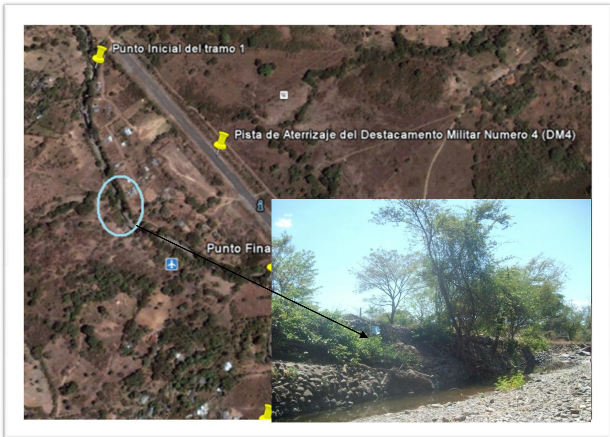
Figura 6.16 Ubicación del muro de gavión Colonia La Prado
