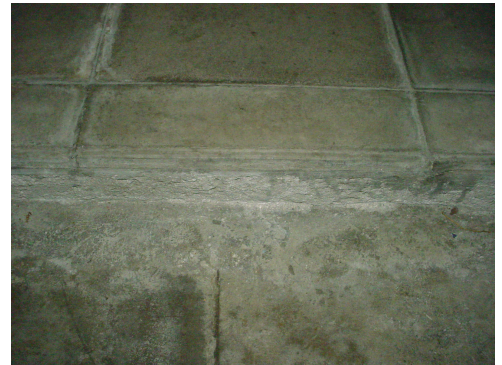
TERMINACIÓN DE PISO CON ZÓCALO
