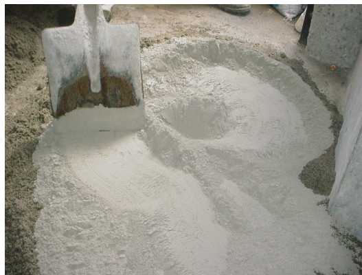
Mezcla de la arena con el cemento.
