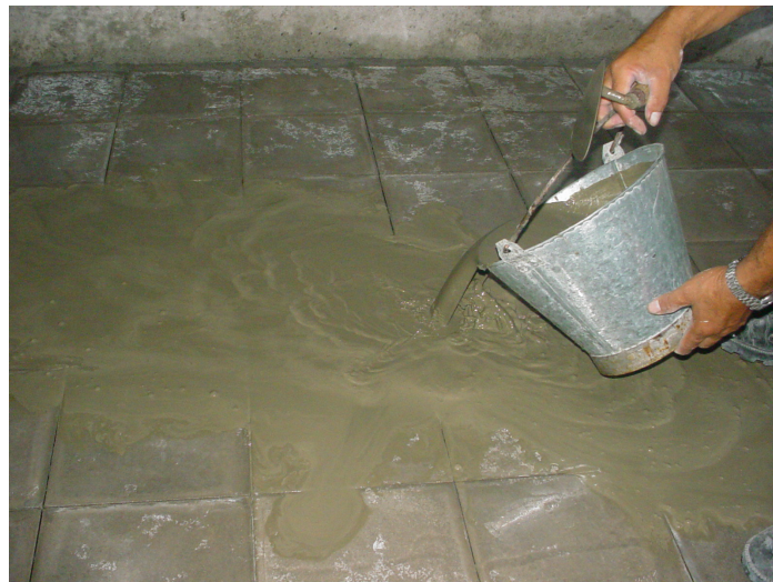
Aplicación de la pasta en la superficie enladrillada.
