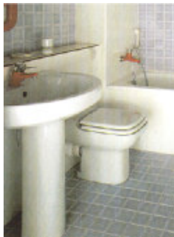
Fig. 1.1 Detalle de la instalación de un cuarto de baño.
