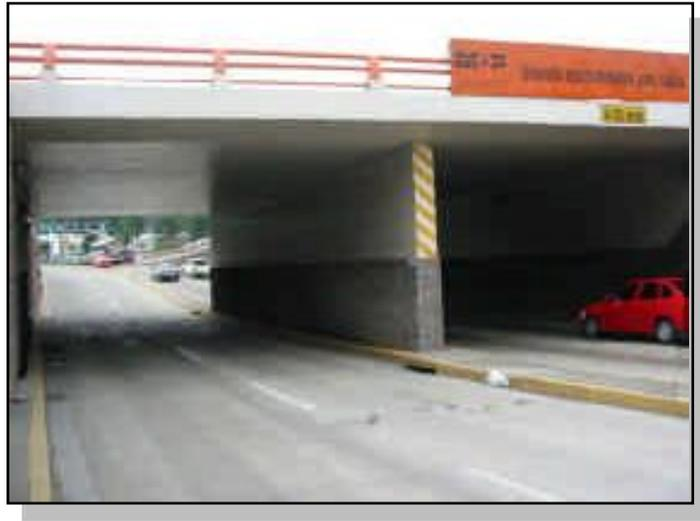
**Figura. 2.8** Pila Tipo Pared.
