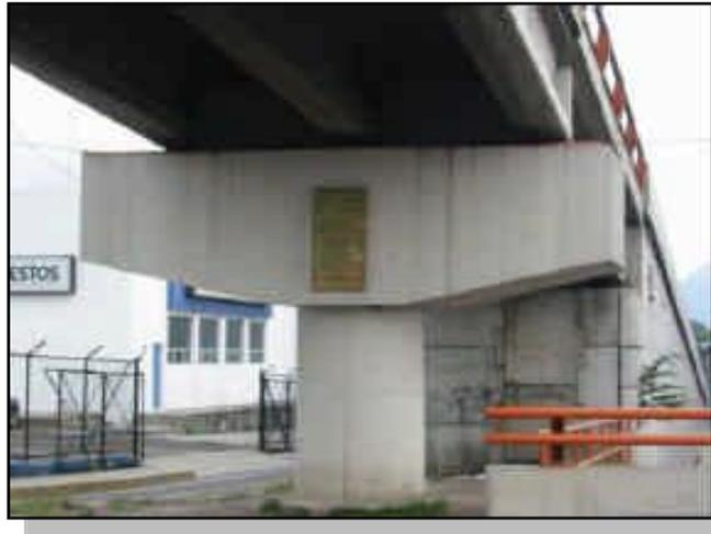
**Figura. 2.9** Pila Tipo Cabeza de Martillo.
