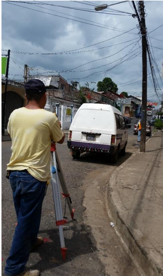
Figura 20. Levantamiento de datos en calles y avenidas.
