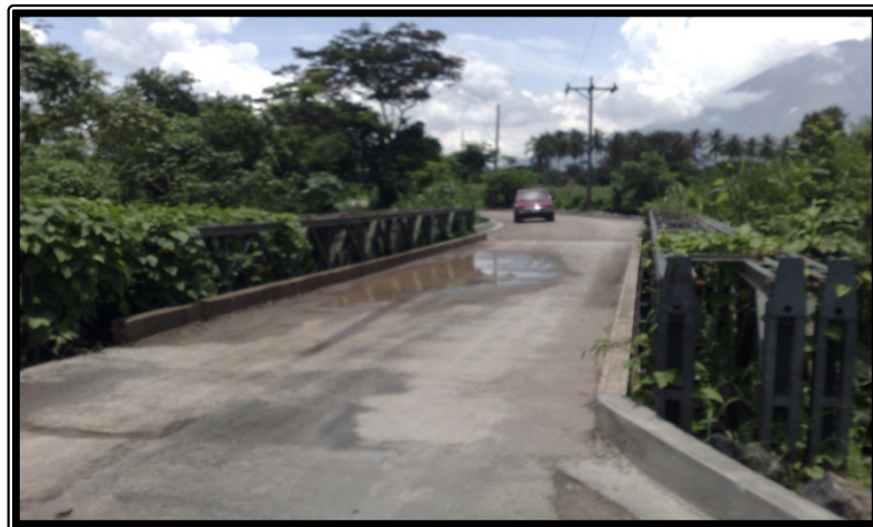
FIGURA 3.3.1.4: Acceso a la zona por medio de la carretera Litoral.
