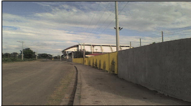
Figura 9: Infraestructura existente en la zona.
