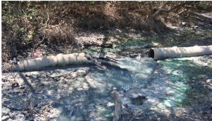
**Figura 3.1:** Tubería rota de aguas negras identificada en el Estero Los Mancornados cuyo efluente llega directamente a Puerto El Triunfo, sobre todo en mareas altas.
