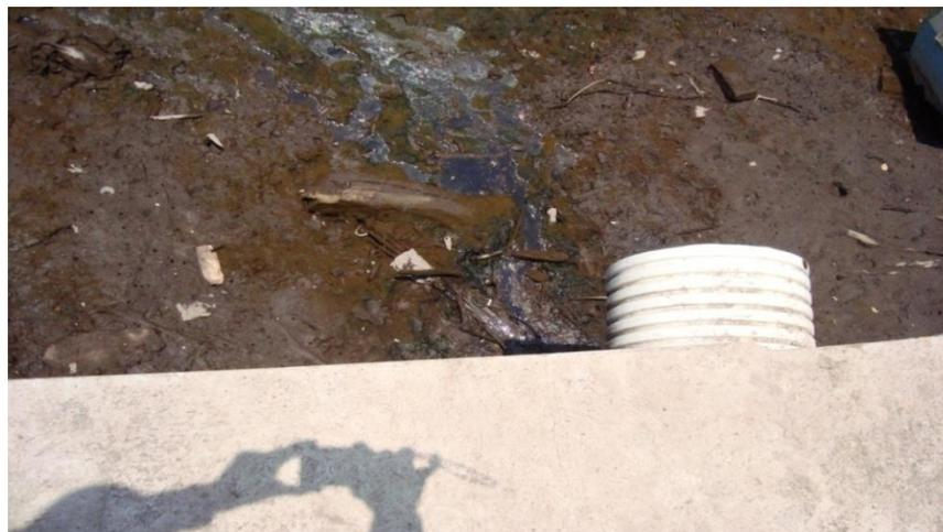
**Figura 3.2:** Tubería de aguas residuales domesticas identificada en Puerto Avalos cuyo efluente llega al río que drena en las aguas de la Bahía de Jiquilisco.
