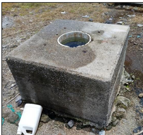
Figura 4.5. PP 9 DRZ, ejemplo de pozo surgente.
