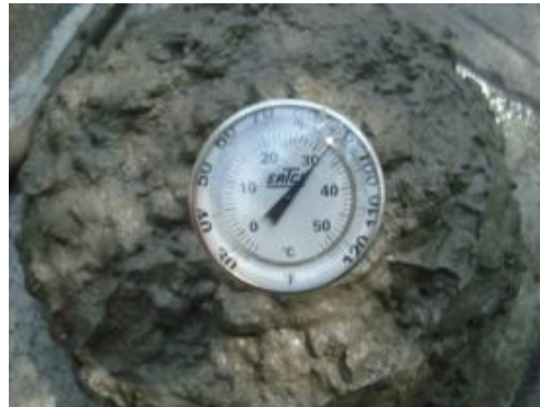
Imagen 3.8. Temperatura de concreto
