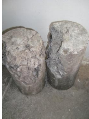
Imagen 3.16. Cilindros de concreto después de la falla
