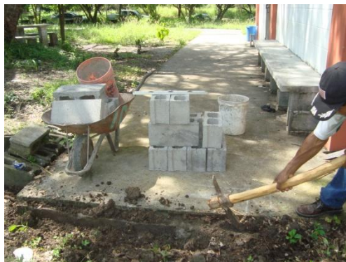
Imagen 6.10. Preparación del suelo
