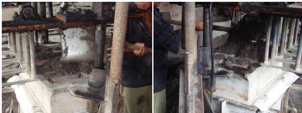
Imagen 6.6. llenado de mortero en los moldes
