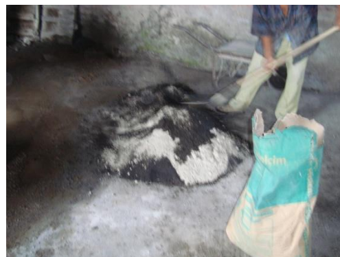
Imagen 6.4. Cuarteo de agregado y cemento
