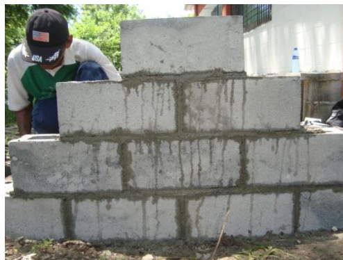
Imagen 6.16. Colocación de bloques
