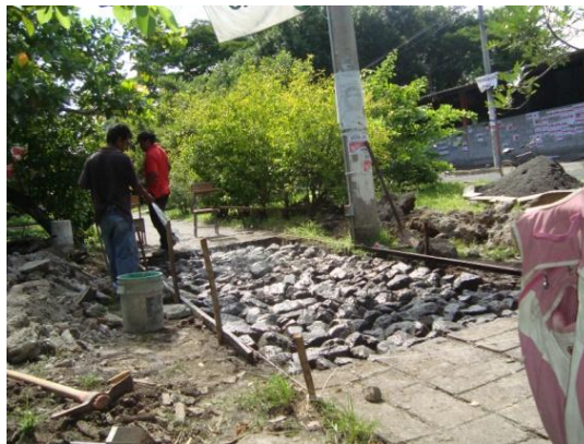
Imagen 5.7 Colocación de piedra cuarta
