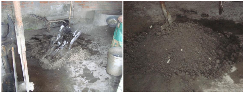
Imagen 6.5. Colocación de agua sobre la mezcla y mezcla preparada
