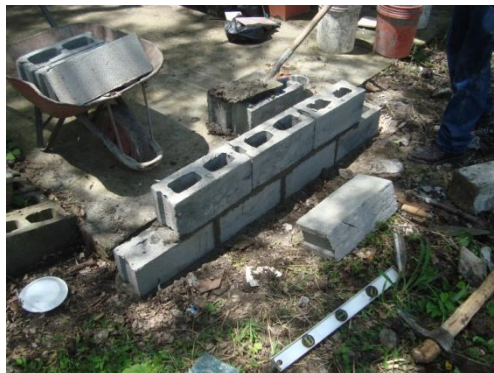
Imagen 6.15. Pegamento de bloques
