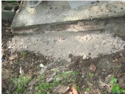
Imagen 6.11. Colocado de material selecto
