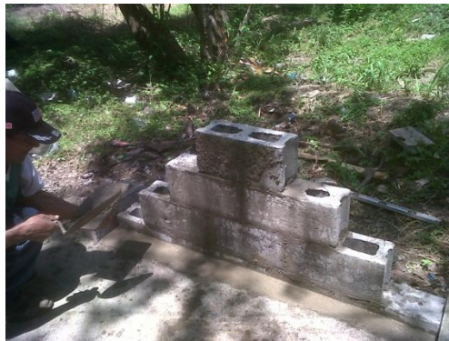
Imagen 6.18. Colocación de primera capa
