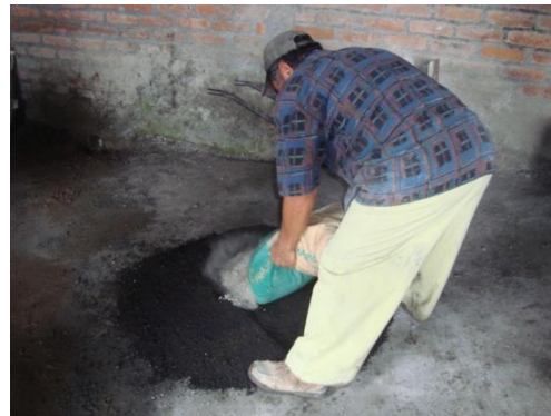
Imagen 6.3. Colocación de cemento
