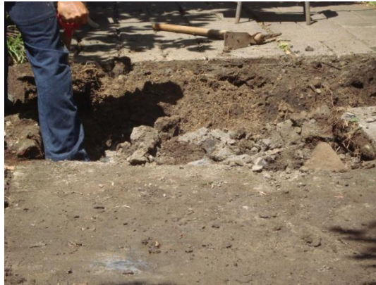
Imagen 5.5 Excavación a mano.
