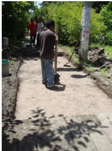
Imagen 5.6 Compactación del material selecto
