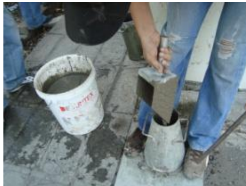
Imagen 3.4. Prueba de revenimiento, llenado de segunda capa
