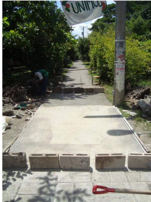
Imagen 5.11 Curado de la superficie terminada.
