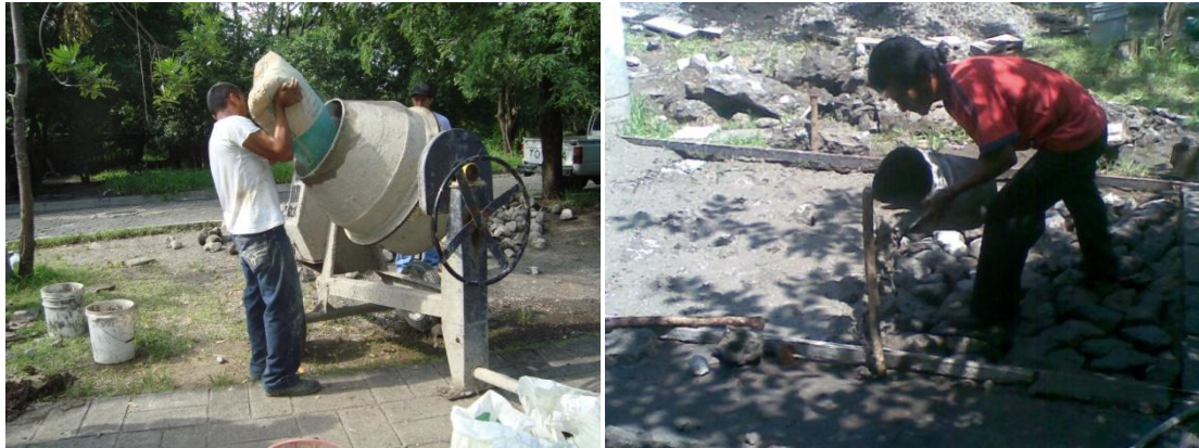
Imagen 5.8 Hechura y colocación de concreto con goma triturada
