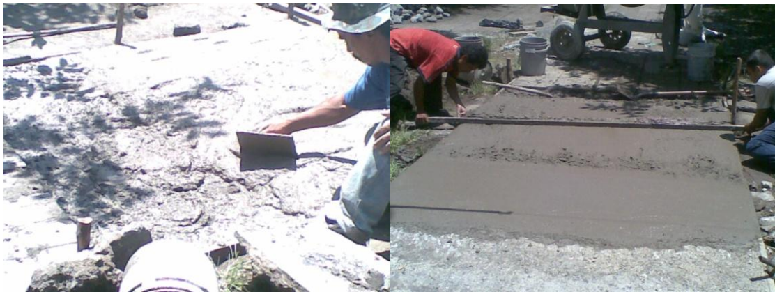
Imagen 5.9 Enrasado de concreto.
