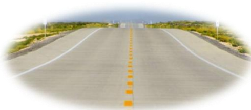
Imagen 2.6. Carretera de concreto
