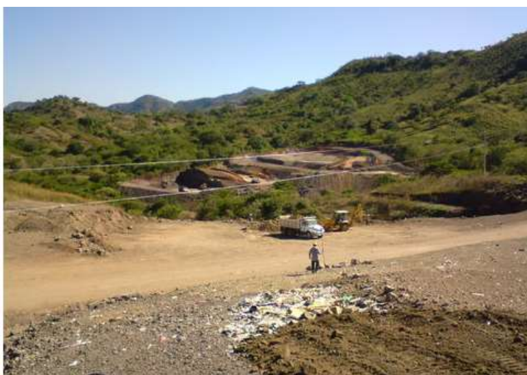
Fotografía 4.11 Calle interna del relleno sanitario.
