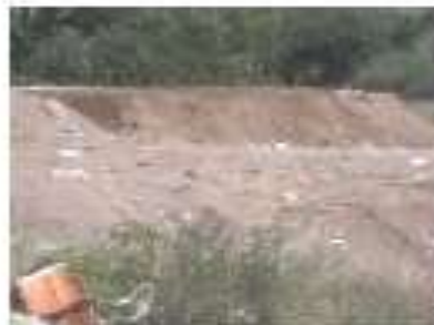
i. Terminación de primera terraza o plataforma
