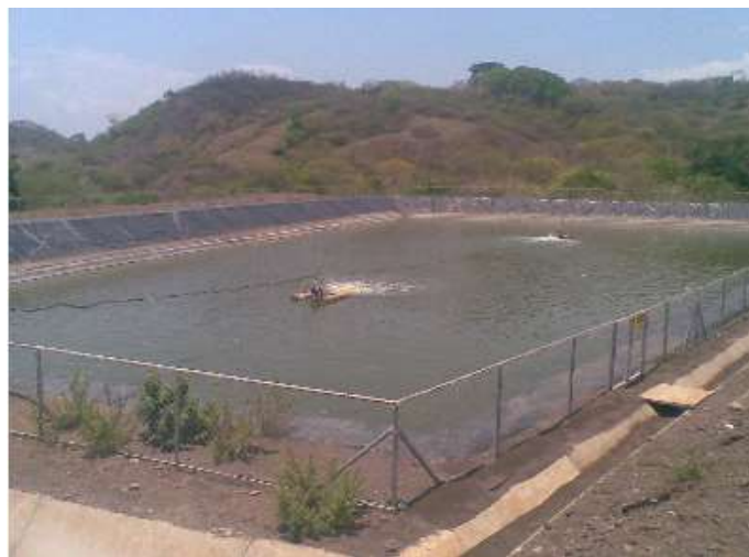
Fotografía 5.4 Laguna de lixiviado.
