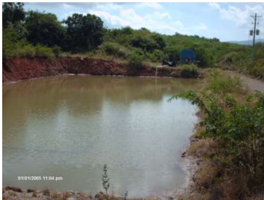
Fotografía 5.10 Pilas de lixiviados en época de invierno.
