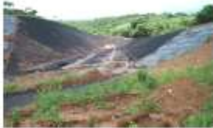
a. Terreno preparado
