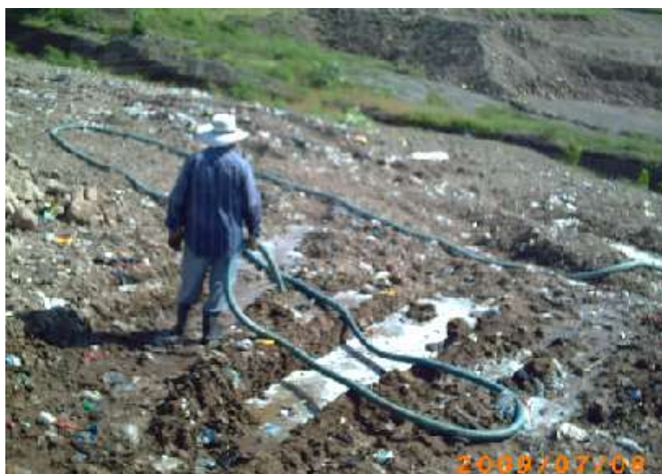
Fotografía 5.16 Auxiliar laborando en la recirculación de lixiviados.
