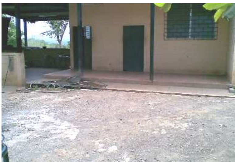
Fotografía 4.4 Caseta de control.
