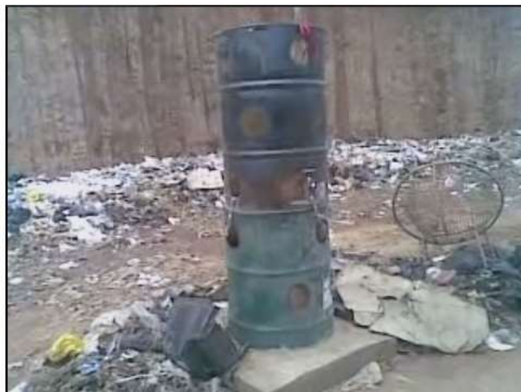
Fotografía 5.3 Chimenea de biogas.
