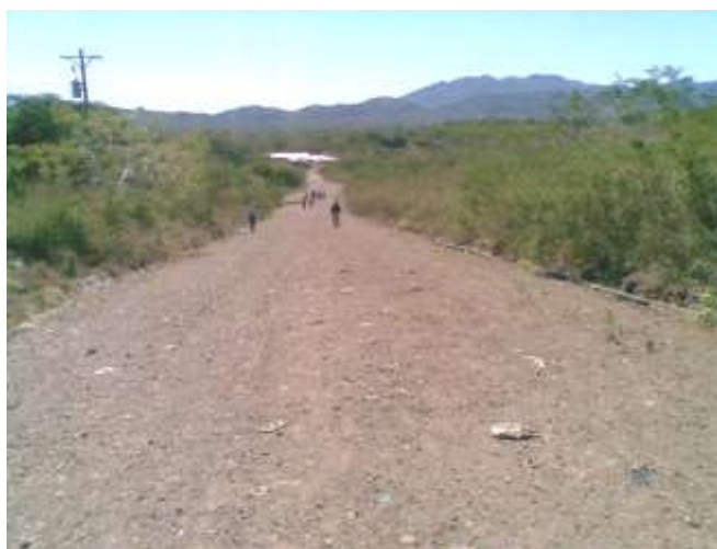
Fotografía 4.24 Calle interna del relleno sanitario.
