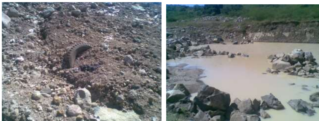
Fotografía 4.32 y 4.33 Situación Actual del relleno sanitario.
