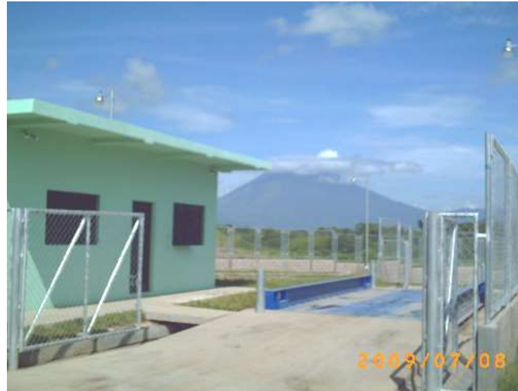
Fotografía 4.36 Caseta de control.
