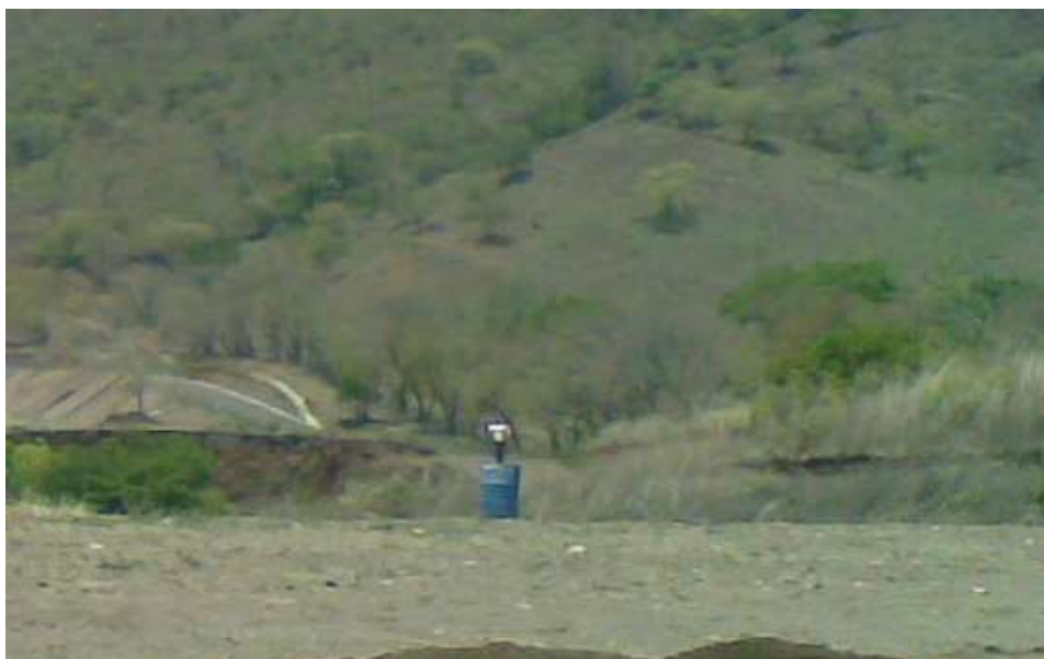
Fotografía 4.21 Vista de Chimenea finalizada.
