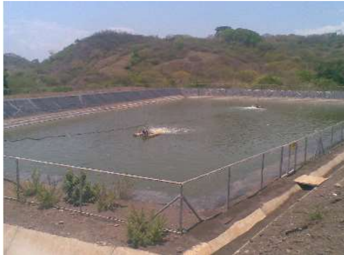
Fotografía 4.20 Laguna de lixiviado.
