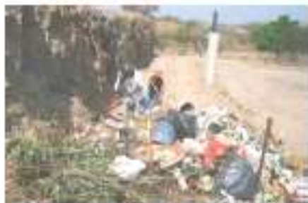
c. Esparcimiento en capas de los residuos
