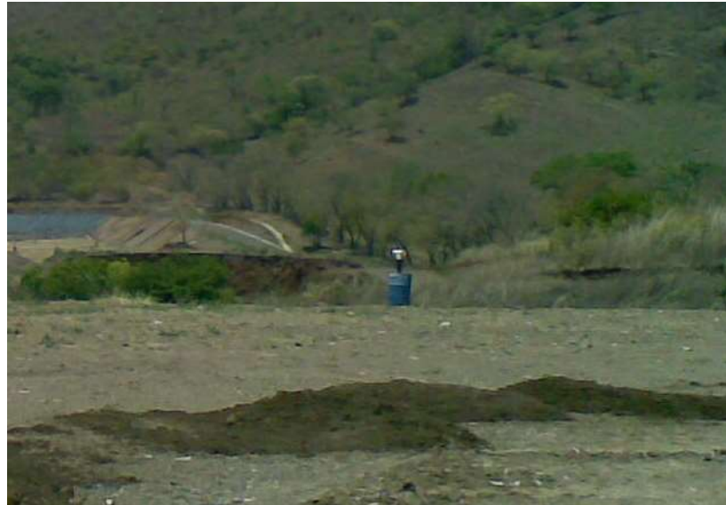
Fotografía 5.5 Vista de Chimenea finalizada.
