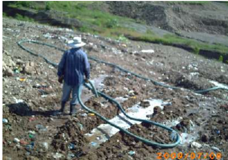
Fotografía 4.42 Auxiliar laborando en la recirculación de lixiviados.
