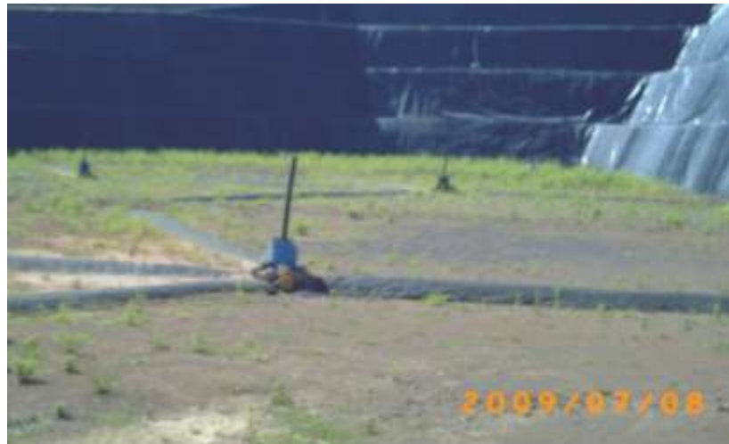
Fotografía 4.40 Vista de Chimenea al inicio de una celda.
