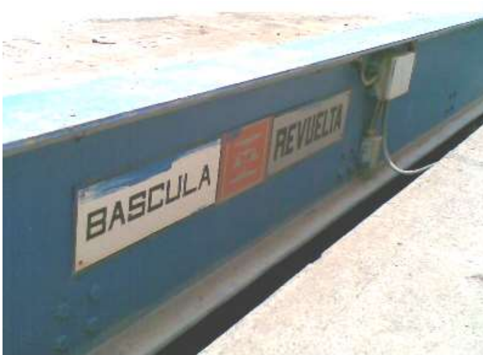
Fotografía 4.2 Bascula con la que cuenta el relleno sanitario.
