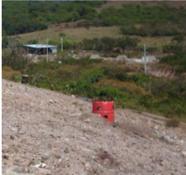
Fotografía 5.11 chimenea de biogas.
