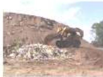
f. Cobertura con tierra al final de la jornada
