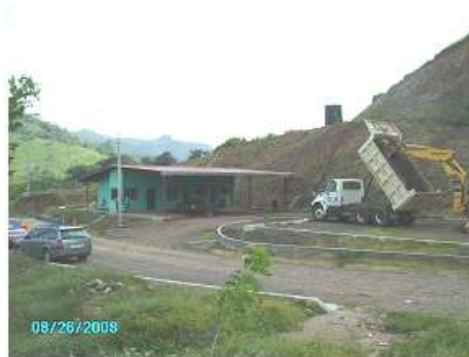
Fotografía 4.13 Caseta de control.
