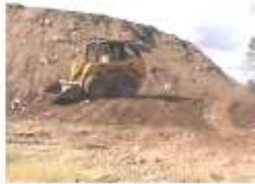
g. Compactación de material de cobertura
