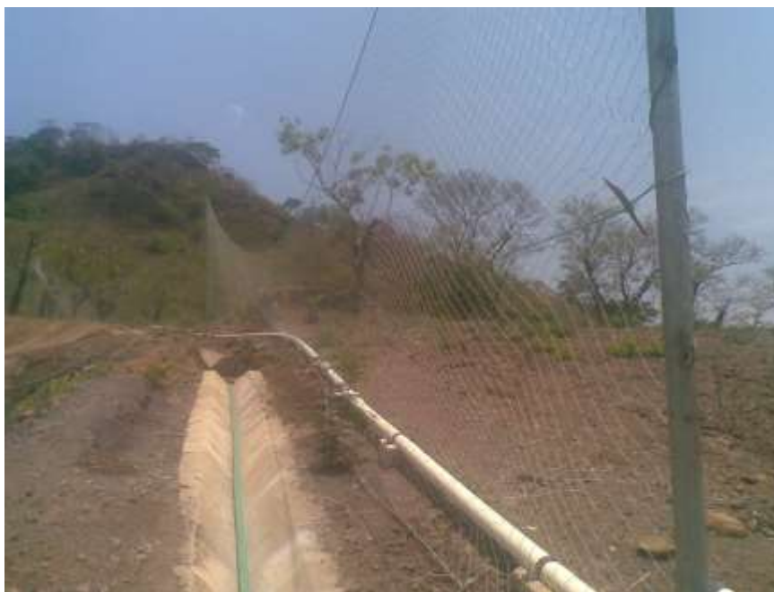
Fotografía 4.14 Mampara ubicada al costado Este del relleno sanitario.
