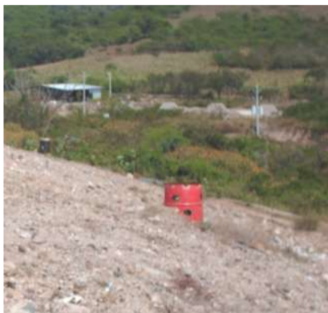
Fotografía 4.31 chimenea de biogas.
