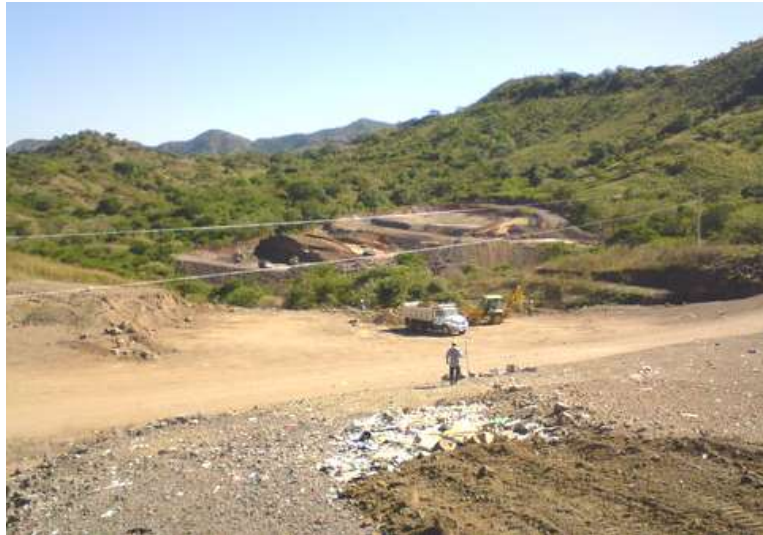
Fotografía 2.4 Relleno sanitario ASINORLU.
