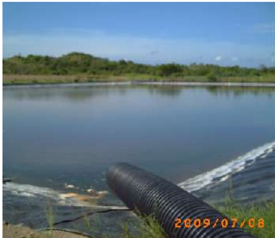
Fotografía 5.14 Laguna de lixiviado.
