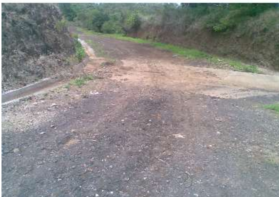
Fotografía 4.1 Calle interna del relleno sanitario.
