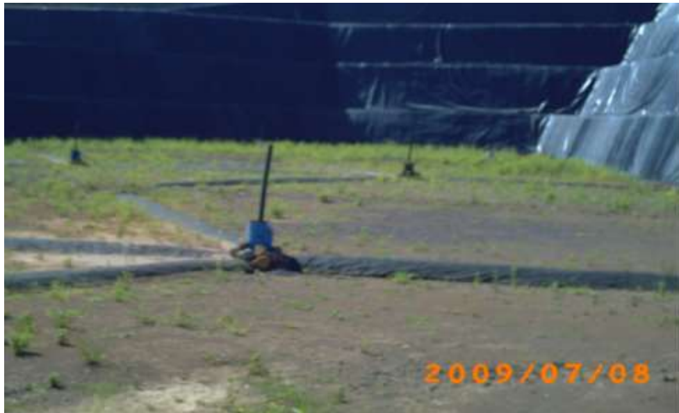
Fotografía 5.15 Vista de Chimenea al inicio de una celda.
