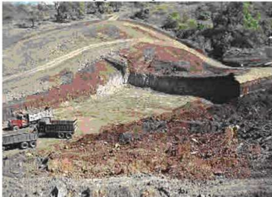
Fotografía 2.6 Construcción del relleno sanitario de Usulután.
