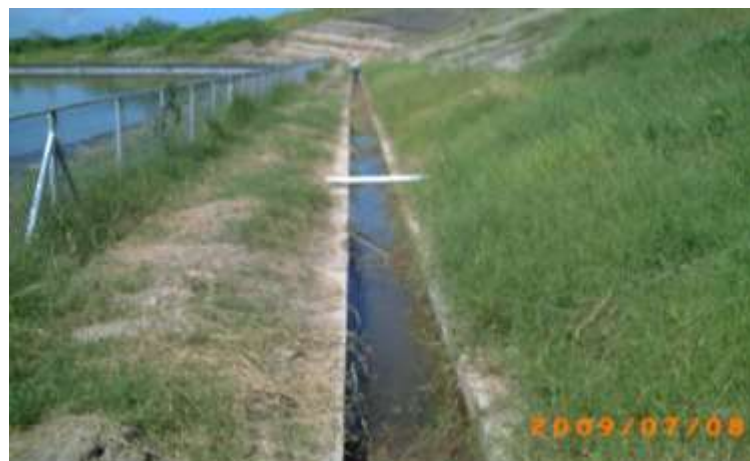
Fotografía 4.43 Canaleta perimetral de la laguna.
