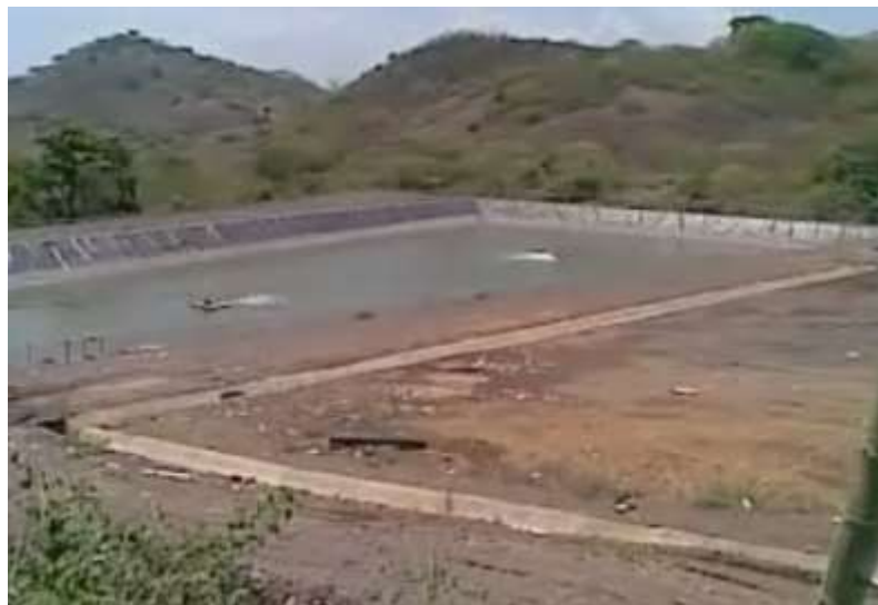
Fotografía 4.16 Canaletas para drenar las aguas lluvias.
