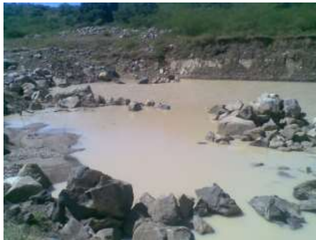
Fotografía 5.13 Situación Actual del relleno sanitario.
