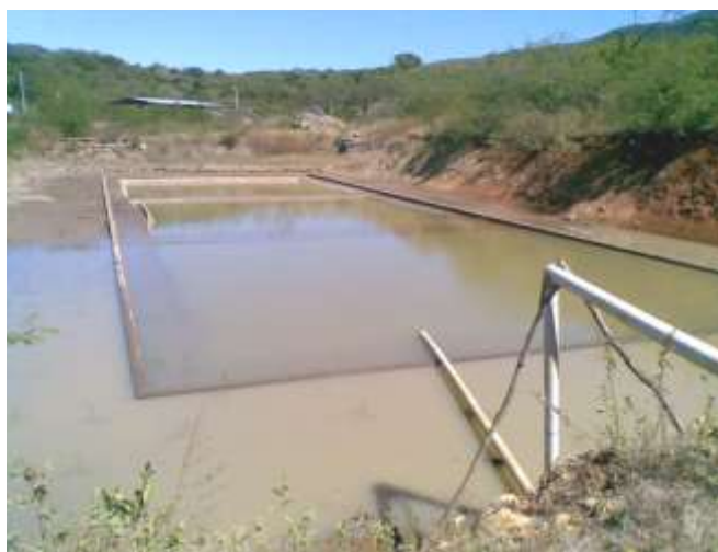
Fotografía 4.29 y 4.30 Pilas de lixiviados en época de invierno.
