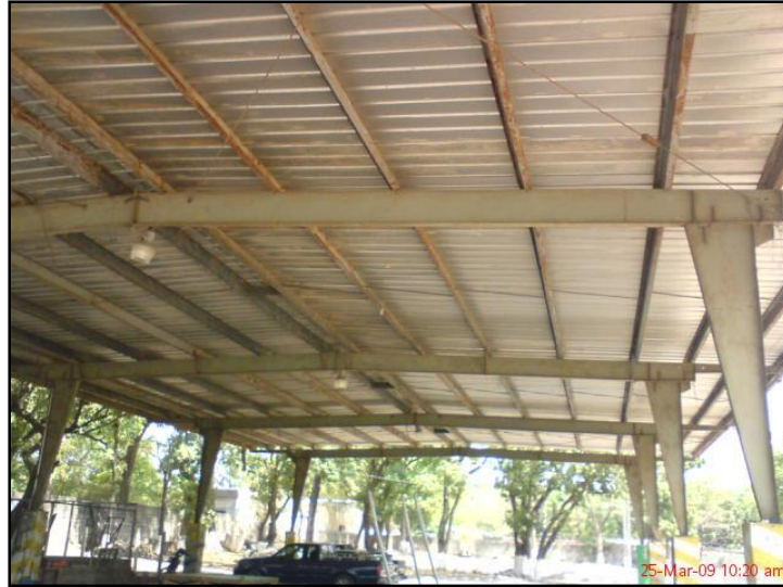
IMAGEN 1.1. Nave Industrial Centro De Gobierno Municipal.
