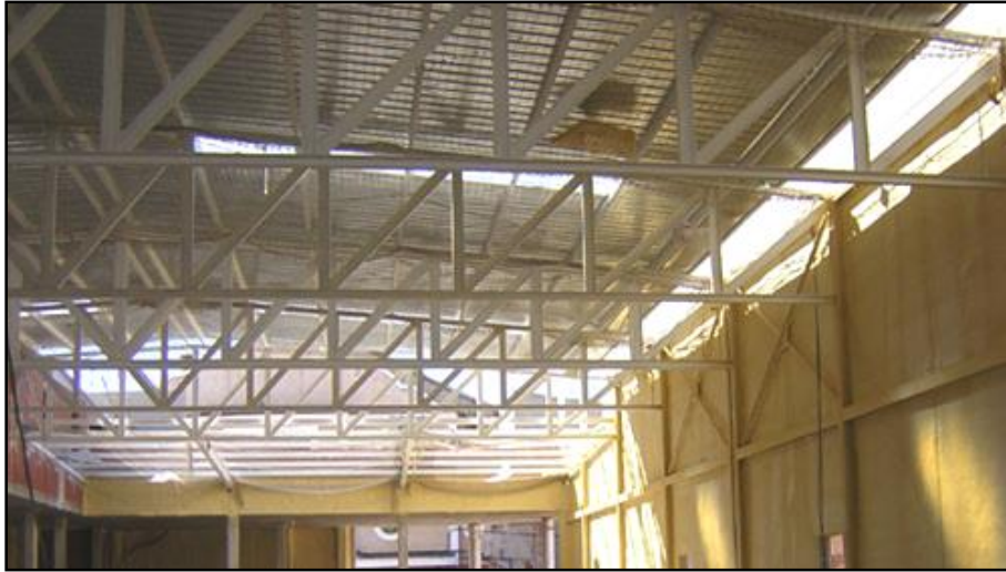
Figura 2.1 Nave Industrial Compuesta Por Un Sistema Columna-Armadura.
