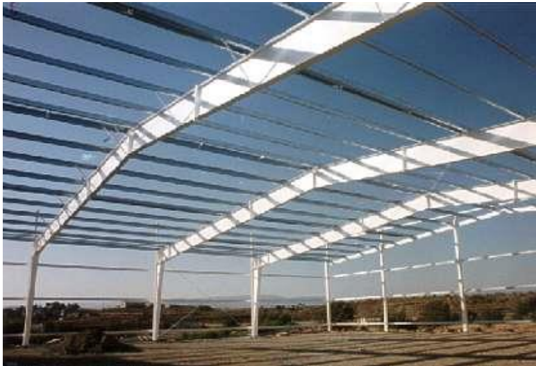
Figura 2.4 Nave Industrial Tipo Marco Rígido
