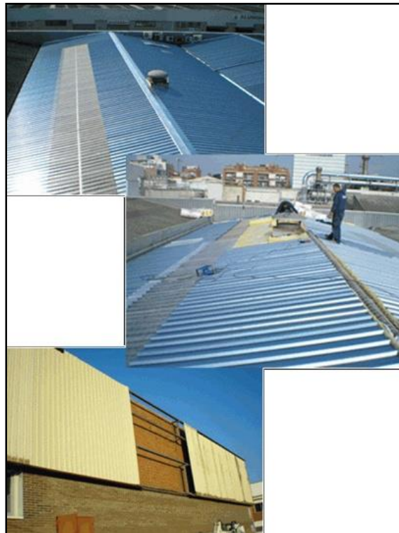
Figura 2.22 Cubiertas De Techos.
