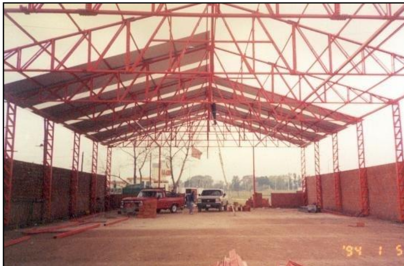
Figura 2.15 Armaduras De Techos.
