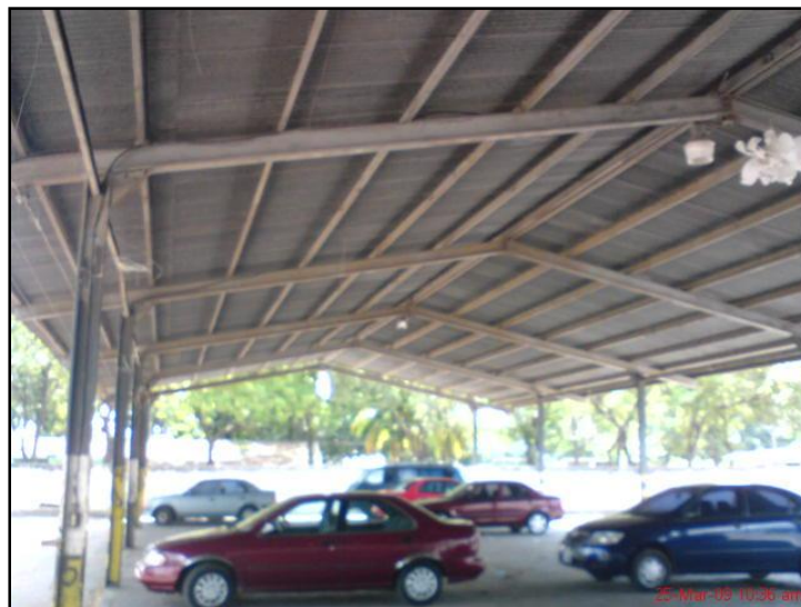
IMAGEN 1.2. Nave Industrial Centro De Gobierno Municipal.
