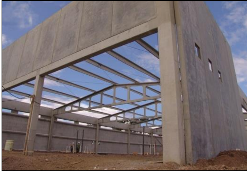
Figura 2.2 Nave Industrial De Hormigón Armado.
