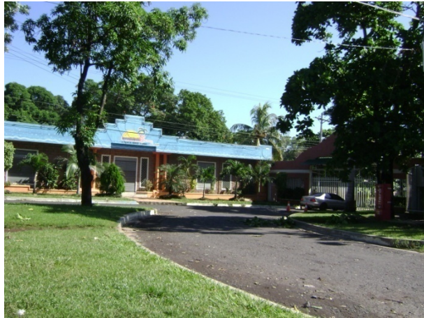
Fotografía 4.1. Alternativa 1: Entrada de la Residencial El Sitio.
