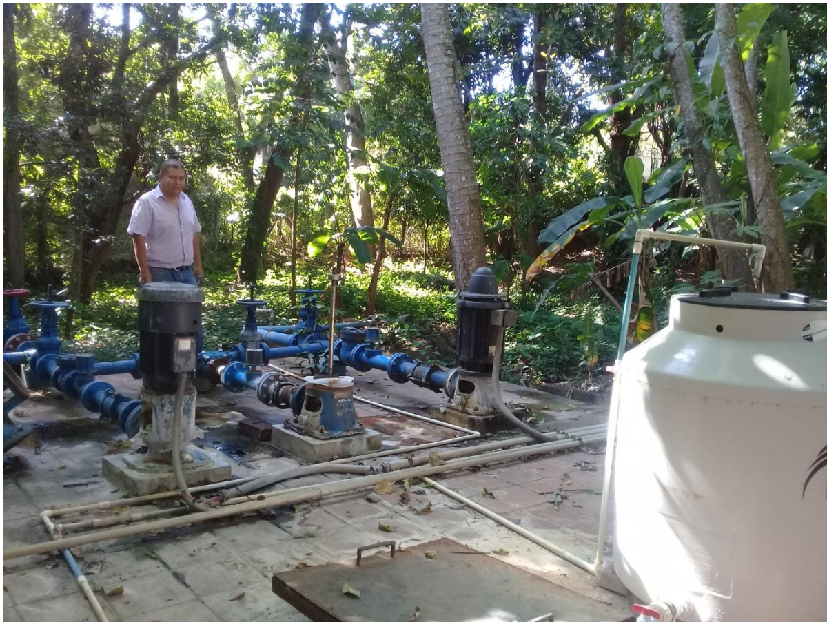
Figura 8. Estación de Bombeo el manantial. Moncagua
