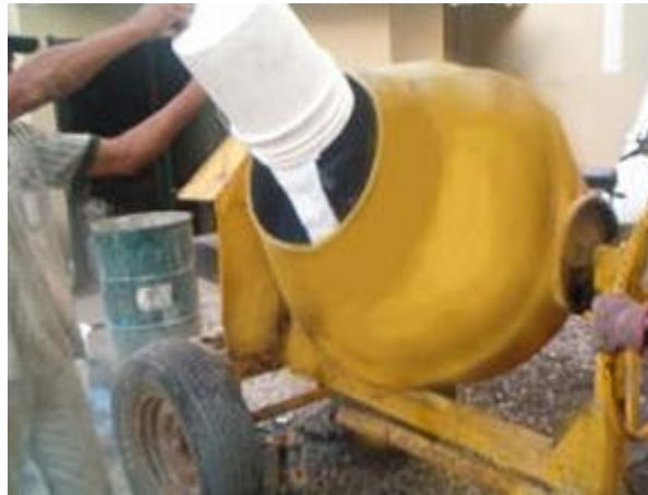
FIGURA 14. Aditivo siendo agregado al concreto
