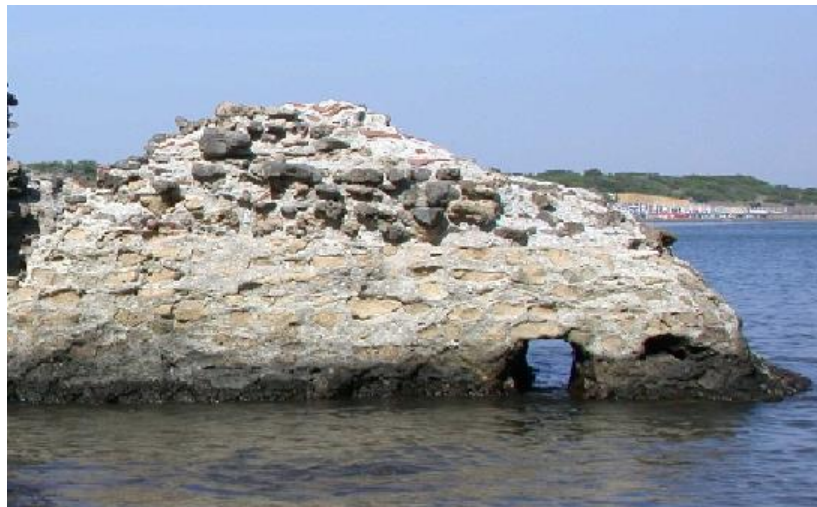
FIGURA 1. Dique Romano sumergido en el mar Mediterráneo, realizado con cenizas volcánicas de Nápoles
