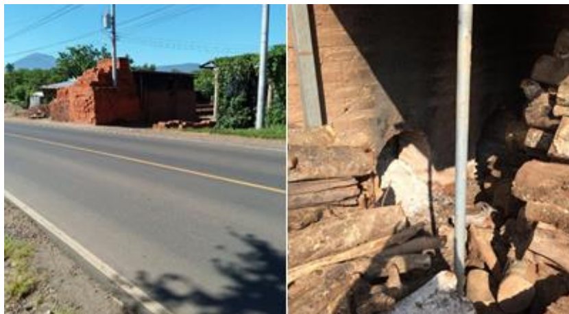
FIGURA 55. Vista a ladrillera
