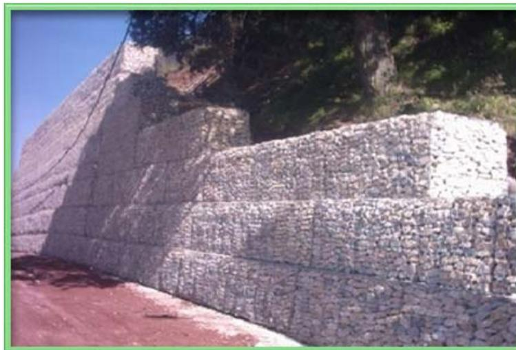
Figura 67. Esquema de un muro en Gaviones.
