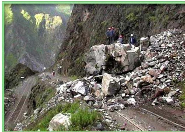
Figura 6. Caída libre y rodado en taludes.
