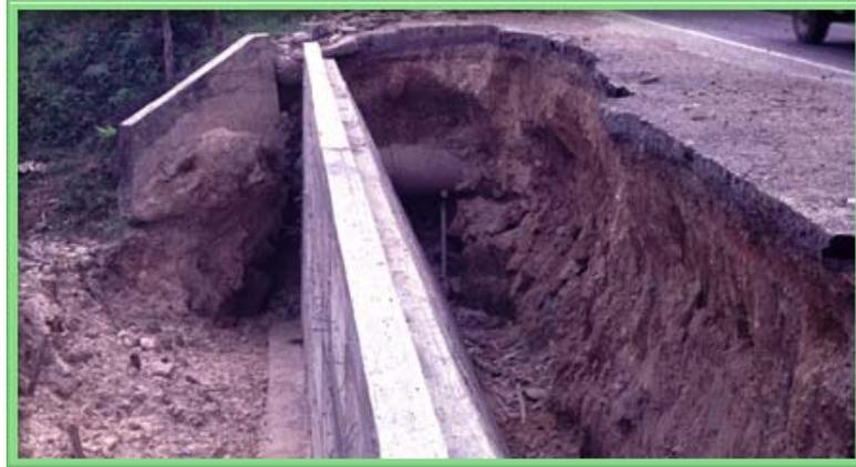
Figura 65. Muro en concreto sin refuerzo
