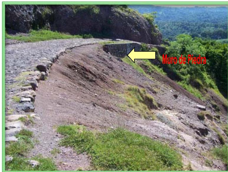
Figura 101. Tramo de muro construido para protección de la calle en ladera No. 3.
