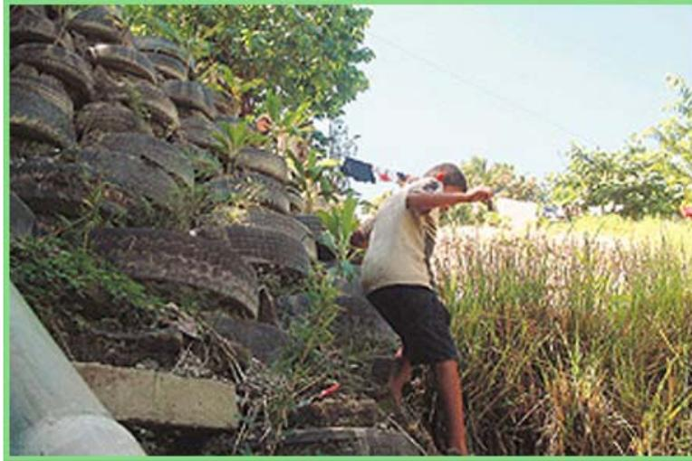
Figura 66. Ejemplo de muro flexible (muro de llantas).
