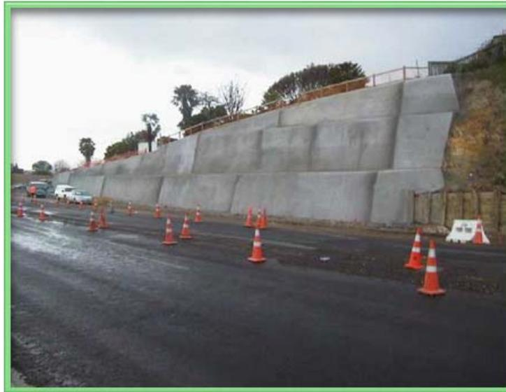
Figura 52. Estabilización por medio de concreto lanzado.
