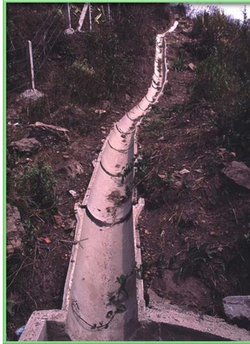
Figura 55. Zanja de coronación para el control de aguas superficiales en un talud.
