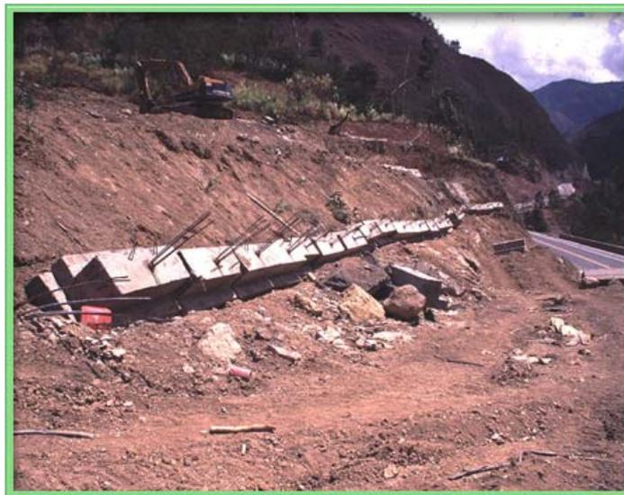
Figura 71. Esquema de estructuras ancladas.
