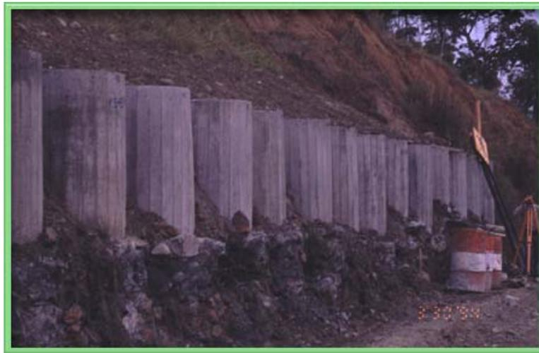
Figura 75. Esquema del planteamiento de una pila como muro de contención.
