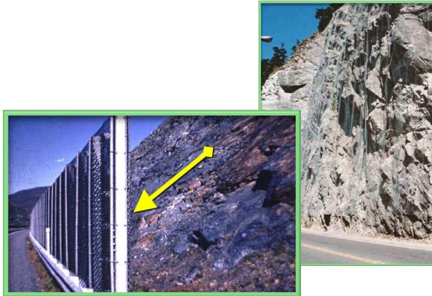
Figura 50. Sistema de barrera metálica con cables de acero y malla para controlar caídos de roca.
