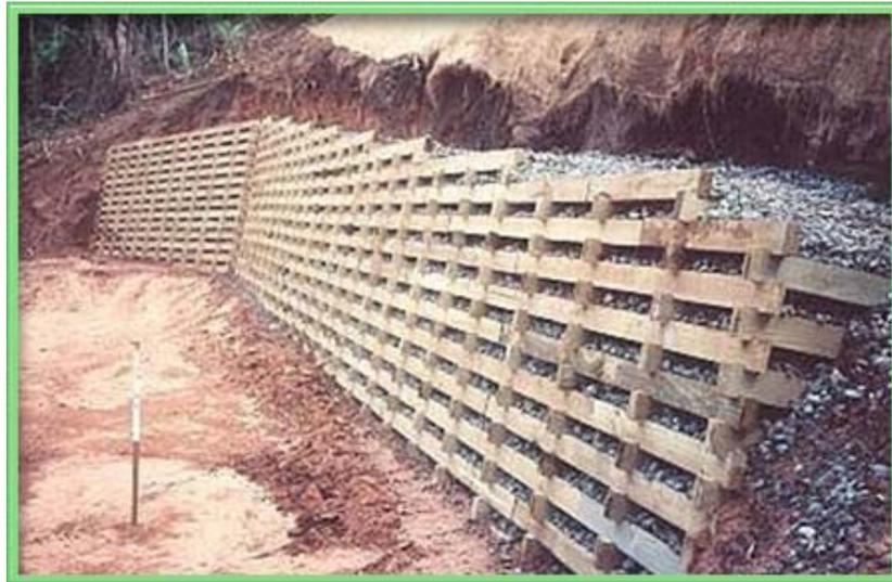
Figura 68. Esquema general de los muros criba.
