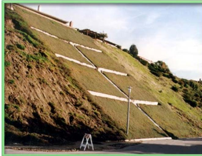
Figura 56. Esquema de entrega de canales interceptores a mitad de talud.
