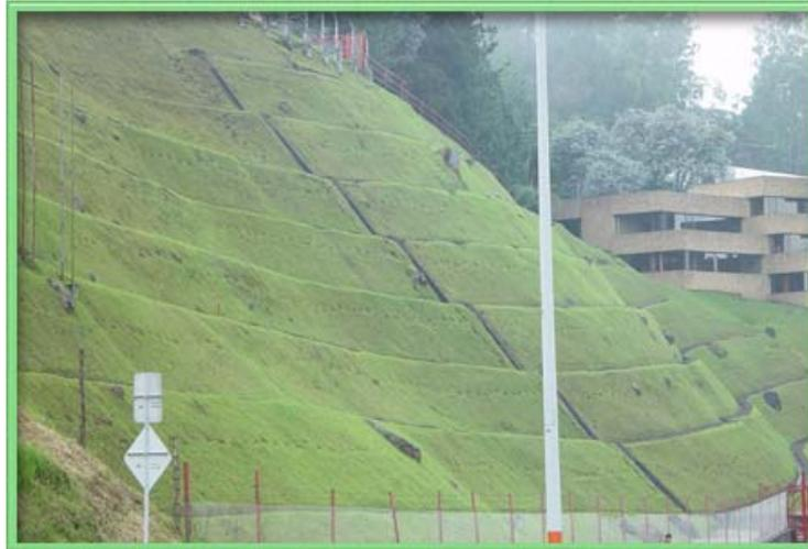
Figura 51. Estabilización por conformación del talud y bermas.
