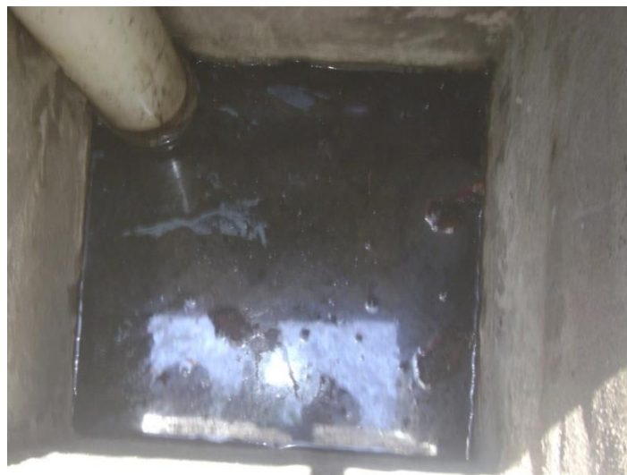
Fig. 3.17 Fosa de captación de los baños del auditorio.
