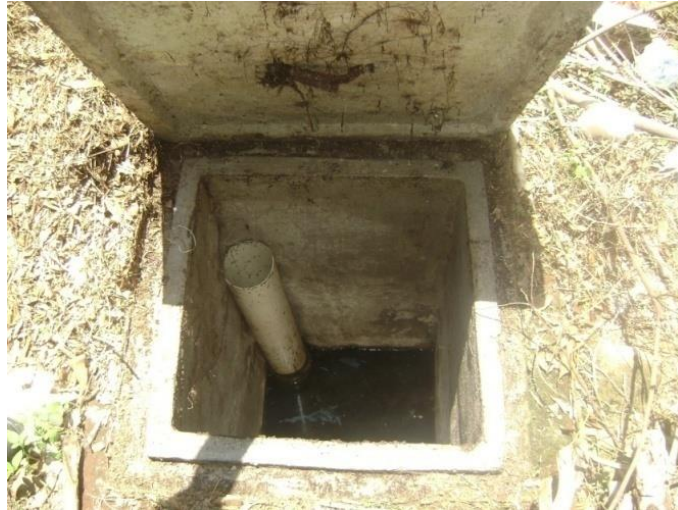
Fig. 3.16 Tapadera de fosa séptica.
