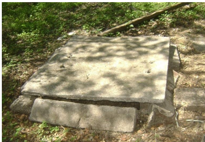
Fig. 3.12 Caja de captación.
