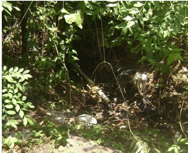
Fig. 3.18 Punto de descarga de aguas provenientes del edificio de la biblioteca.
