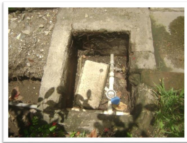
Fig. 3.25 Medidor de Caudal Utilizado En Baños Ubicados Al Costado Norte del Auditorio General.
