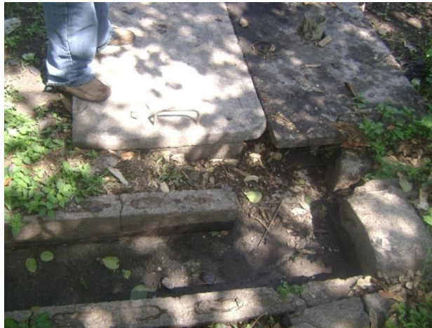
Fig. 3.7 Canales de conducción de aguas residuales
