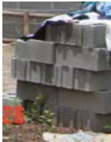
Figura N° 5.4.1.1: Materiales de construcción en buen estado.
