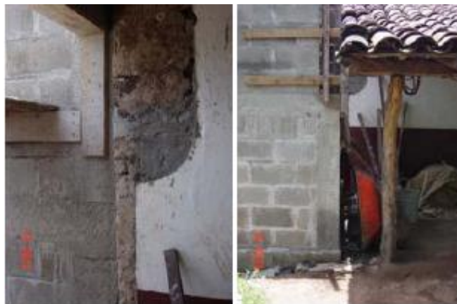
Figura N° 5.4.1.4: Previsión de ampliaciones futuras.
