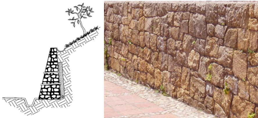
Figura N° 5.1.1.1: Muros de mampostería de piedra.
