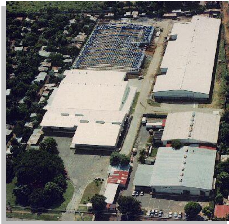
Fig. 9 Muestra las instalaciones donde se elaboran los paneles prefabricados.
