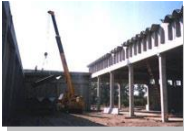
Fig. 8 Grúa Torre se utiliza para levantar las unidades prefabricadas pesadas.
