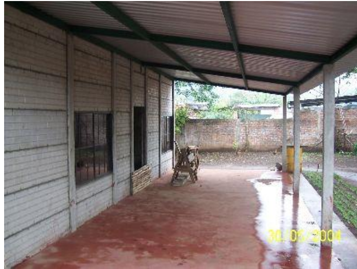
Fig. 12 Vivienda construida con elementos prefabricados de concreto en Lolotique, San Miguel.
