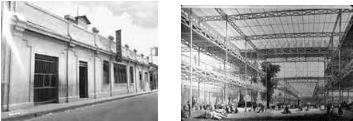
Fig. 14 Se pueden observar los tipos de obra que se han construidos con el Sistema “Camus”.
