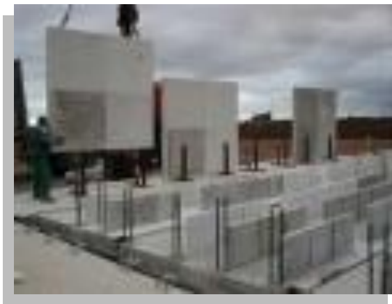
Fig. 10 Muestra la colocación de los paneles ya terminados en obra.
