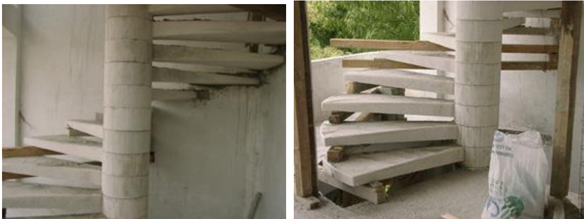
La figura 7. Se observa como se forma una escalera prefabricada de concreto en forma de espiral.
