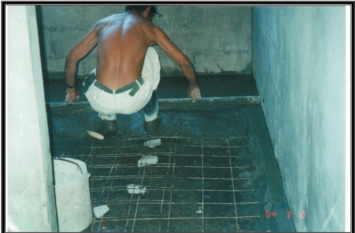
Figura 7-17: Pasado del codal apoyándose en las fajas
