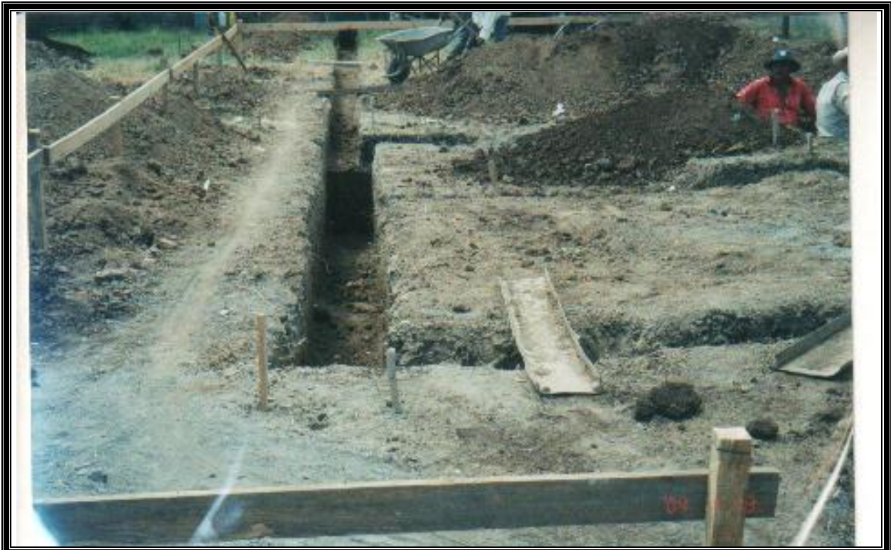
FIGURA 5 - 9: Excavacion para la solera de fundacion
