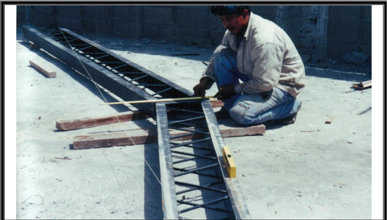
figura 6-8: Obrero comprobando medidas de la viga
