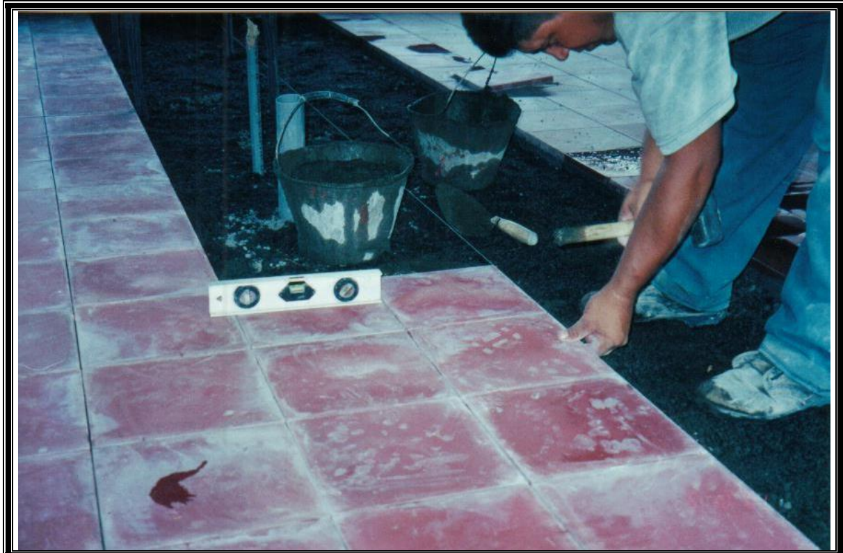
Figura 7-5:Utilización del nivel de caja
