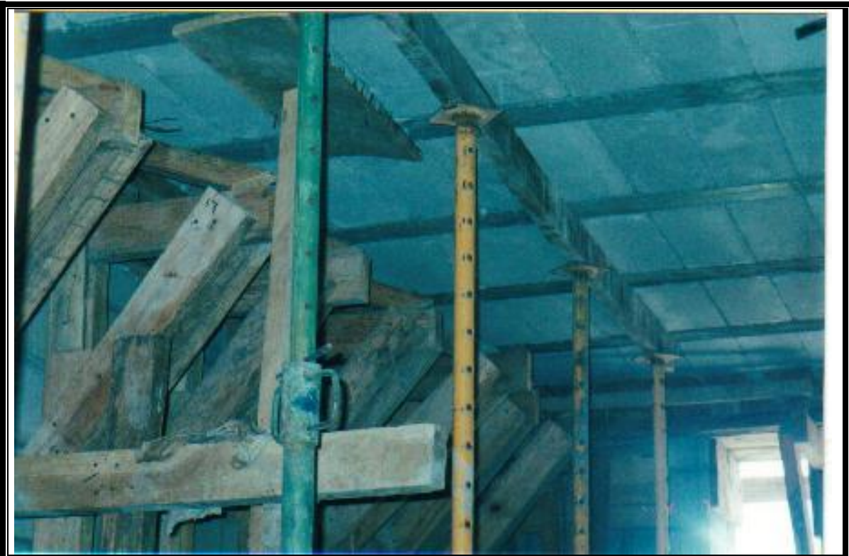
Figura 4-82: Pilotes cubriendo la totalidad del area de la losa a colar sobre durmientes
