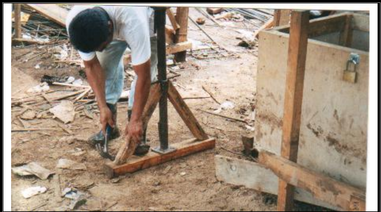
Figura 4-48: Preparacion de pilotes para vigas
