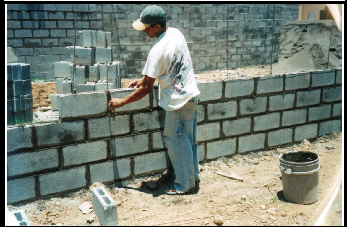
FIGURA 5 - 53: Sisas verticales se hacen después
