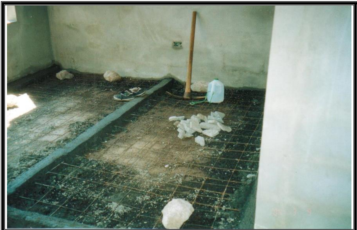
Figura 7-13: Trozos de bloque usados como helados
