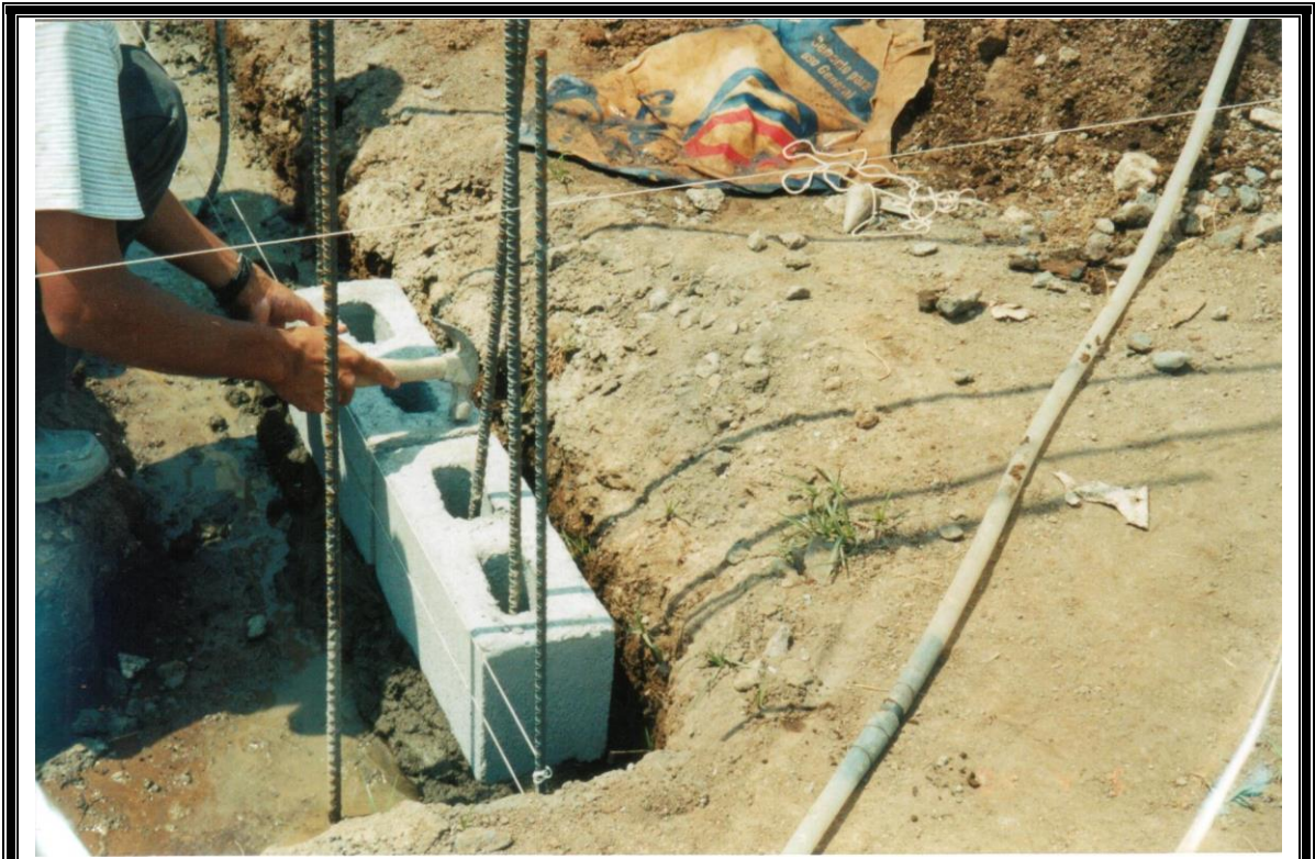
FIGURA 5 - 42: Albañil ajustando la altura del bloque asestando golpes leves sin dañar el bloque
