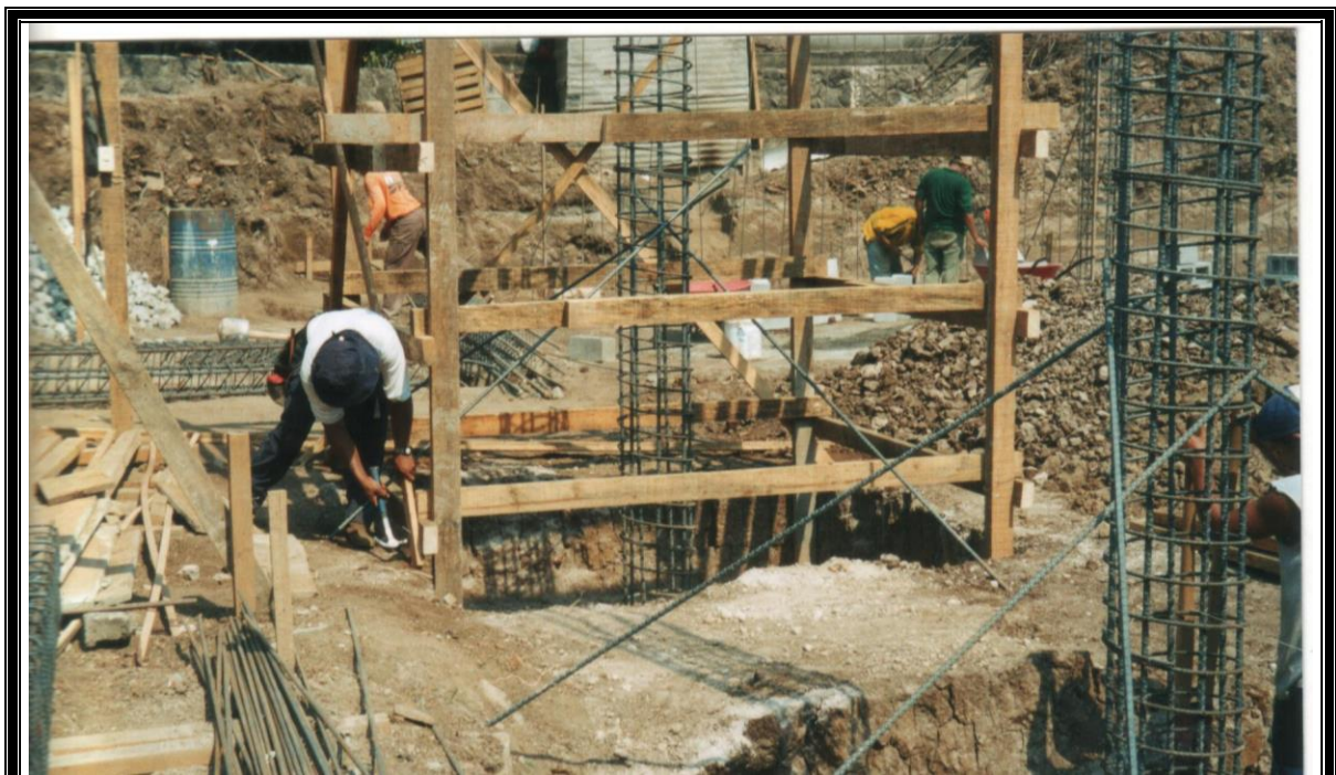
Figura 4-30: Colocación de diagonales en el castillo
