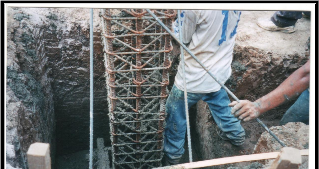
Figura 4-14: Vientos amarrando sosteniendo la columna para evitar su movimiento
