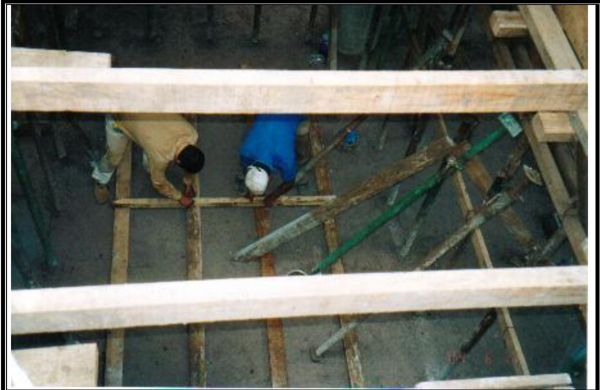
Figura 4-76: Colocacion de los durmientes en el lugar donde cayo la plomada al bajar los puntos de las pitas
