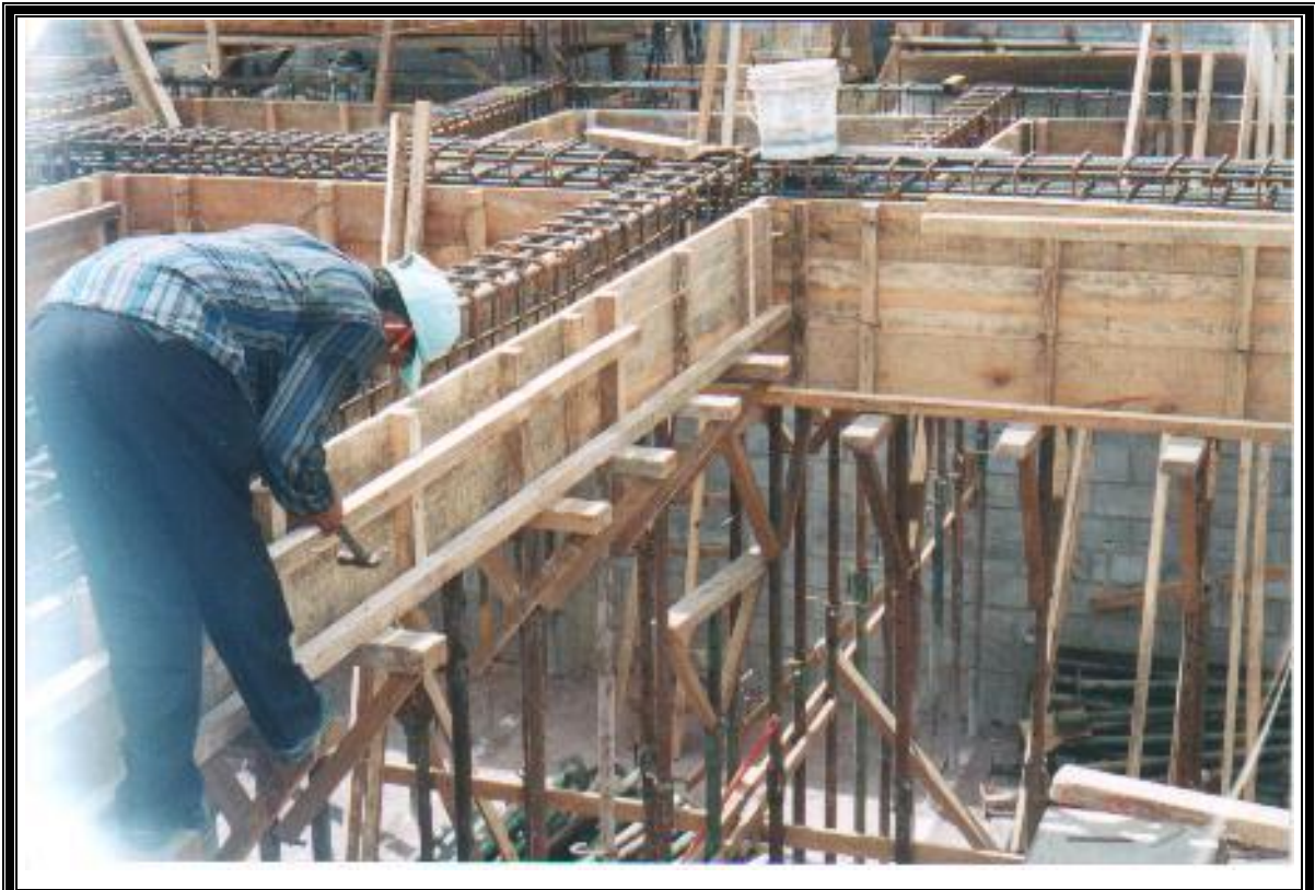
Figura 4-72: Colocación de costanera para que sostenga los burros
