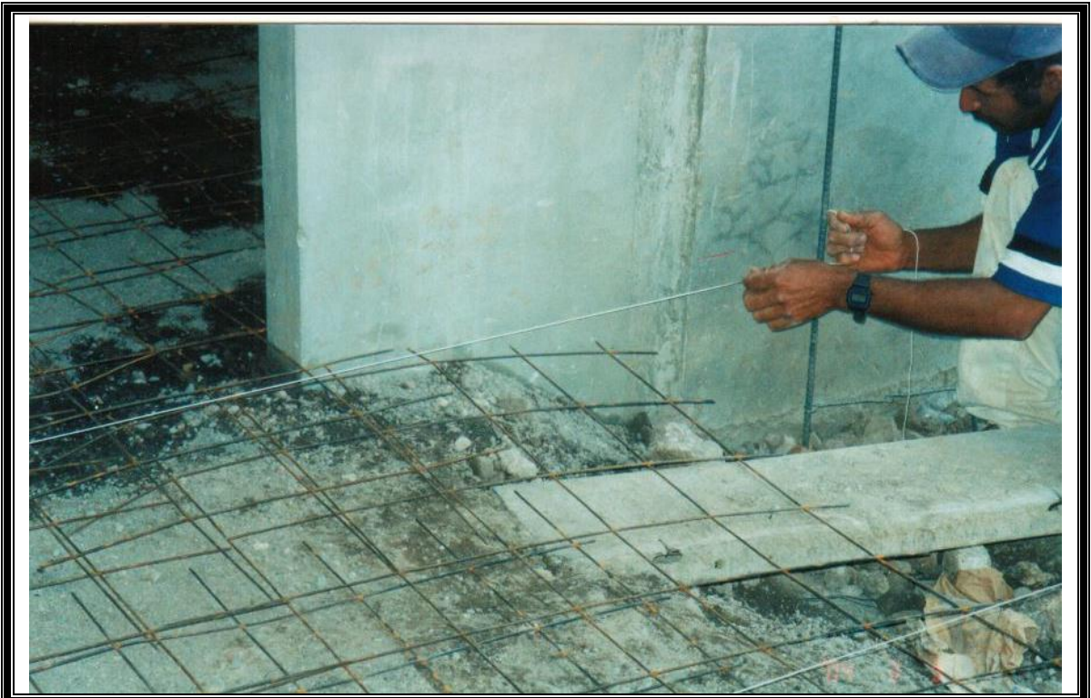
Figura 7-11: Traslado del NPT a las varillas
