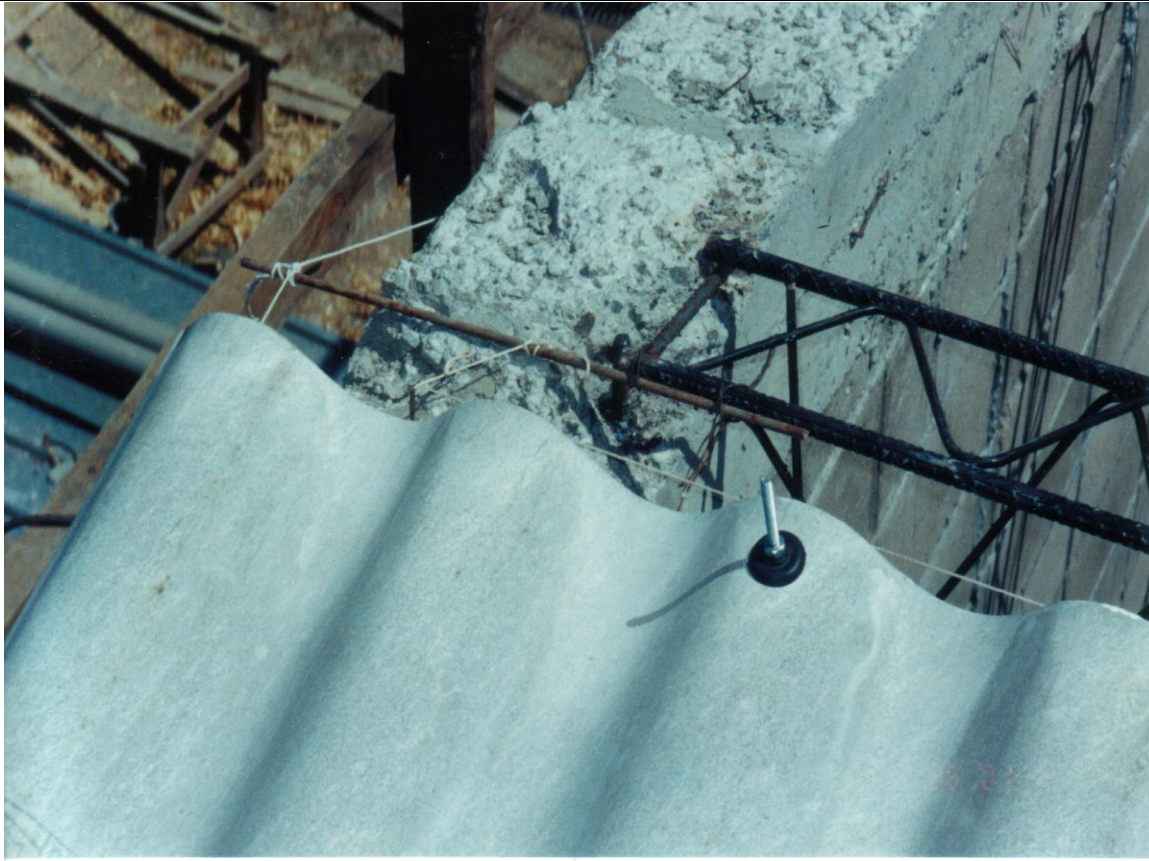
figura 6-19: Pita perpendicular al mojinete para marcar distancia del capote
