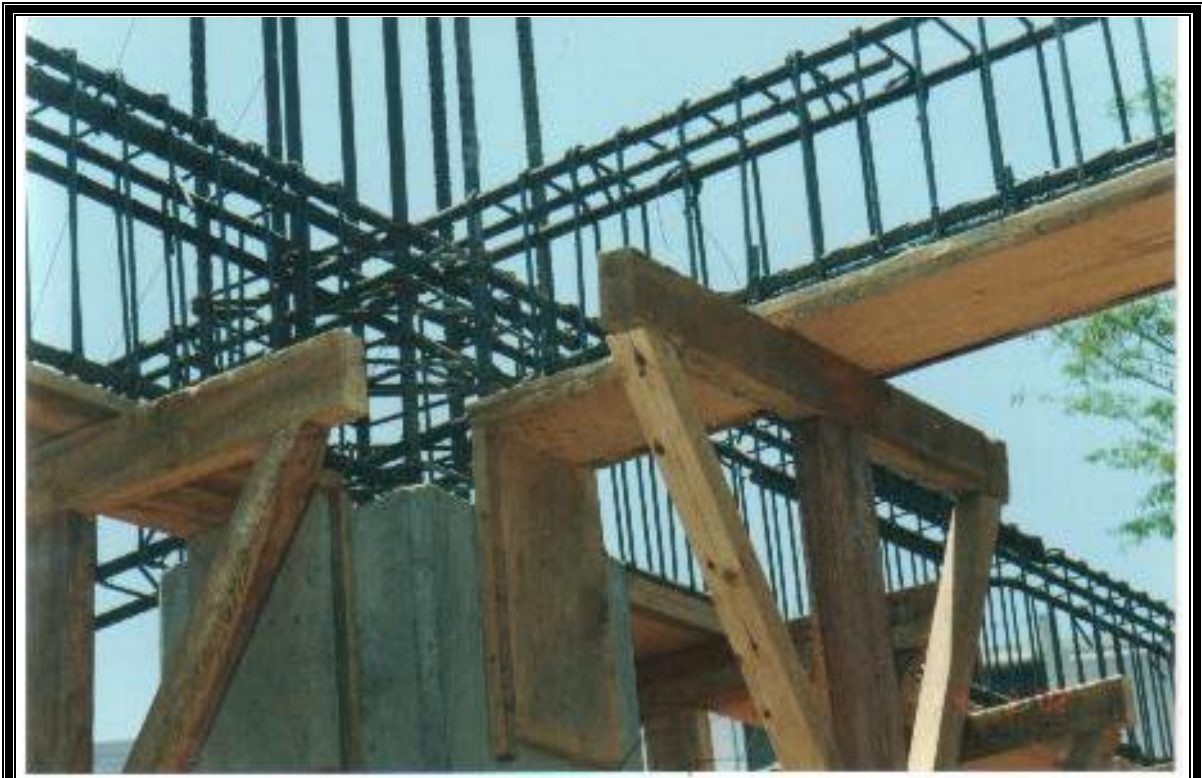
Figura 4-46: Cachetes sosteniendo los asientos de la viga.
