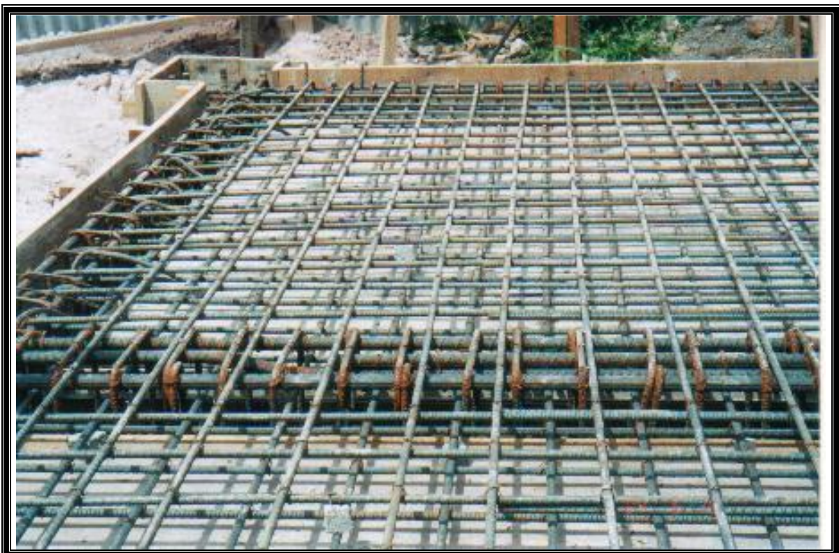
Figura 4-91: Tejido superior de losa intercalado al primero
