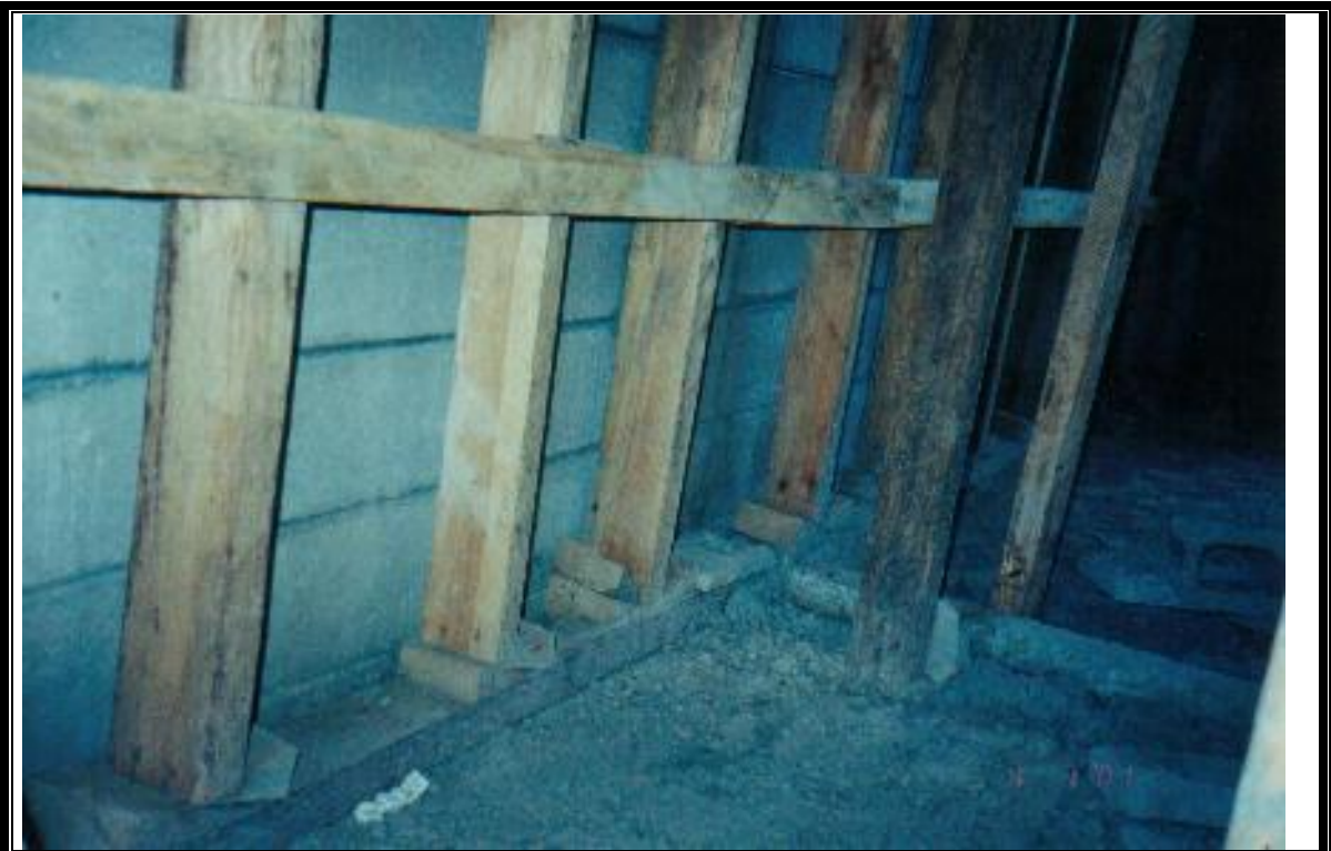
Figura 4-83: Colocacion de cadenas para darle estabilidad a los pilotes
