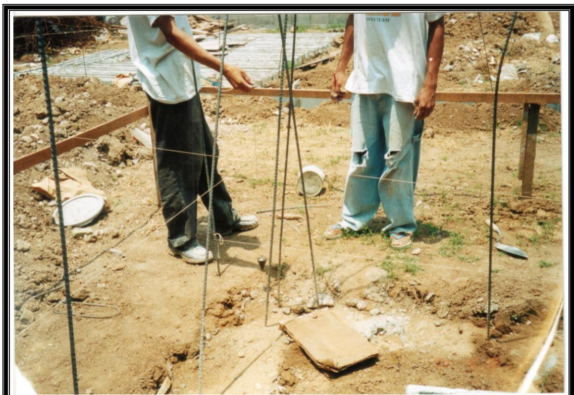
FIGURA 5 - 33: Pitas tendidas sobre las marcas que denotan rostro de pared
