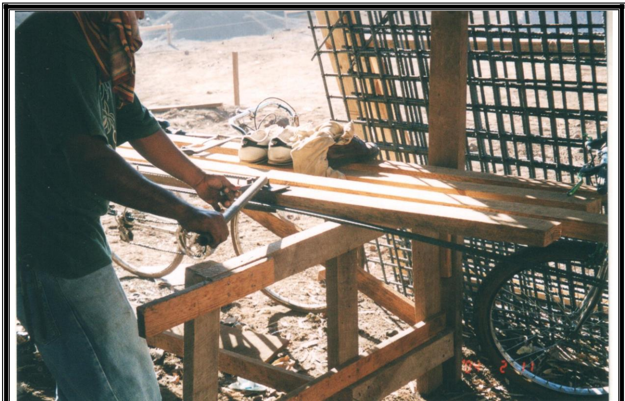
Figura 4-5: Cortado de Varillas para Zapata
