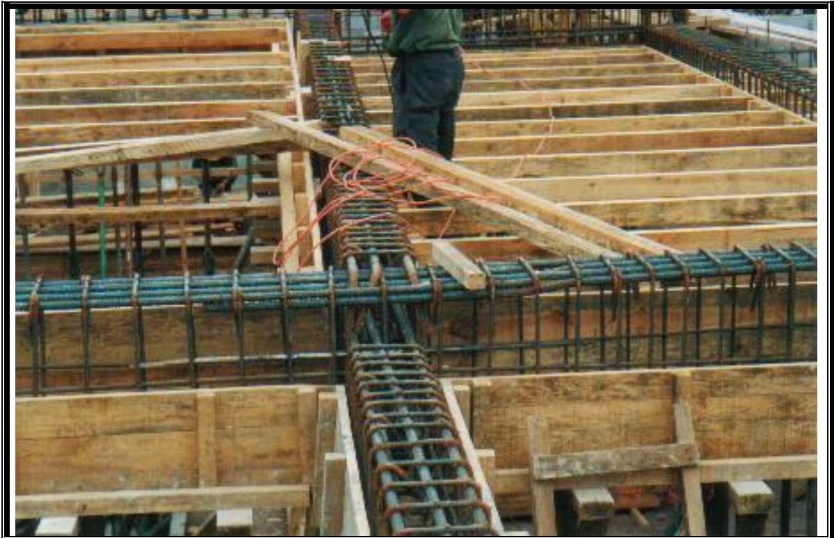
Figura 4-74 Burros canteados para evitar desnivel en la formaleta
