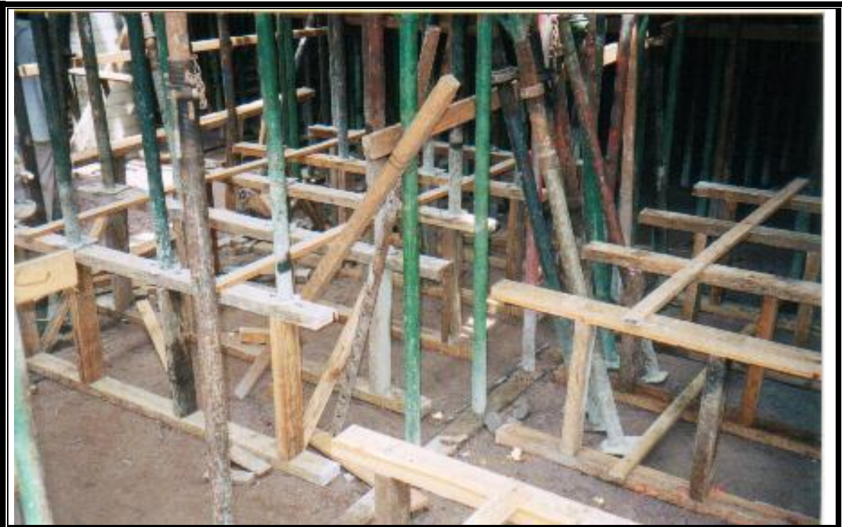
Figura 4-79: Burros salvando altura entre durmiente y burro metalicos
