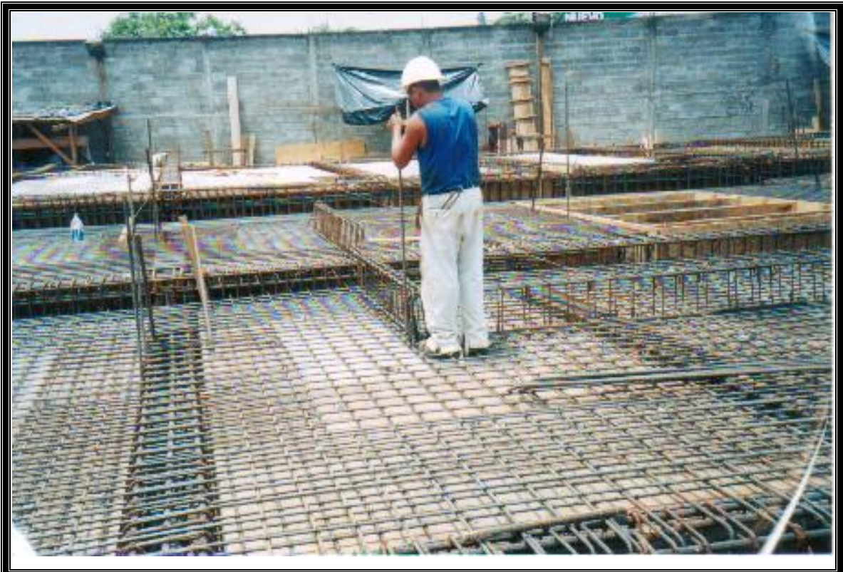
Figura 4-93: Armador colocando bastones y vigas sobre la losa
