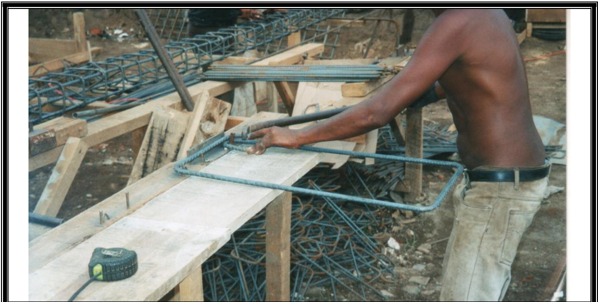
FIGURA 5 - 11: Elaboración de estribos para solera de fundación
