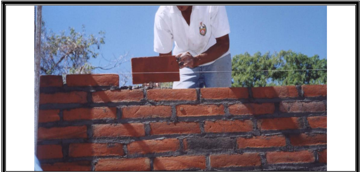
Figura 5 - 57: Pegamento de ladrillo
