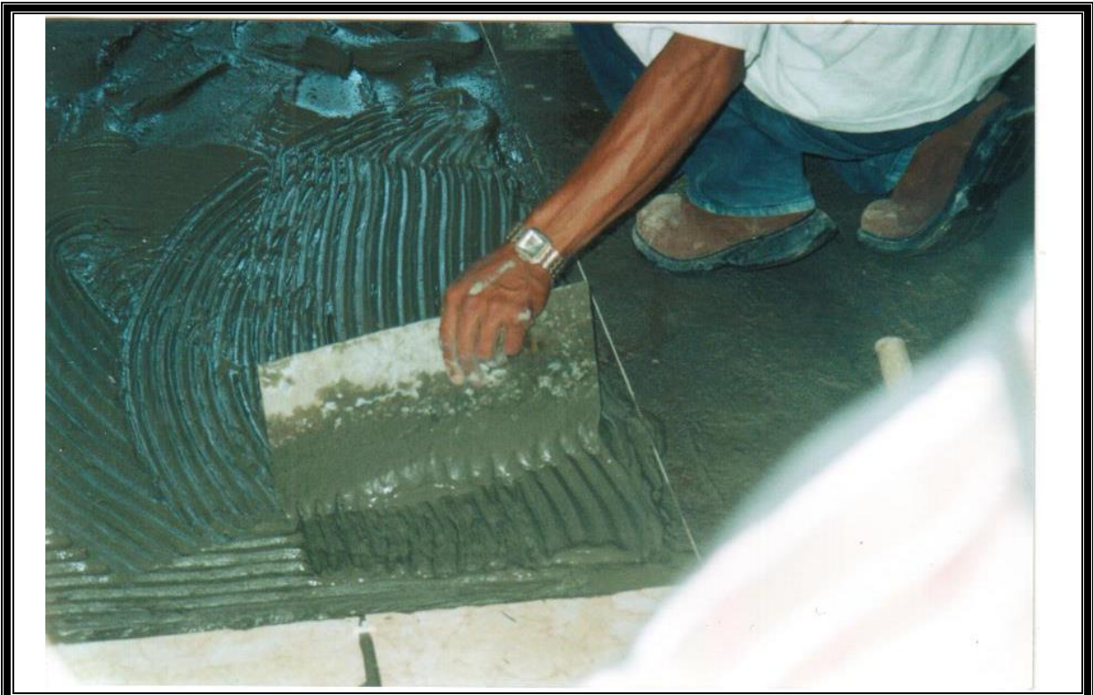
Figura 7-19: Riego de pasta utilizando raqueta o peineta
