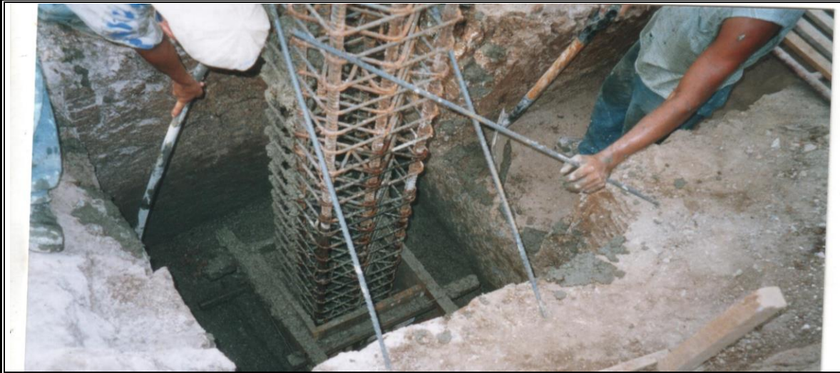
Figura 4-23: Vibrado del concreto en zapata y pedestal
