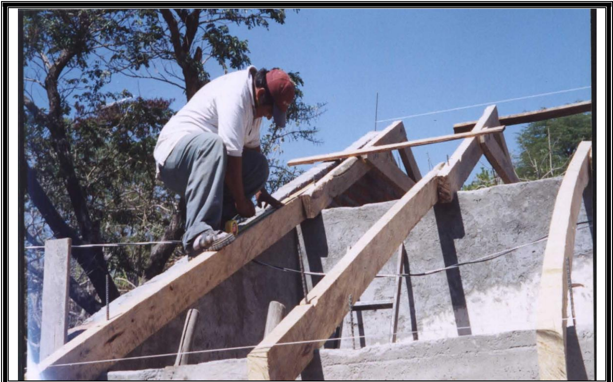
figura 6-38: Medición de posición de las reglas
