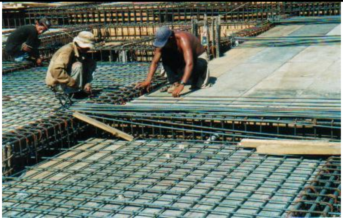
Figura 4-88: Armador haciendo pasar los anclajes a traves de la viga
