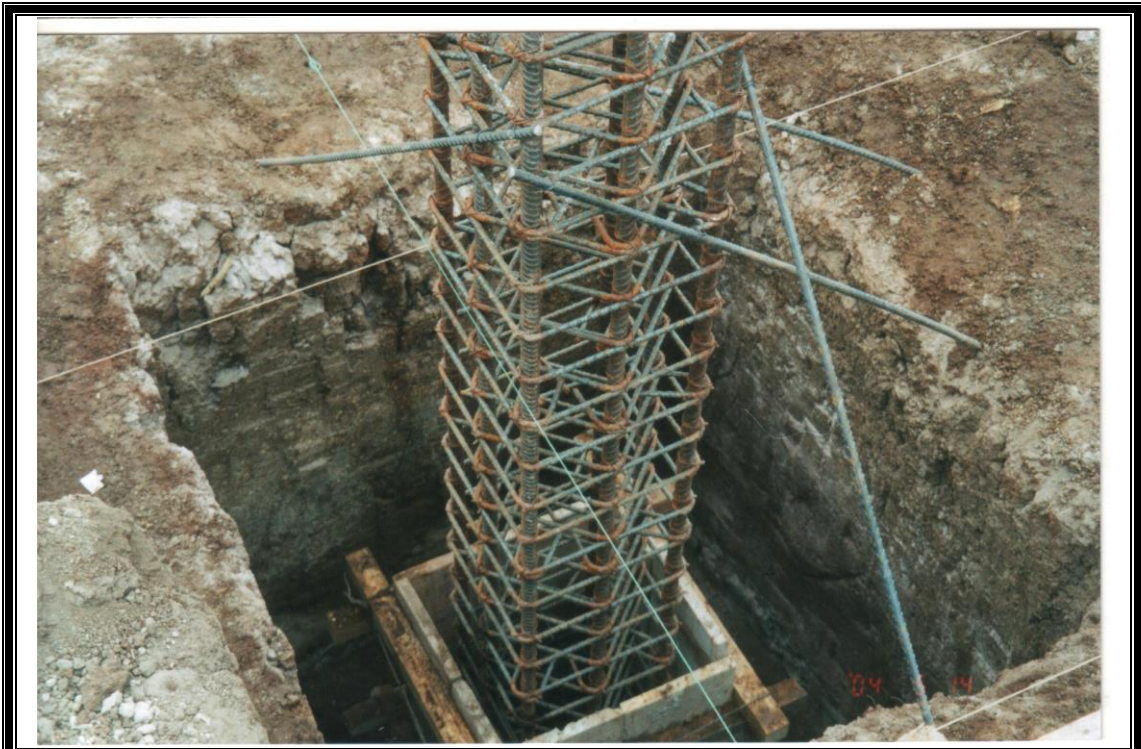
Figura 4-18: Pedestal con separadores para el recubrimiento
