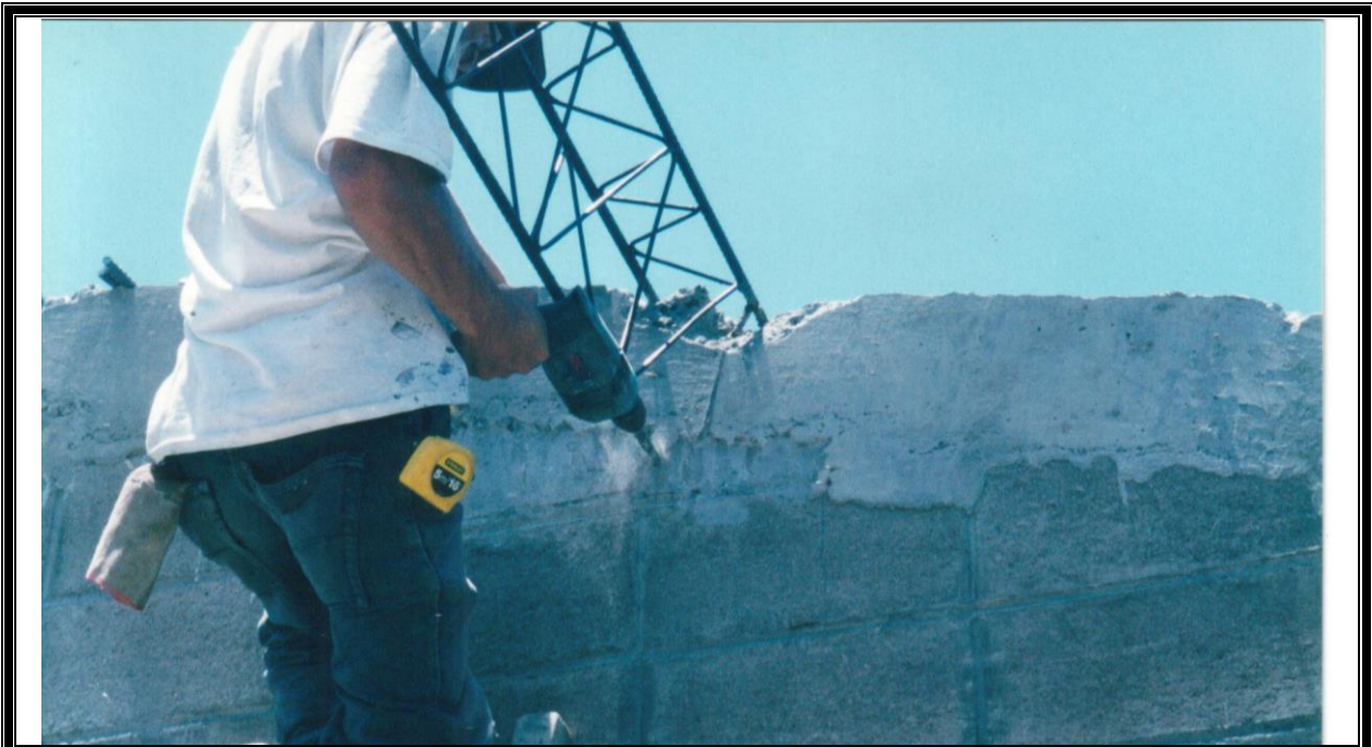
figura 6-15: Perforación de solera para soldar varilla inferior de polín
