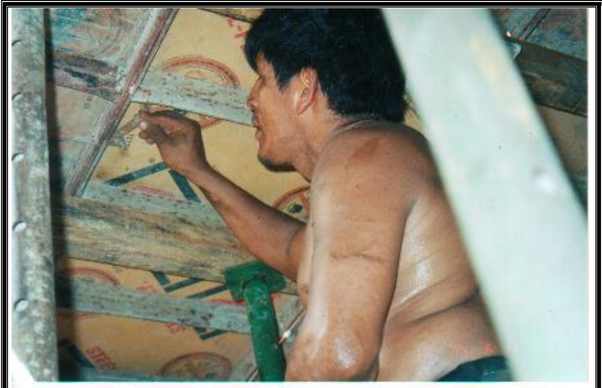
Figura 4-86: Carpintero colocando pasadores en formaletas prefabricadas
