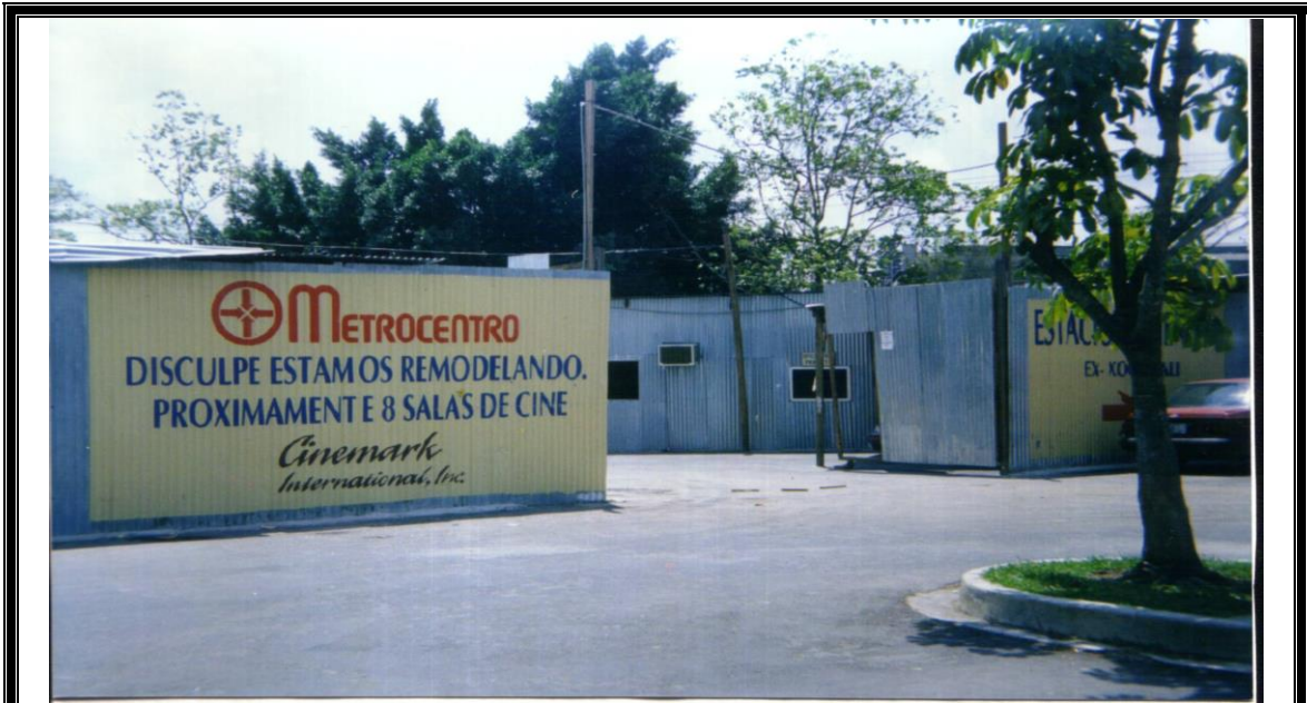
Figura 2-9: Cerco perimetral de protección al proyecto
