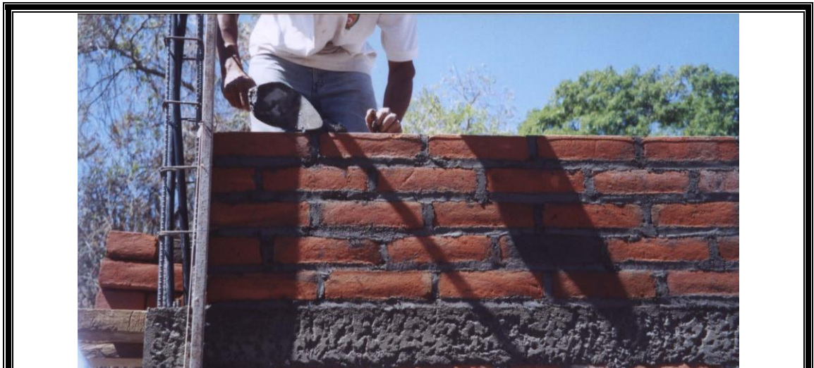
Figura 5 - 58: Zulaqueado de sisas verticales
