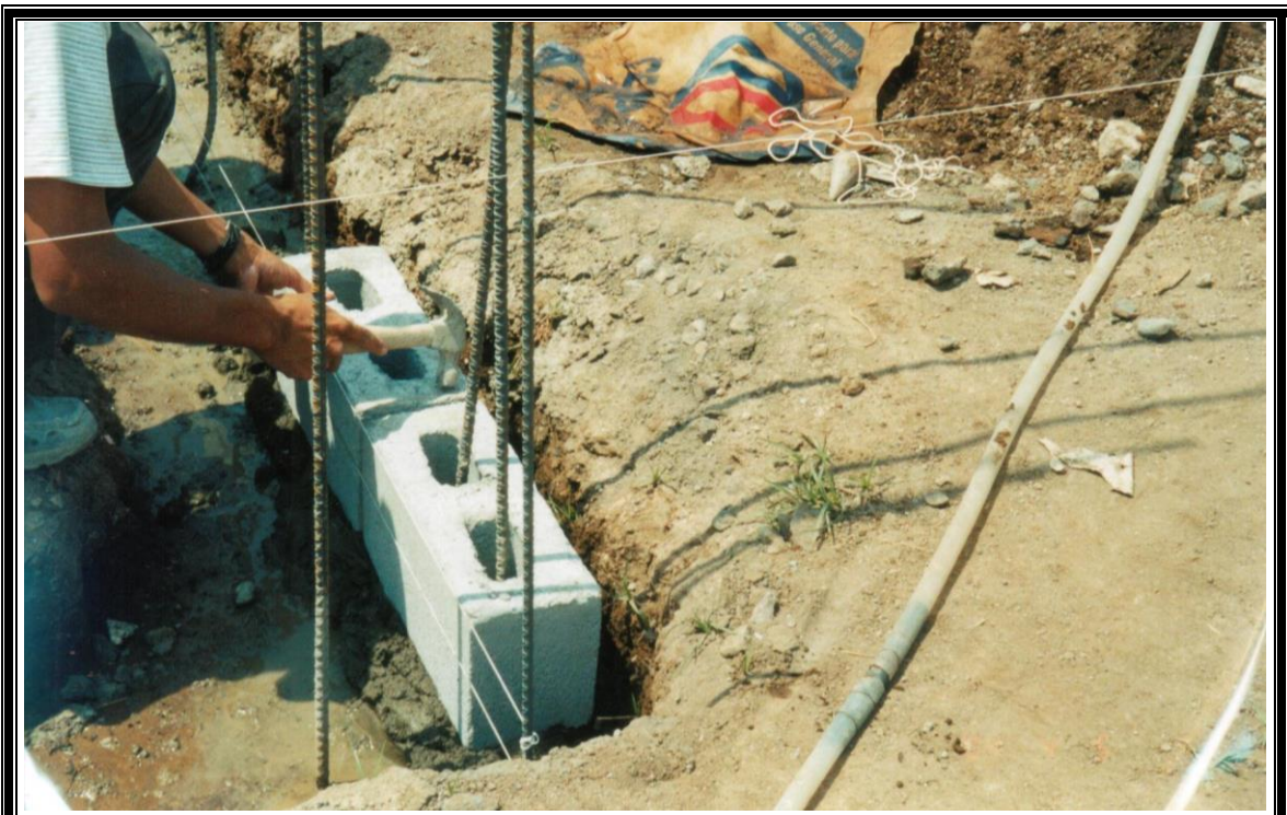
FIGURA 5 - 39: Dos pitas para la modulación, la superior la altura de la hilada y la segunda la línea del rostro de pared
