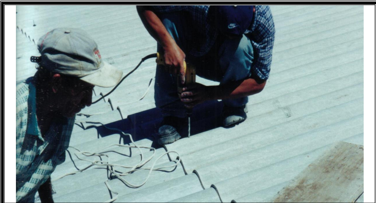
figura 6-25: Perforación de láminas con taladro
