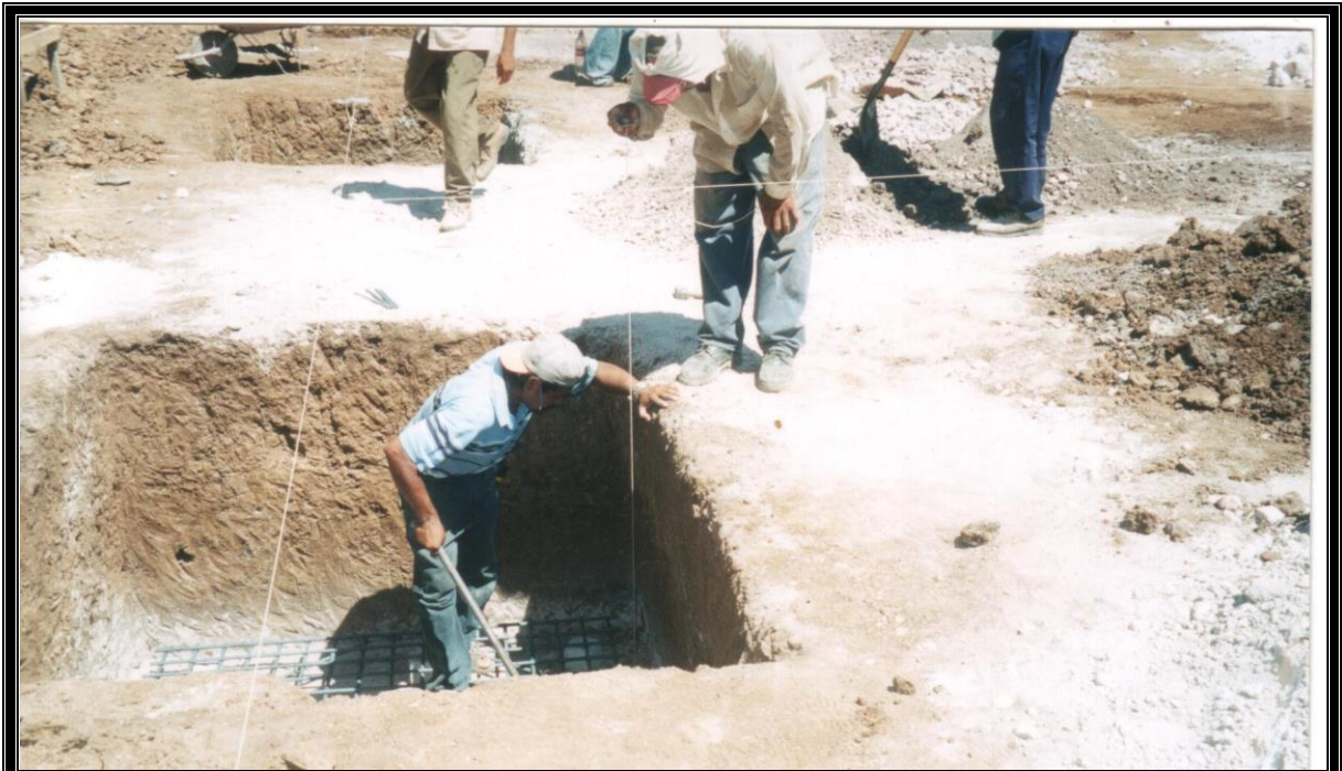
Figura 4-6: Replanteo de zapata aislada
