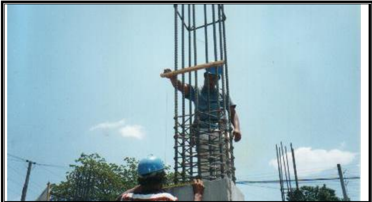
Figura 4-45: Replanteo del eje de la columna, utilizando las pitas.
