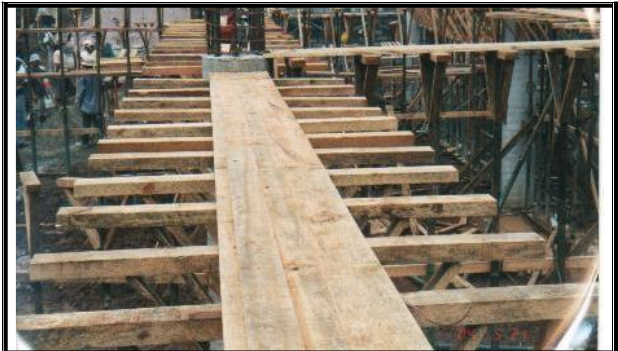
Figura 4-50: Asiento clavado sobre los cabezales de los pilotes
