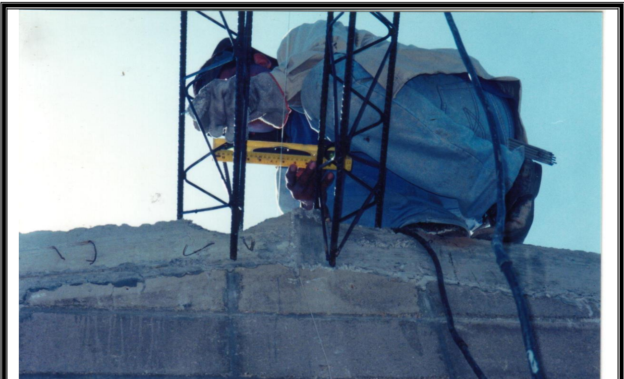
figura 6-14: Obrero verificando horizontalidad de polines de cumbrera
