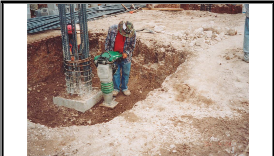
Figura 2-28: Compactación con bailarina
