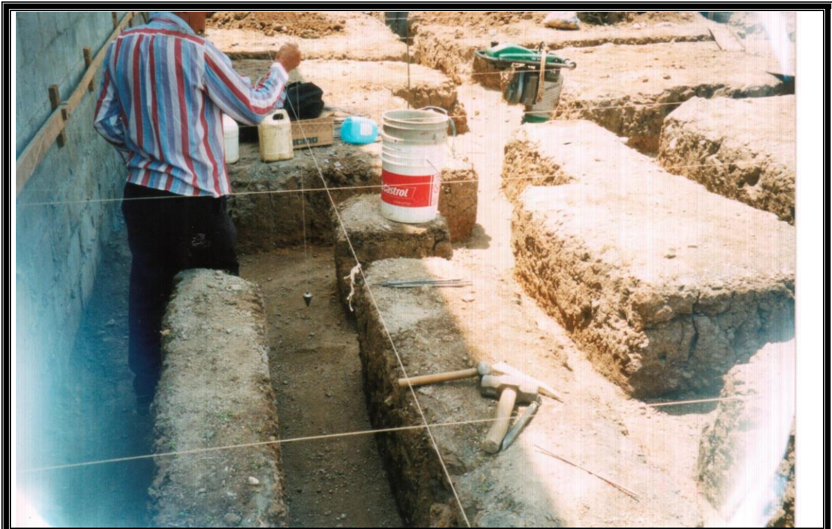
FIGURA 5 - 12: Colocación de pitas en los ejes de las niveletas y bajado de puntos de la intersección de ejes utilizando plomadas
