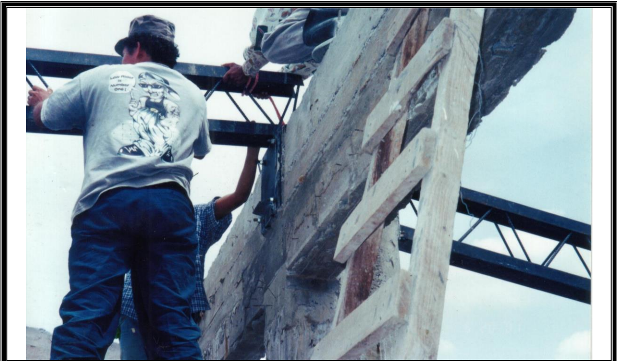
figura 6-11: Mecánico ajustando viga a la platina de sujeción en la pared
