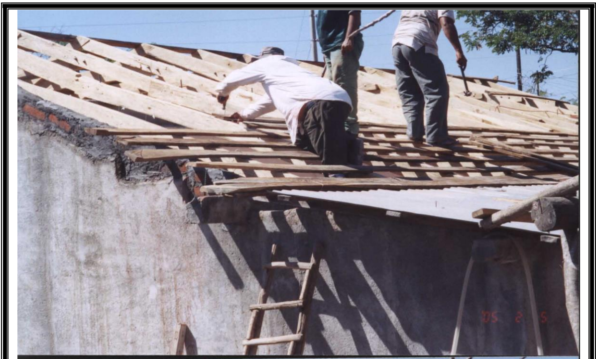
figura 6-40: Reglas no uniformes en los extremos que deben de ser cortadas
