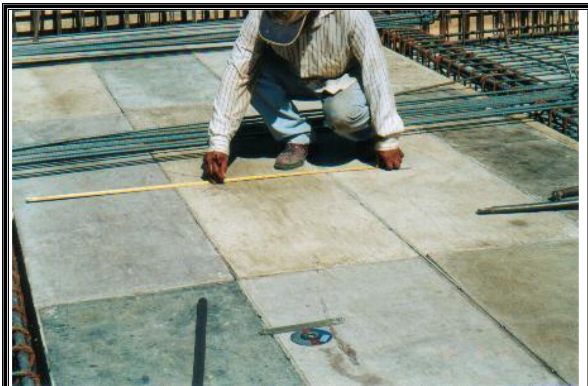
Figura 4-87: Armador marcando la distribución del tejido, al centro de la losa
