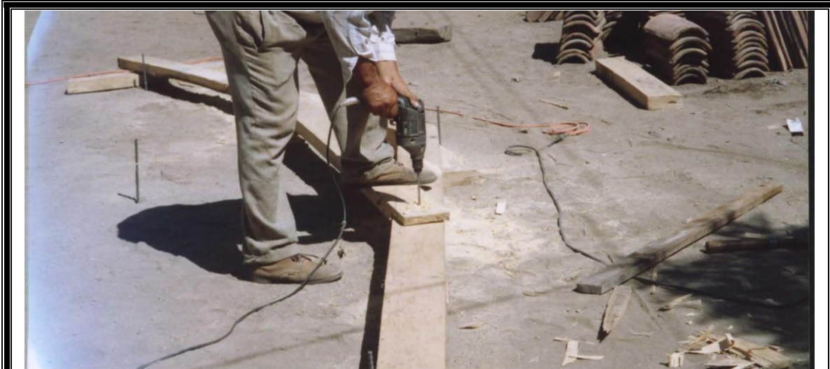
Figura 6-28: Pines hincados en el terreno que determinan la geometría de la tijera
