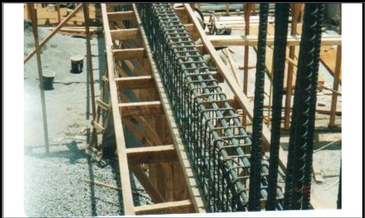
Figura 4-63: Costanera clavada a lo largo de la viga, sobre los cabezales de los pilotes
