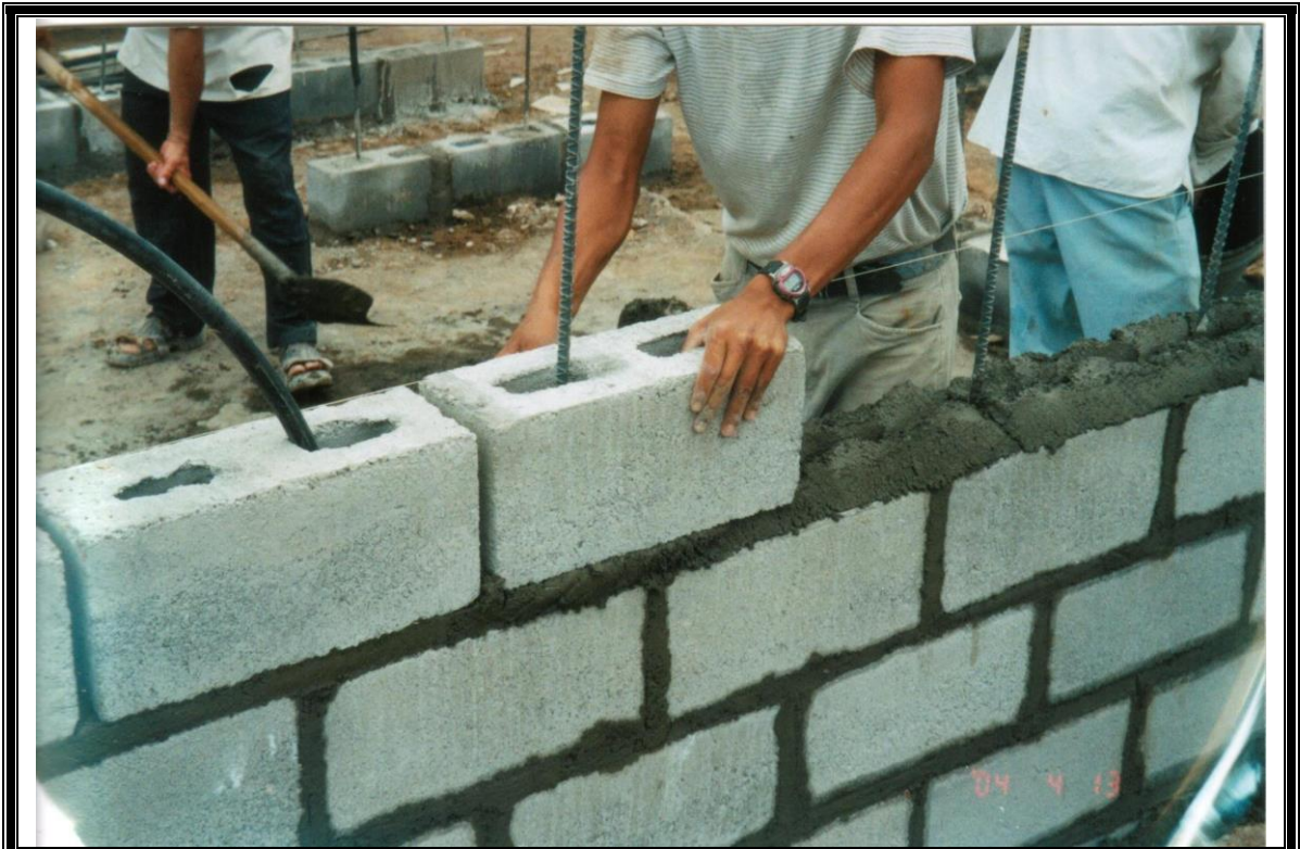
FIGURA 5 - 50: Ducto eléctrico pasado a través de las membranas del bloque
