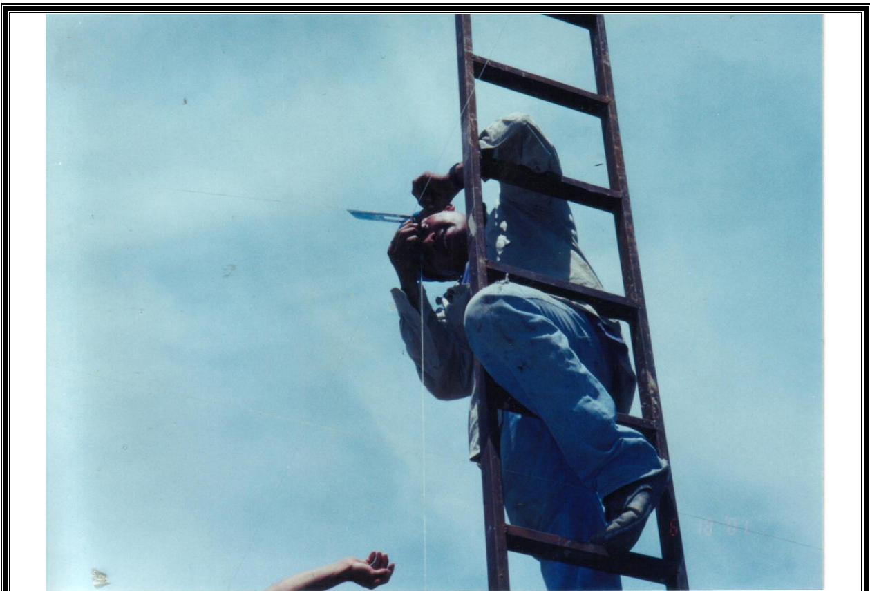
figura 6-5: Obrero sacando falsa escuadra de viga macomber
