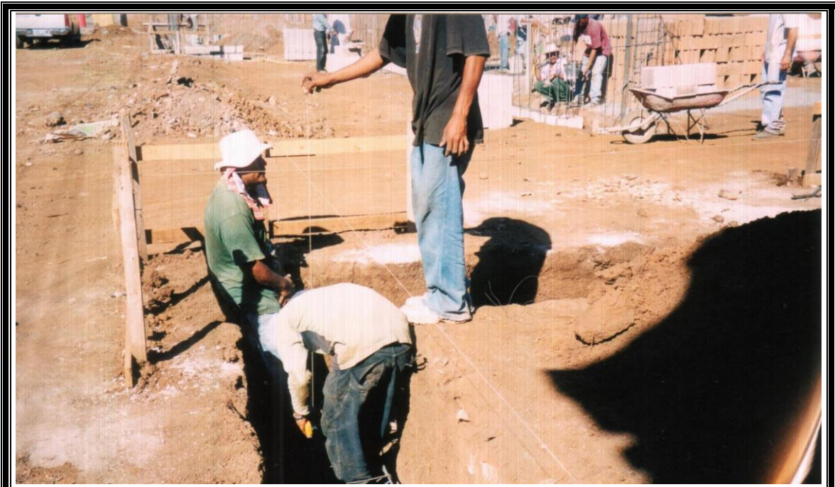
FIGURA 5 - 17: Colocación de pitas sobre las niveletas para el trazo de bastones, nervios y alacranes en la solera
