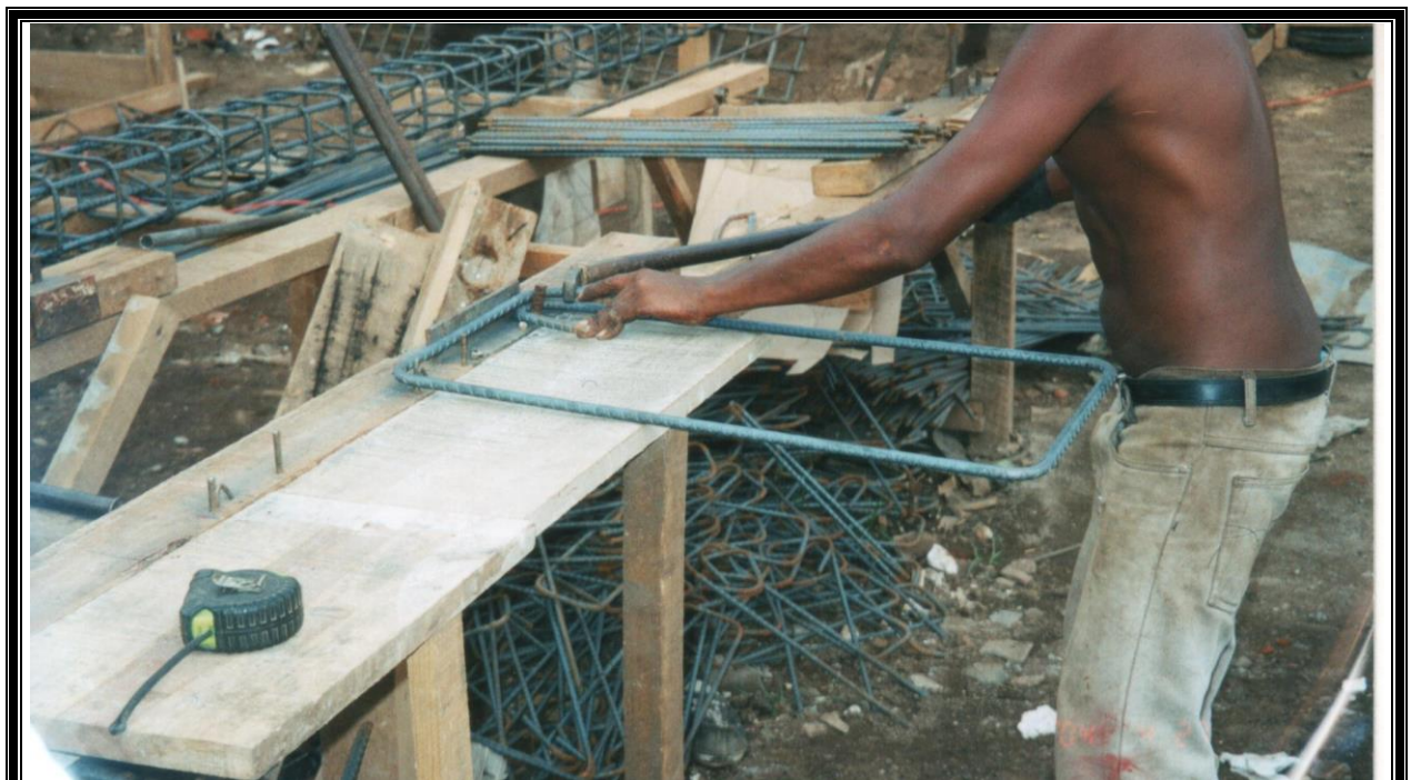
Figura 4-10: Trazo para elaboración de estribo
