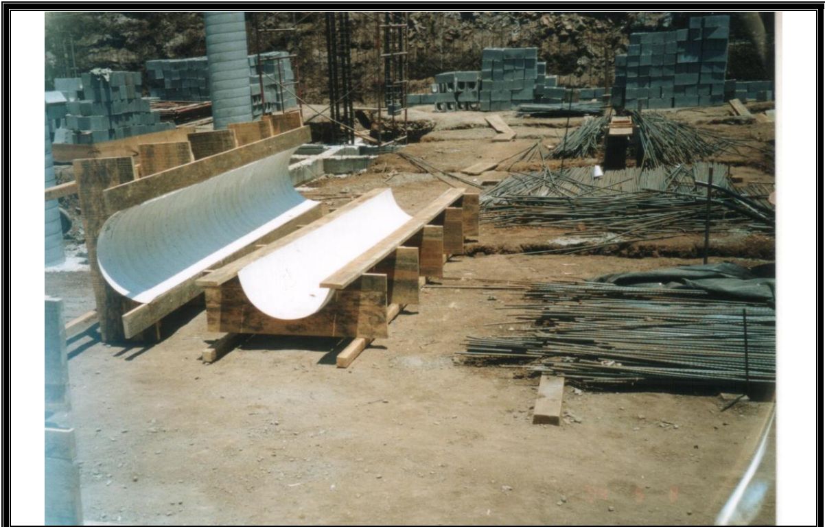
Figura 4-31: Molde para columna circular
