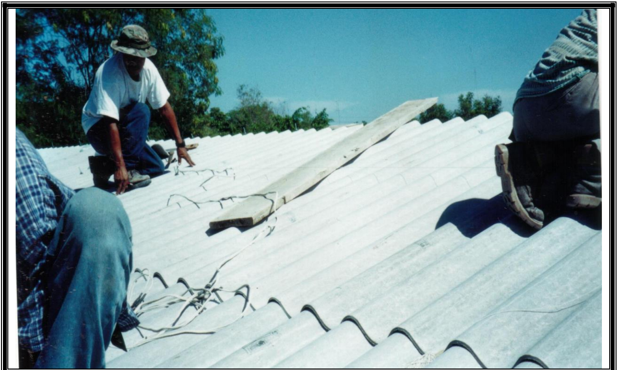
figura 6-22: Obrero revisando que las láminas estén en un mismo plano
