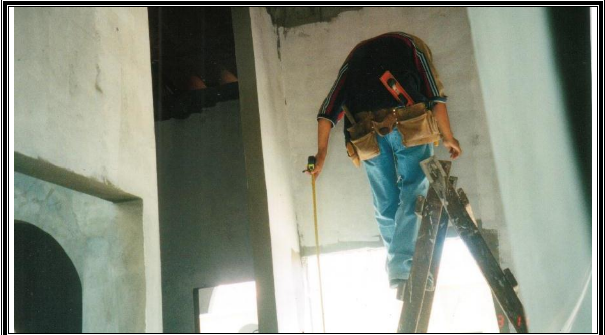
figura 6-46: Medición y marcado de nivel del cielo en la pared
