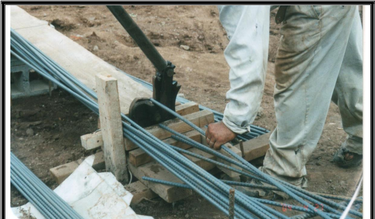
FIGURA 5 - 10: Cortado de acero longitudinal para la solera de fundación
