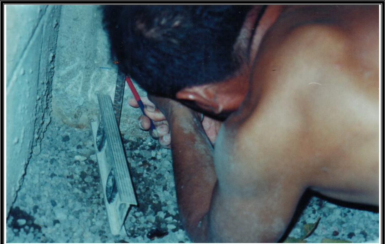
Figura 7-1: Marcado de nivel de piso terminado
