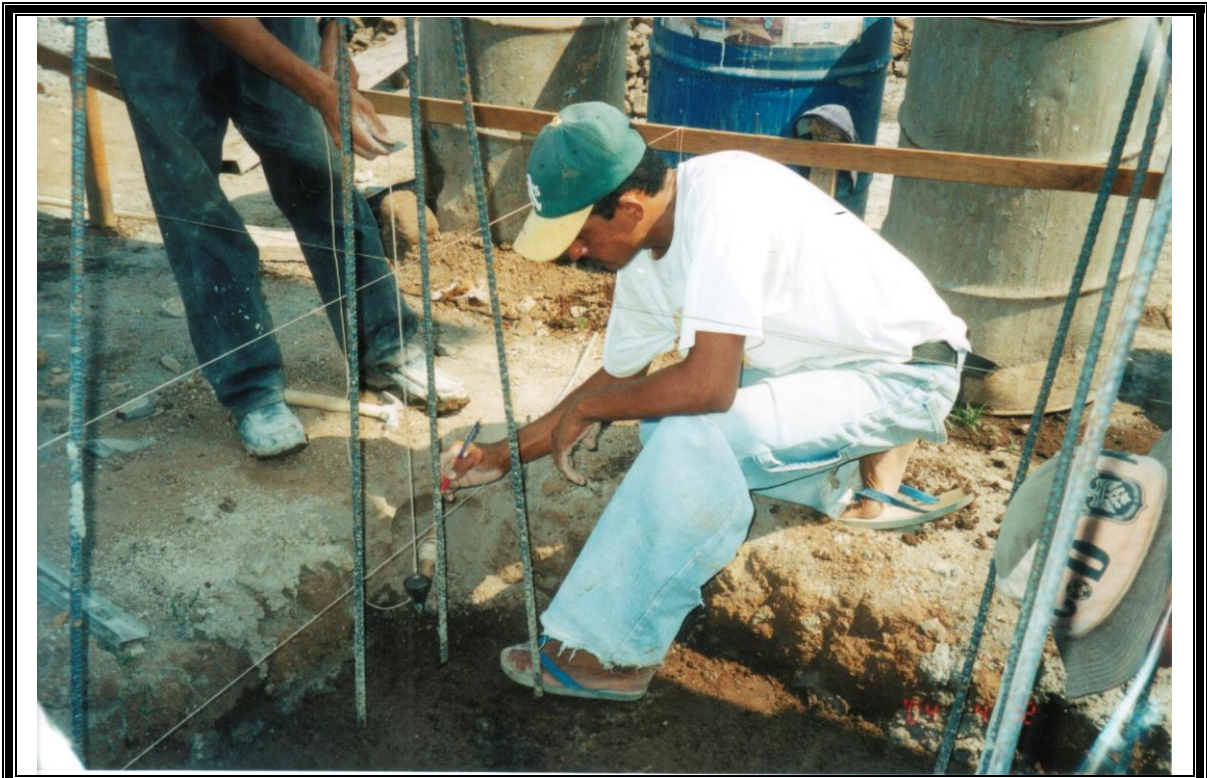
FIGURA 5 - 38: Repartición de las hiladas de los bloques a lo largo del bastón, partiendo del nivel corrido
