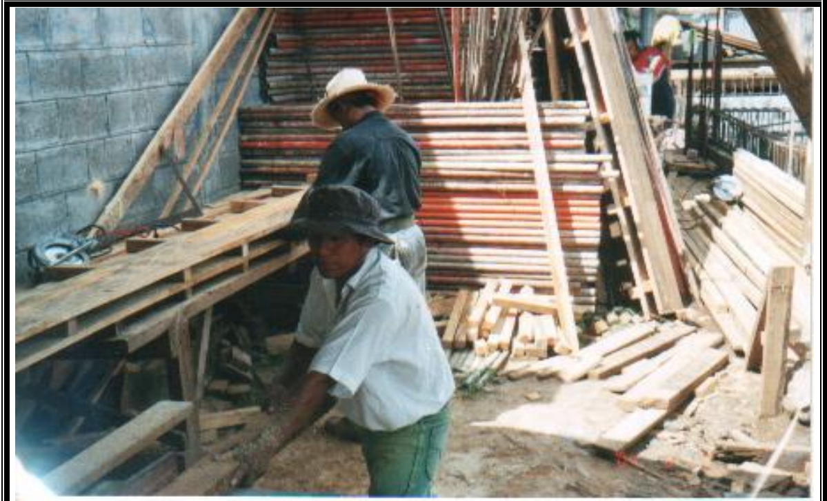
Figura 4-60: Preparacion de tablas y balules para costillas
