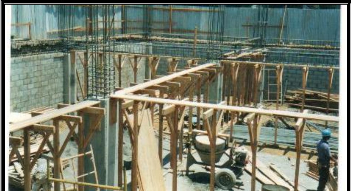
Figura 4-51: Pilotes colocados todos a plomo con el nivel de caja
