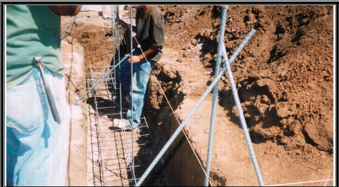
FIGURA 5 - 18: Bastones a plomo y en línea sujetos por vientos
