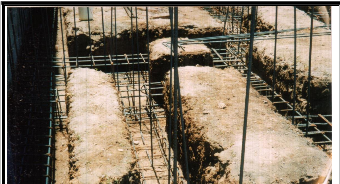
FIGURA 5 - 23: Solera de fundación lista para el colado
