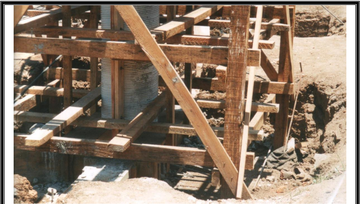
Figura 4-34: Colocacion de crucetas en el anillo base del castillo.
