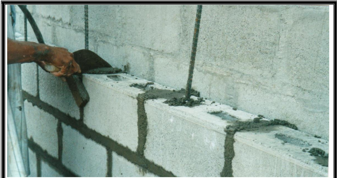
FIGURA 5 - 45: Zulaqueado de bloques haciendo uso de un pedazo de madera de forma rectangular
