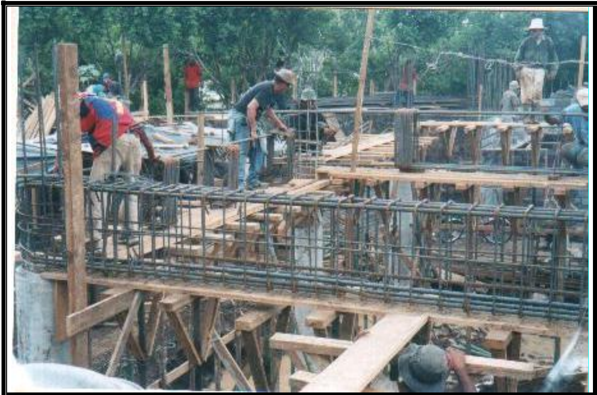
Figura 4-54: Colocacion del acero corrido del lecho superior
