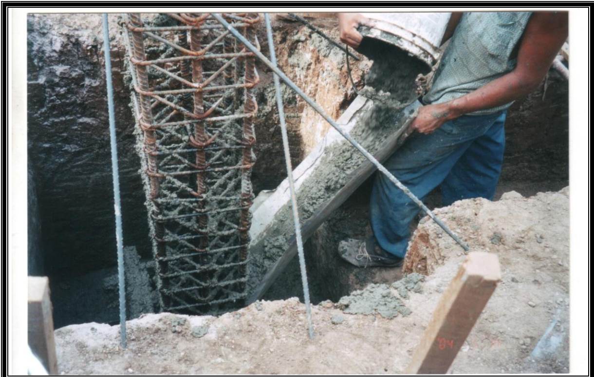
Figura 4-22: Colocación de concreto con cubeta y canaleta
