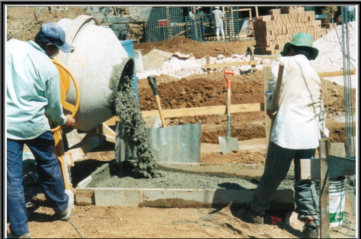
FIGURA 5 - 29: Volteado del concreto de la concretera a la batea
