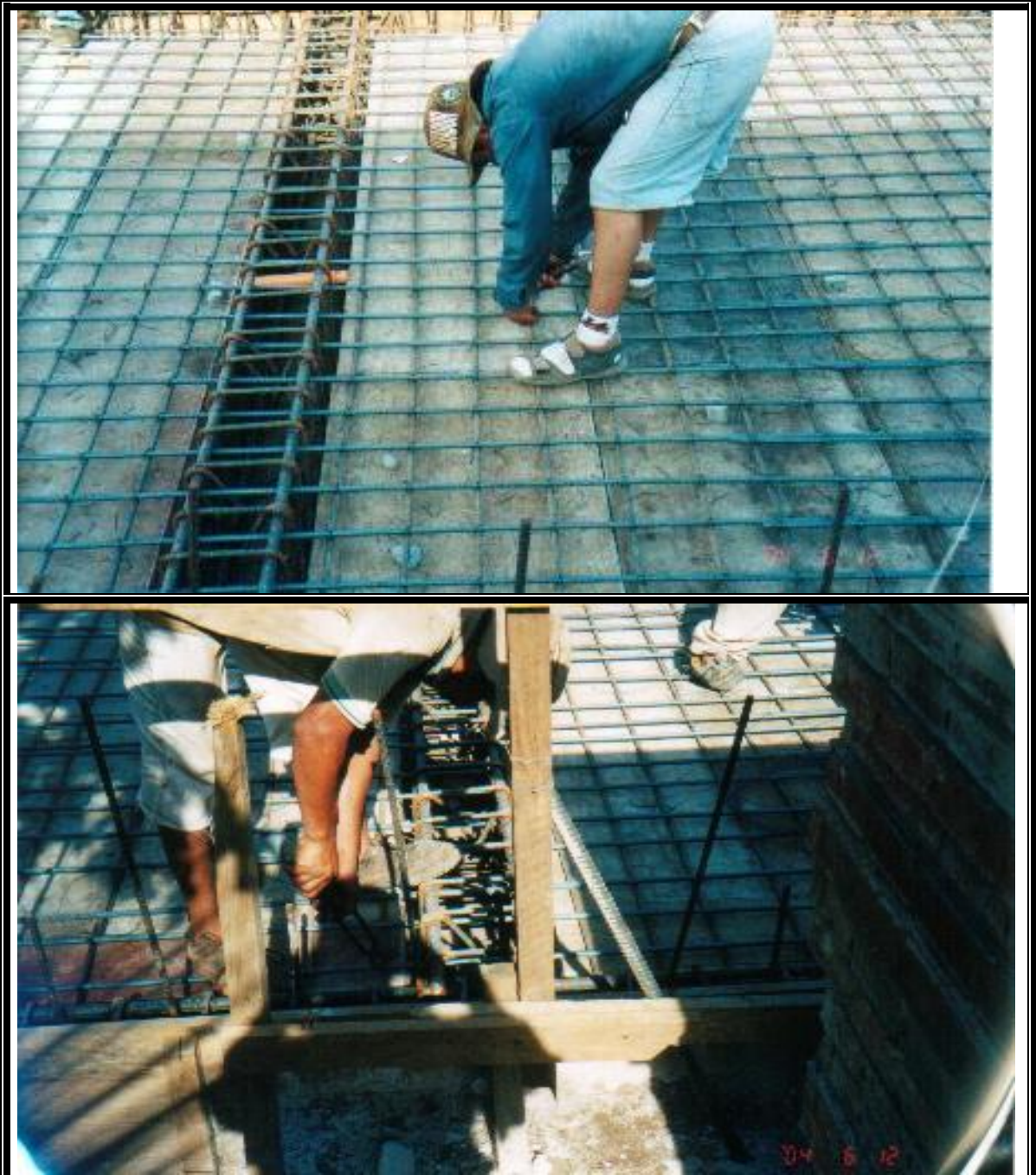
Figura 4-89: Armador terminando de amarrar la losa densa, junto con sus helados
