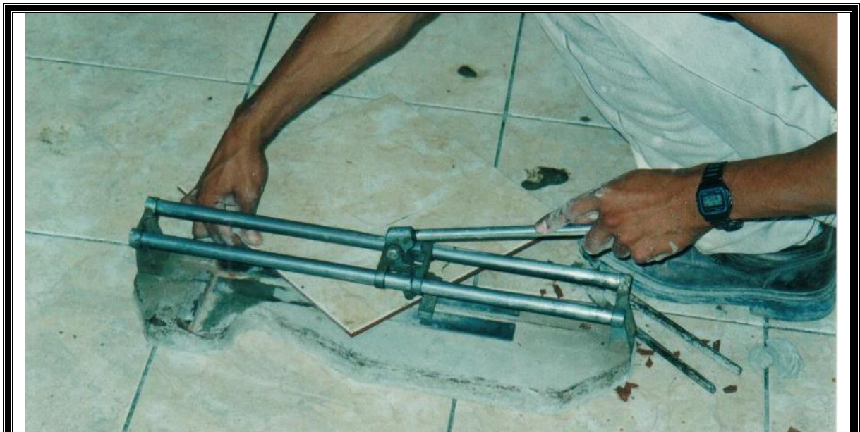
Figura 7-24: Cortado de cuchillas utilizando la cortadora
