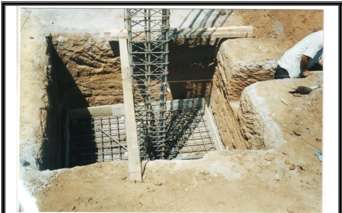
Figura 4-19: Encofrado de zapata aislada con madera
