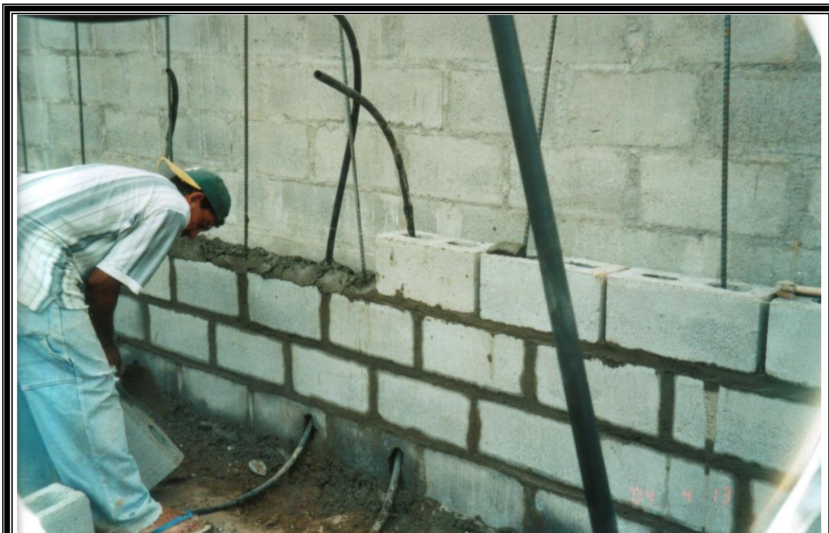
FIGURA 5 - 43: Bloques de la modulación con huecos para introducir los ductos eléctricos
