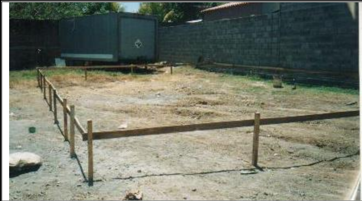
Figura 2-14: Planta trazo y replanteo de toril
