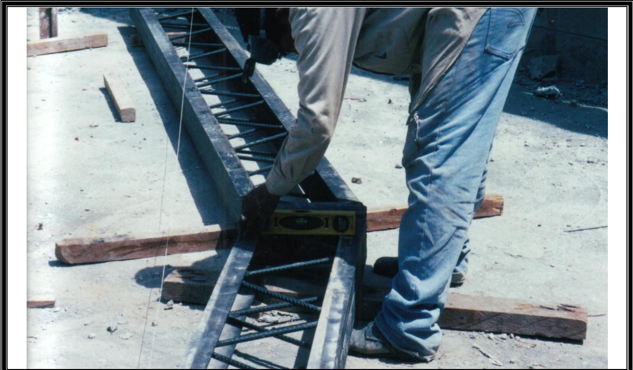
figura 6-7: Obrero comprobando horizontalidad utilizando nivel de caja
