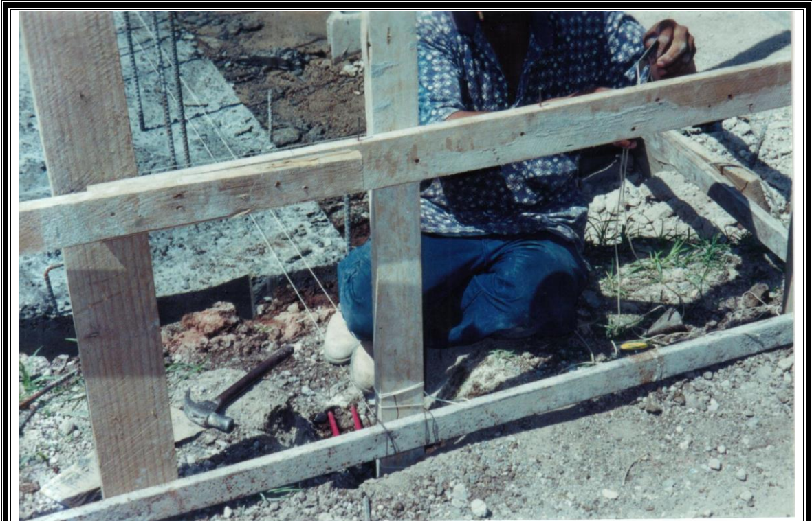
FIGURA 5 - 34: Riostra de madera amarrada, clavada y a plomo en el toril
