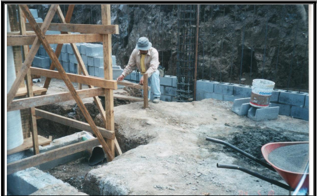
Figura 4-32: Colocación de pitas para centrado de moldes
