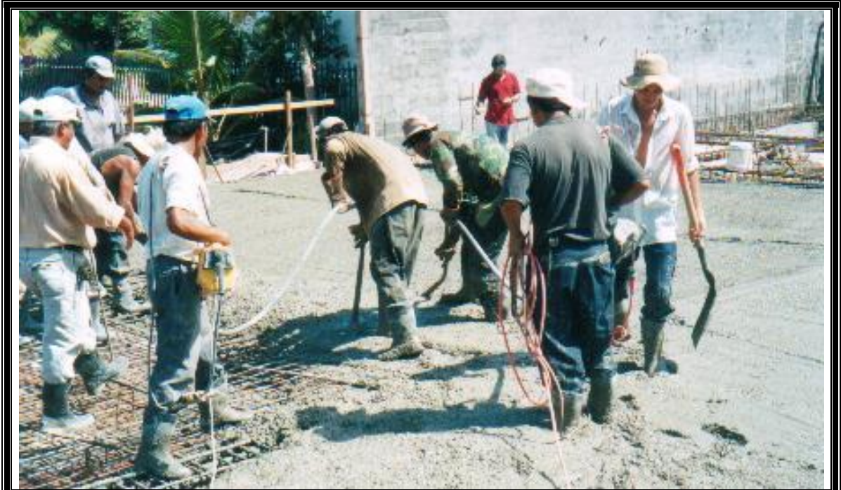
Figura 4-99: Auxiliares vibrando el concreto de acuerdo a especificaciones técnicas
