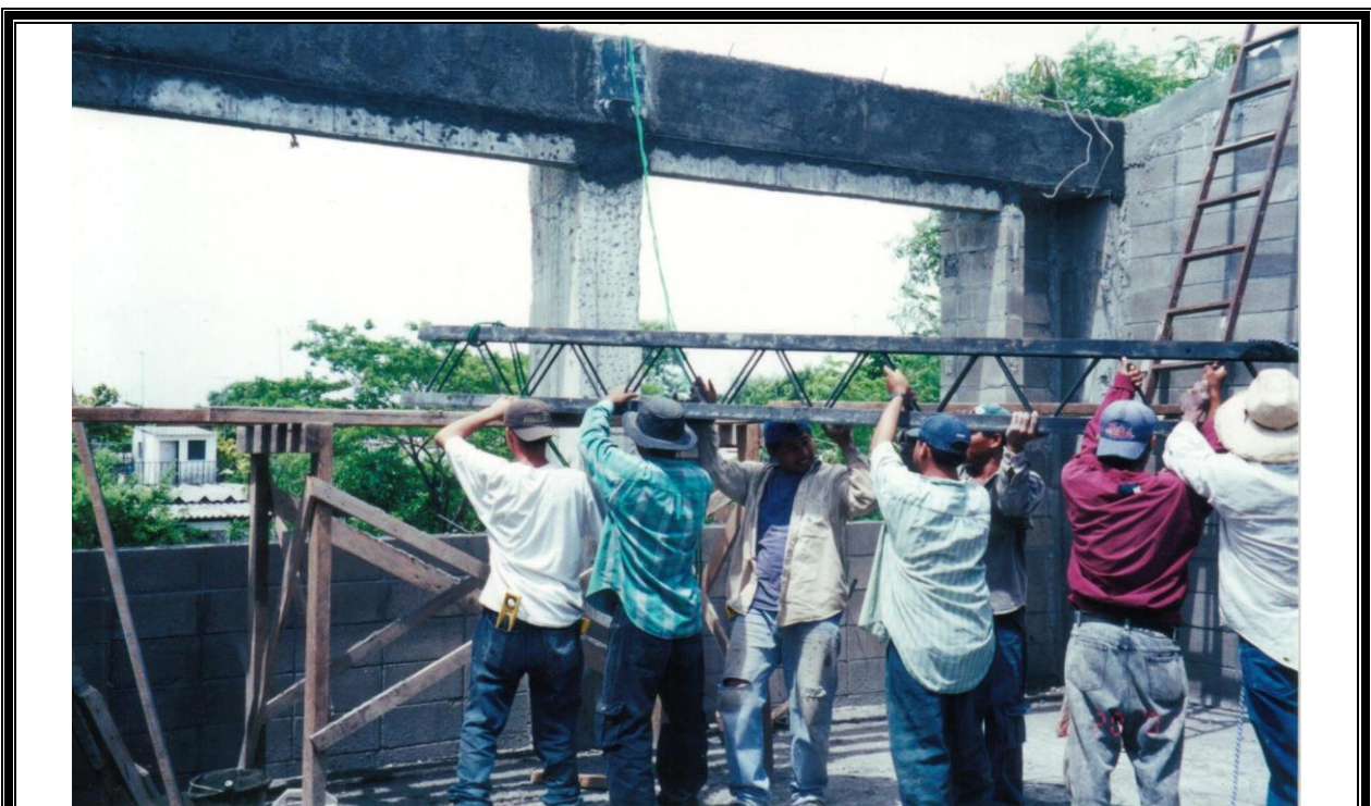
figura 6-10: Hombres cargando la viga hasta los andamios
