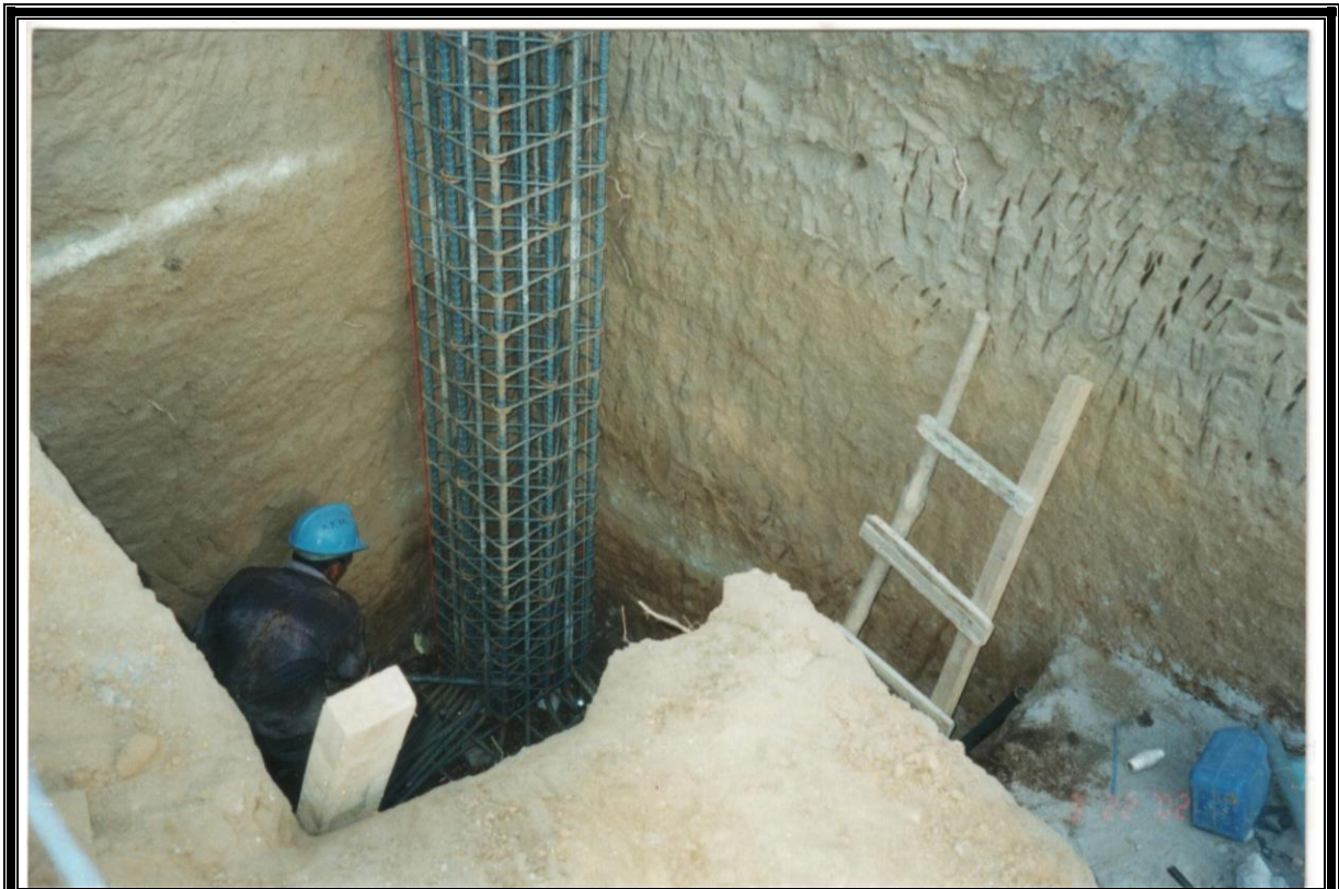
Figura 4-16: Armador moviendo la columna para colocarla a plomo
