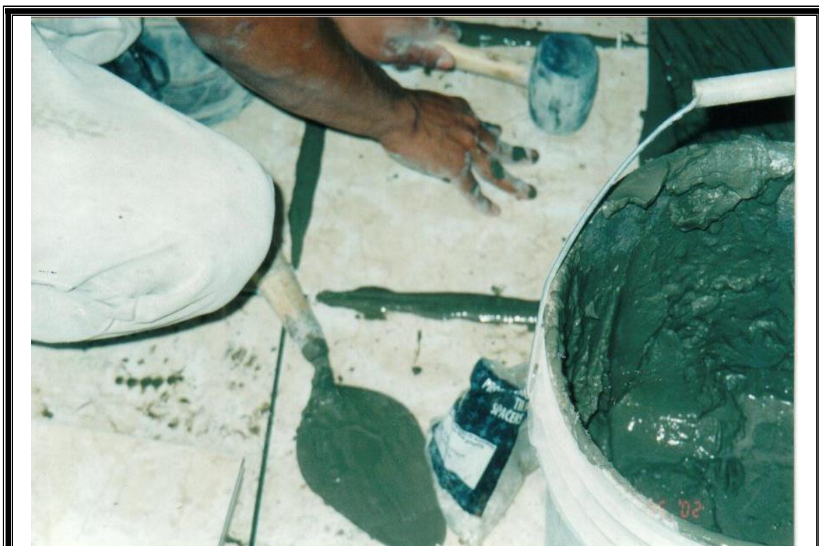
Figura 7-21: Golpeado de las piezas con martillo de hule para alcanzar el nivel requerido
