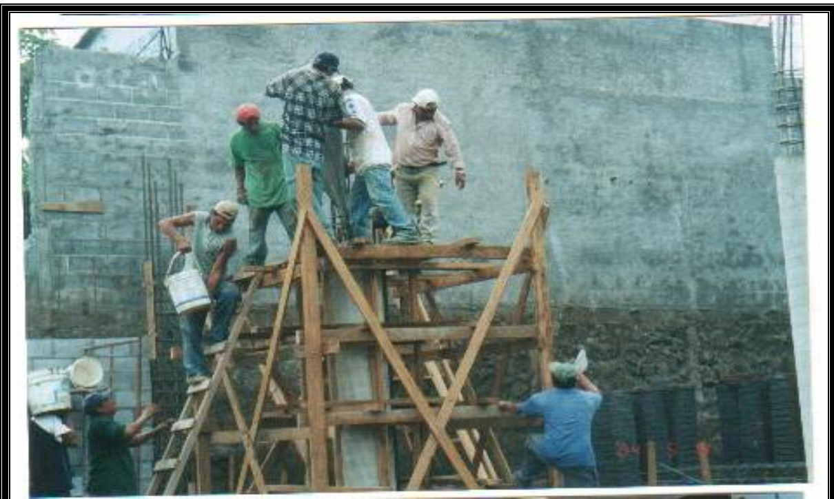
Figura 4-39: Transporte del concreto en cubetas, hacia las columnas.
