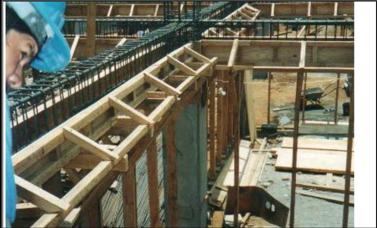
Figura 4-64: Diagonales clavadas a la misma distancia que los balules en la costilla
