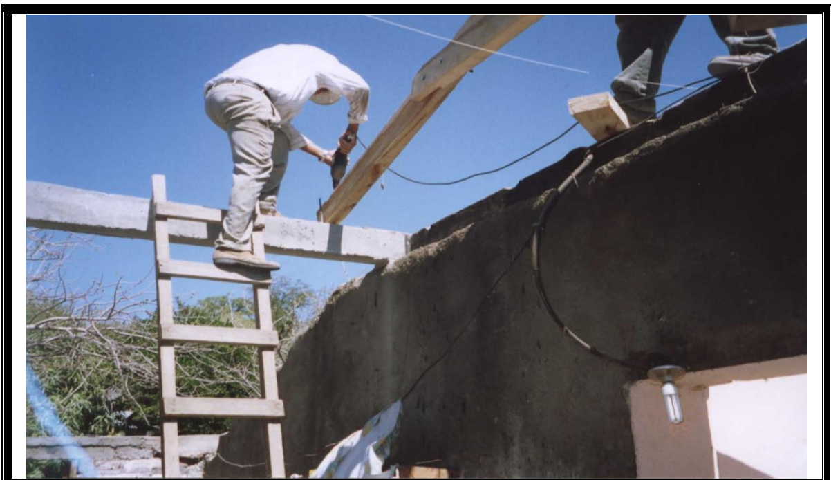
figura 6-33: Perforación de agujero con taladro
