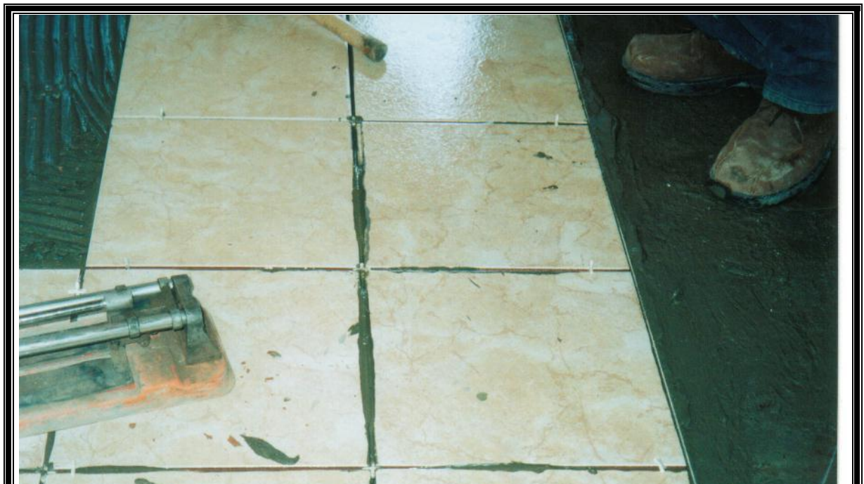
Figura 7-20: Pegamento de piezas en parejas
