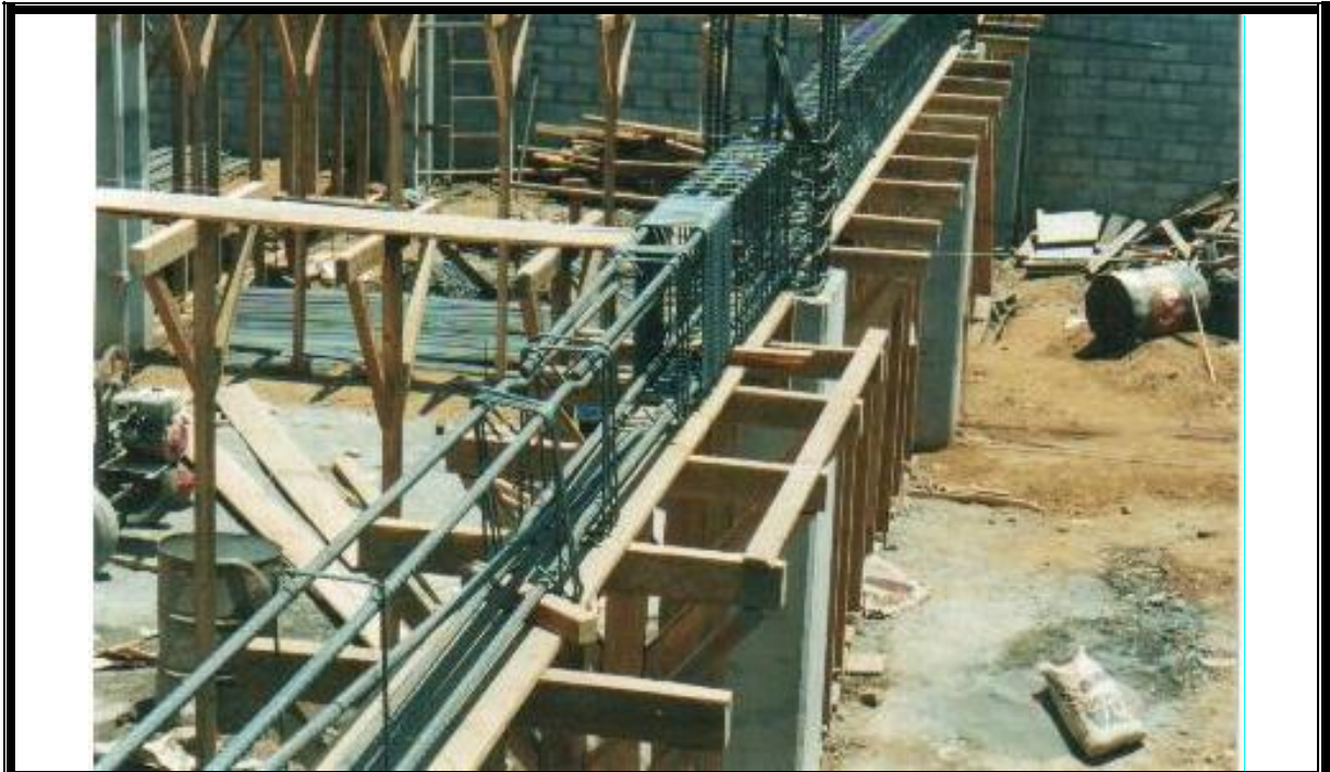
Figura 4-57: Trozos de costanera ubicada en el lecho inferior para garantizar el recubrimiento de la viga
