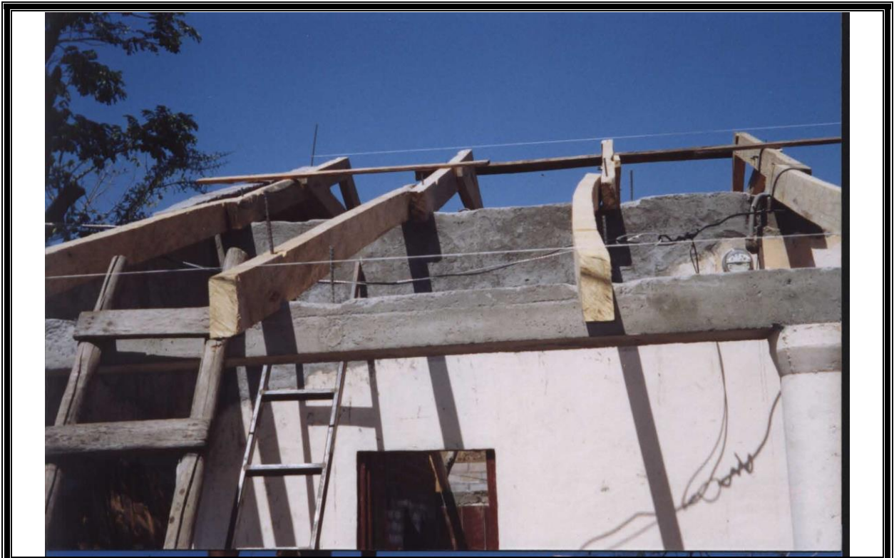
figura 6-37: Trazo del enreglado
