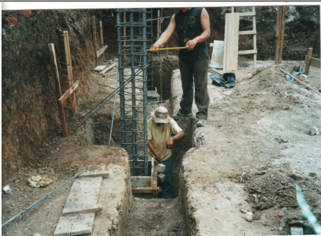
Figura 4-15: Plomeado de Columna
