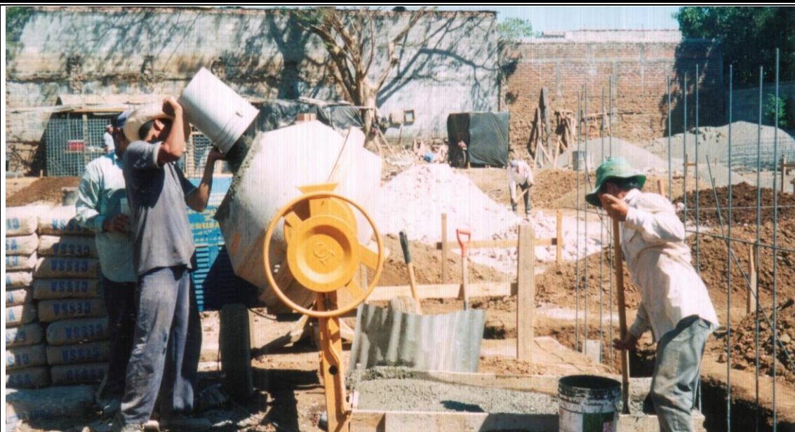
FIGURA 5 - 24: Concretera, cemento y agregados situados cerca de la solera a colar
