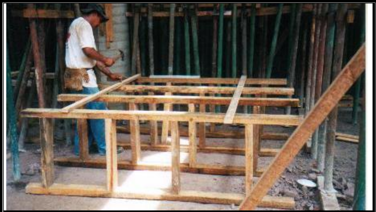
Figura 4-78: Burros de madera para salvar la altura entre el terreno y los burros para la losa densa
