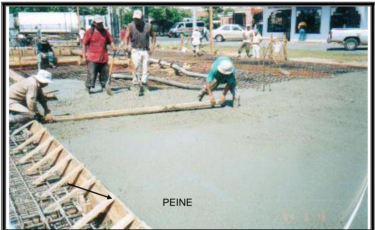
Figura 4-100: Peineta colocada con el objeto de marcar la junta de colado y aproximadamente a 45
