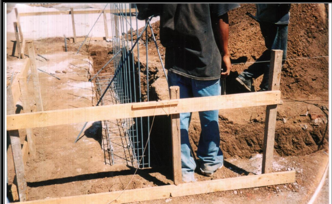
FIGURA 5 - 22: Varilla horizontal sujetando todo el refuerzo vertical
