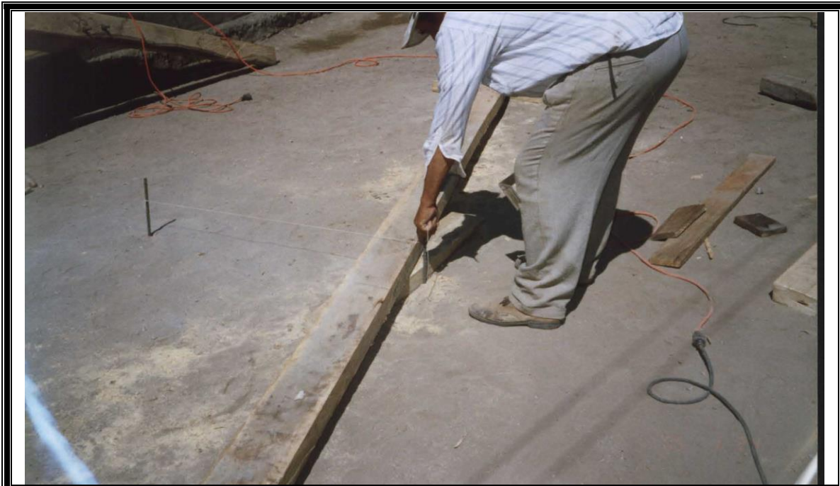
figura 6-29: Marcado de la falsa escuadra en cuartón
