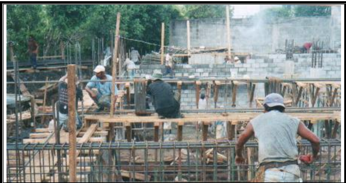
Figura 4-55: Sujecion provisional de algunos estribos
