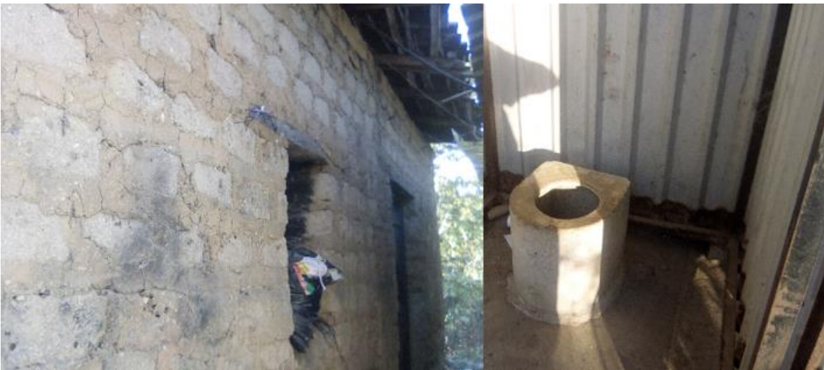
Figura 8. Vivienda construida con adobe y letrina de fosa en el Caserío Los Elizondos.
