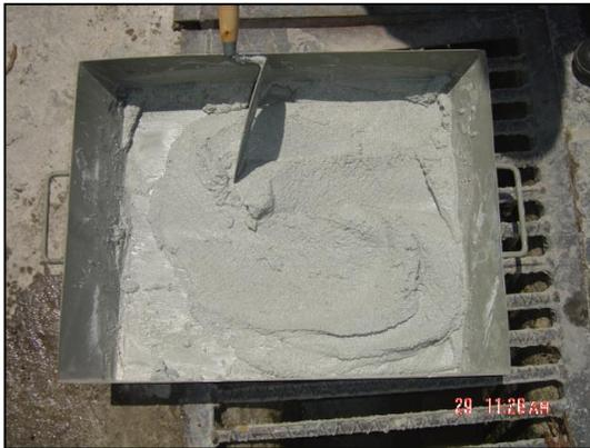
*Fig 30. Mezcla de mortero pigmentada para el llenado de los moldes de madera.*
