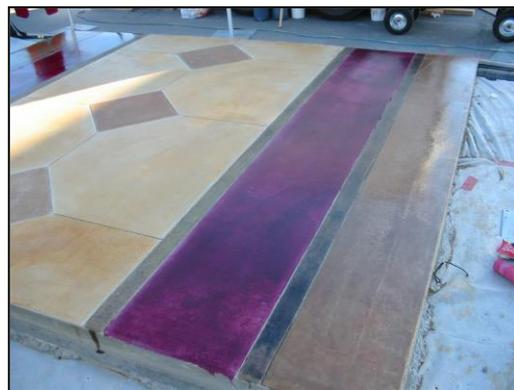
*Fig 17. Aspecto marmoleado en Concreto (izquierda), y Combinación de Colores Mediante la aplicación de soluciones ácidas*
