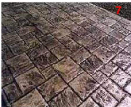
Fig 19. Secuencia de proceso de construcción de un pavimento de concreto hidráulico, estampado y coloreado con un tratamiento en seco. 1) Preparación del Terreno, 2) Nivelación y Allanado, 3) Espolvoreo Manual, 4) Estampado del concreto, 5) Limpieza del concreto, 6) Sello Acrílico y 7) Piso Terminado.
