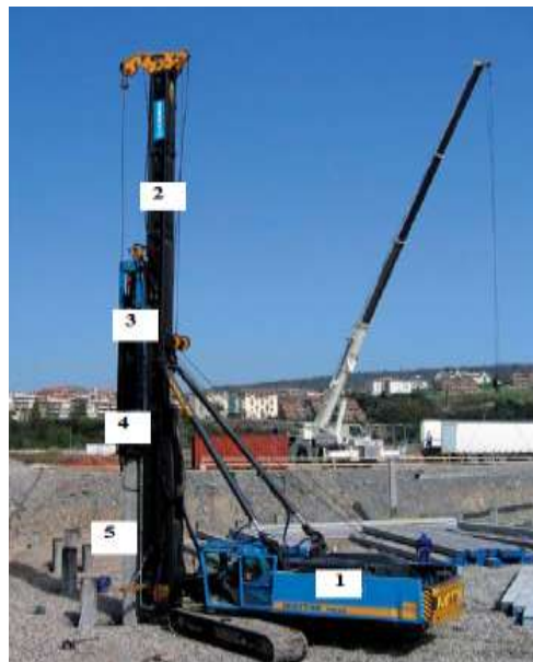
Figura 4.14. Hincado de pilotes, 1) grúa, 2) guía, 3) martillo, 4) amortiguador 5) pilote.
