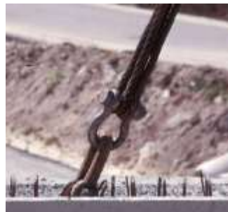
Figura 4.13. Vista de estrobos y grilletes
