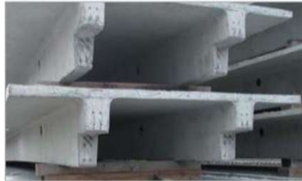
Figura 3.16. Vigas doble T con peralte reducido o recortado.
