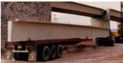
Figura 4.2. Tractocamión con remolque unido a trabe
