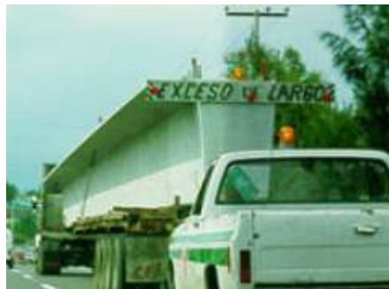
Figura 4.5. Unidad de pilote
