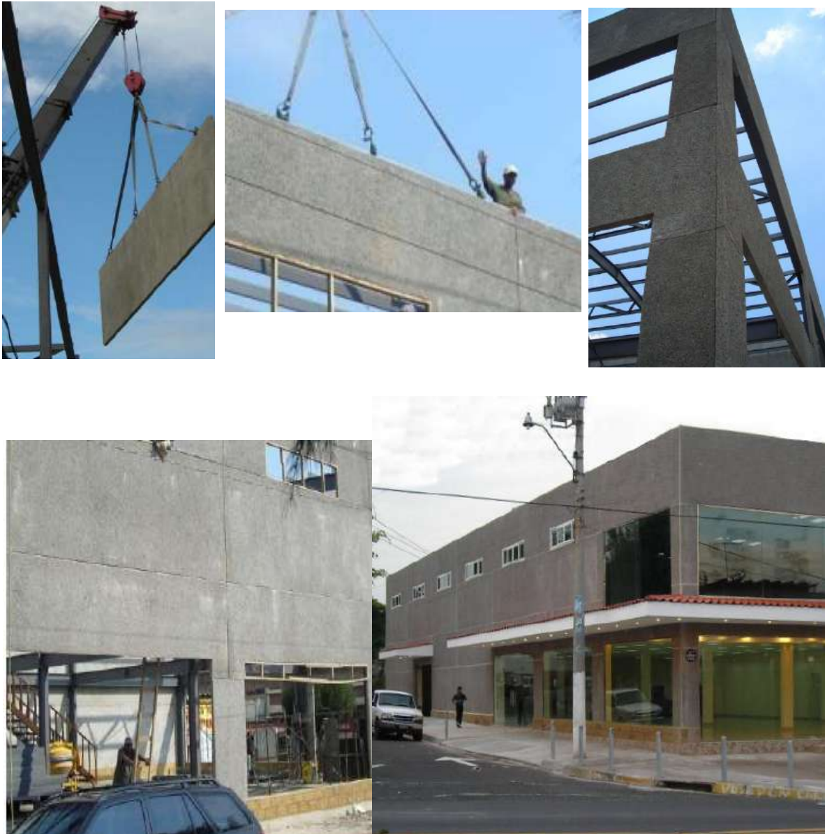
Figuras 4.22. Procedimiento de instalación de placas (Precon)
