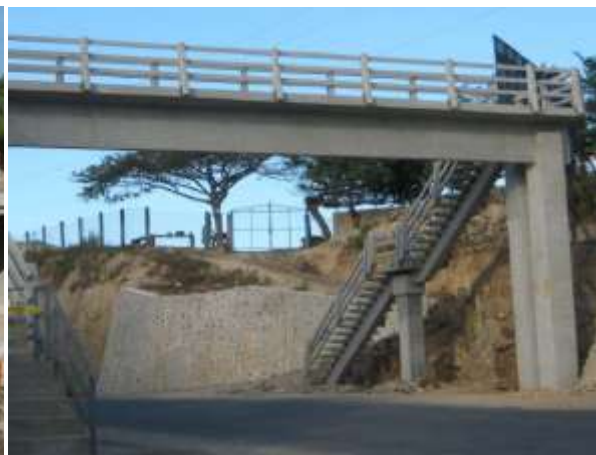
Figura 2.10. Estructura de pasarela
