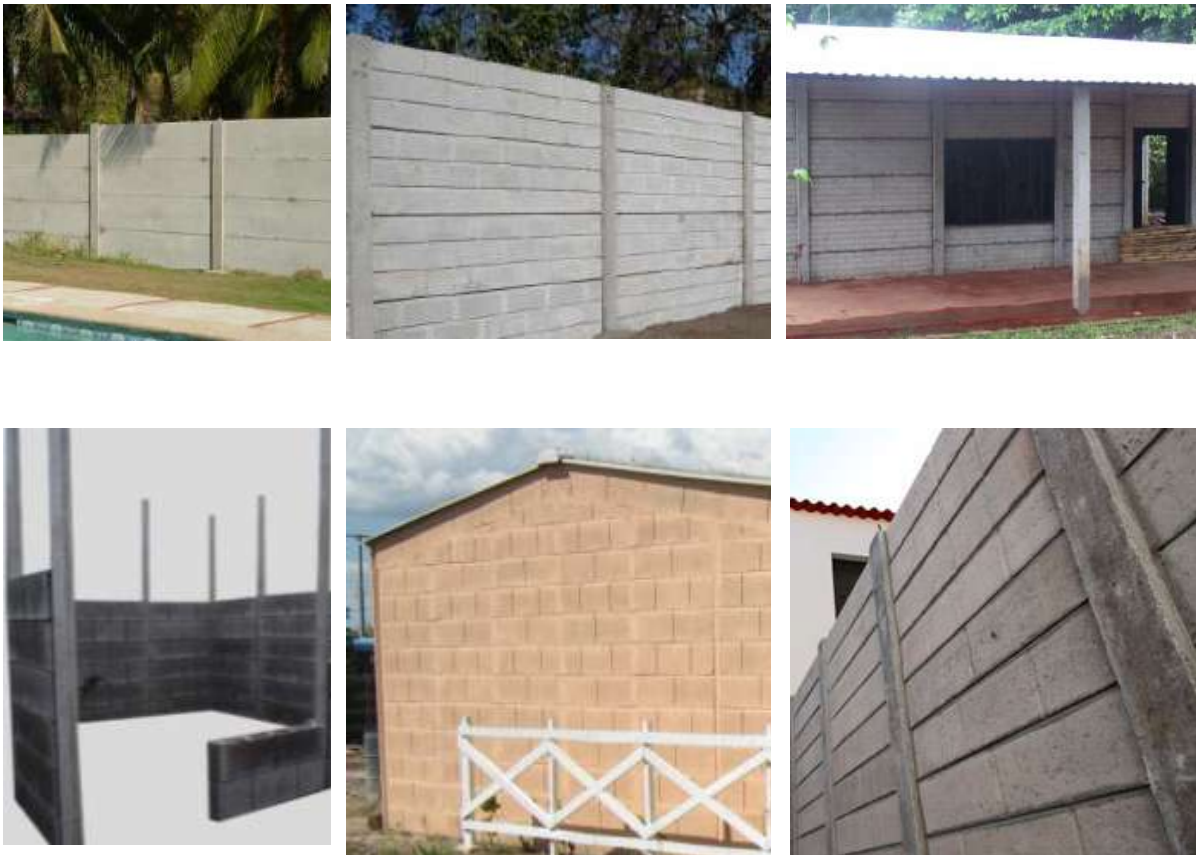
Figuras 4.21 . Diferentes imágenes mostrando el sistema columna-loseta
