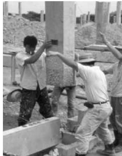
Figuras 3.1. Conexión zapata-columna mediante mortero epoxico.
