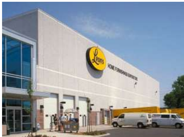
Figura 2.4. Estructura de almacén
