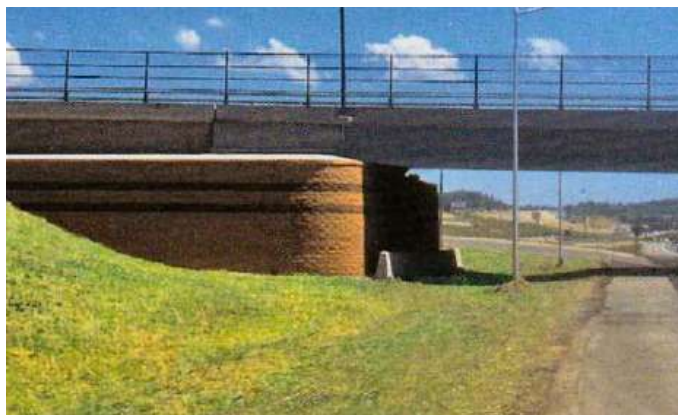
Figura 2.11. Muro de retención.
