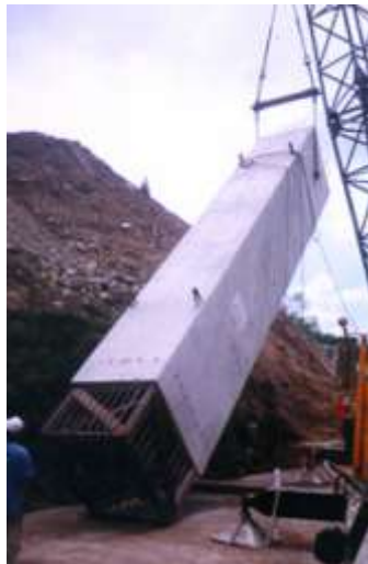
Figura 4.10. Montaje de columna para puente utilizando balancín y perno de izaje.
