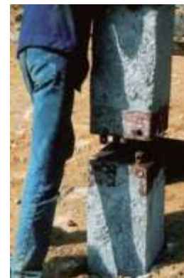
Figura 3.4 Algunas de secciones de pilotes mas comunes y Conexión de pilotes mediante extremos metálicos.
