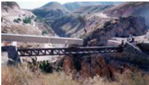
Figura 4.12. Armadura de montaje
