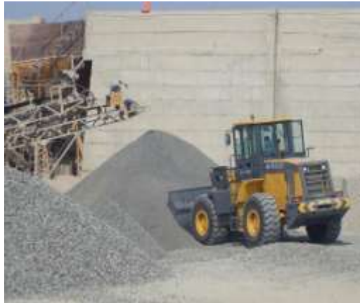
Figura 2 12. Agregados para concreto
