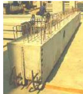
Figuras 3.8. Viga prefabricadas compuestas (la 1ª y 3ª en forma de U, la 2da con acero superior descubierto para formar unión monolítica con la losa)
