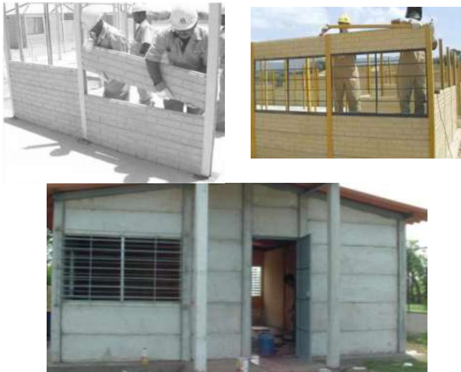
Figura 3.21. Paredes motables manualmente, sin necesidad de gruas o cualquier otro maquinaria.
