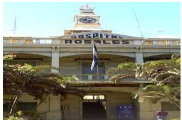
Figura 1.1 Edificio, Hospital Rosales
