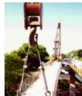
Figura 4.13. Vista de estrobos y grilletes
