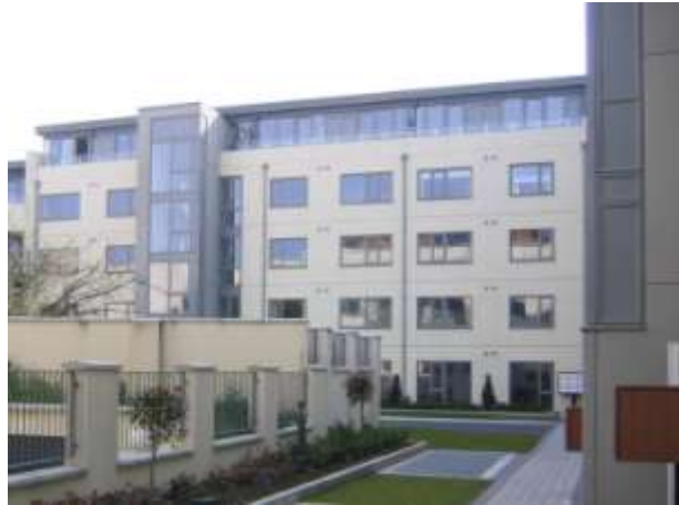
Figura 2.3. Edificio de oficina
