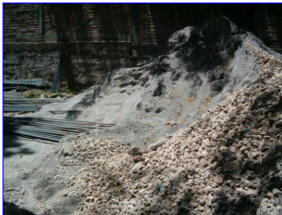
Fig. 50 Grava, arena y acero de refuerzo en el mismo depósito.
