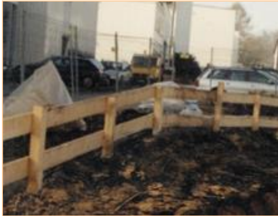
Fig. 87 Vallado de seguridad
