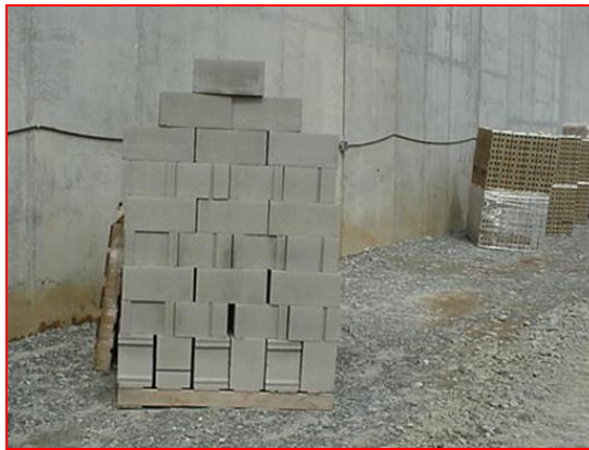
Fig. 55 Correcto almacenamiento de bloques
