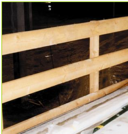
Fig. 91 Protección lateral
