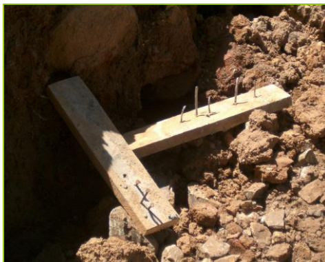
Fig. 58 No dejar clavos en los trozos de madera
