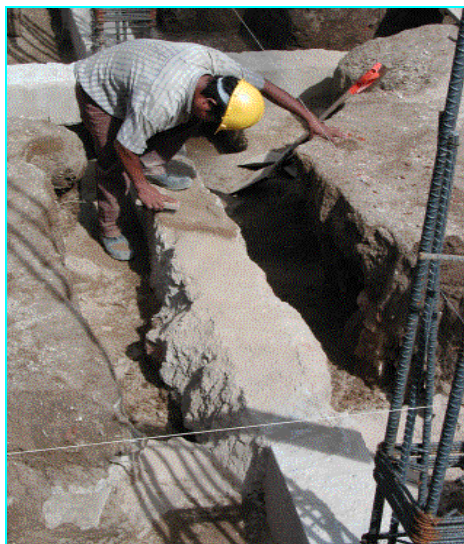
Fig. 3 Mal colado de solera de fundación
