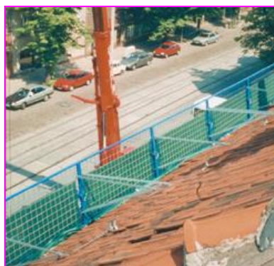
Fig. 93 Protección en superficies inclinadas
