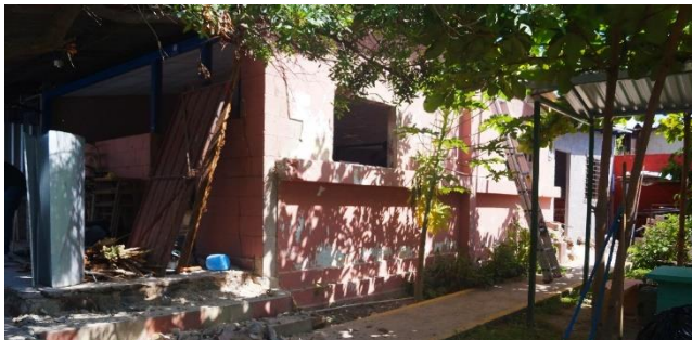
Aulas en construcción.
