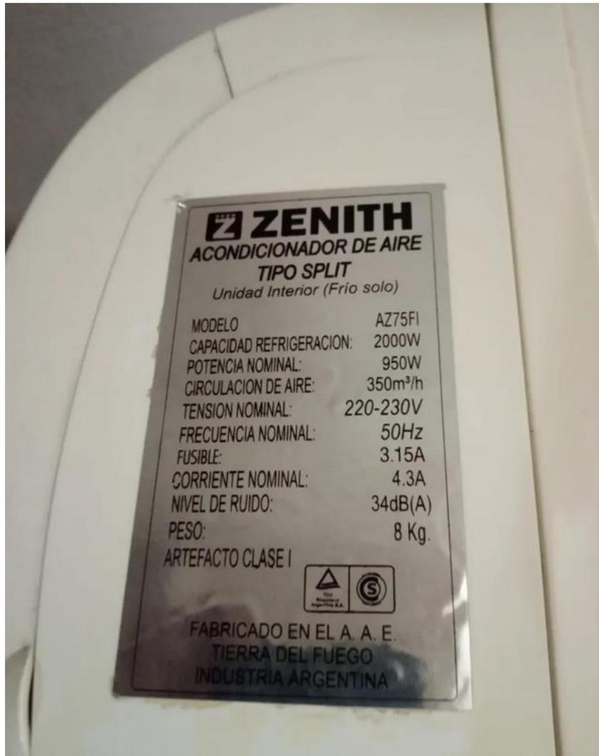
Figura 2-3: Características técnicas del modelo de aire acondicionado a compresión mecánica, de referencia.
