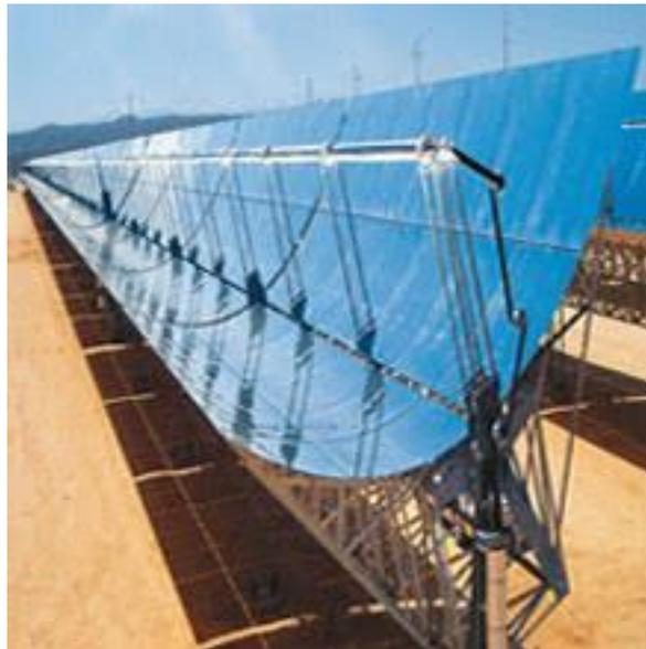
Figura 1-24: Colector solar parabólico («Concentrador Solar - Tubo calo-portador», 2018).
