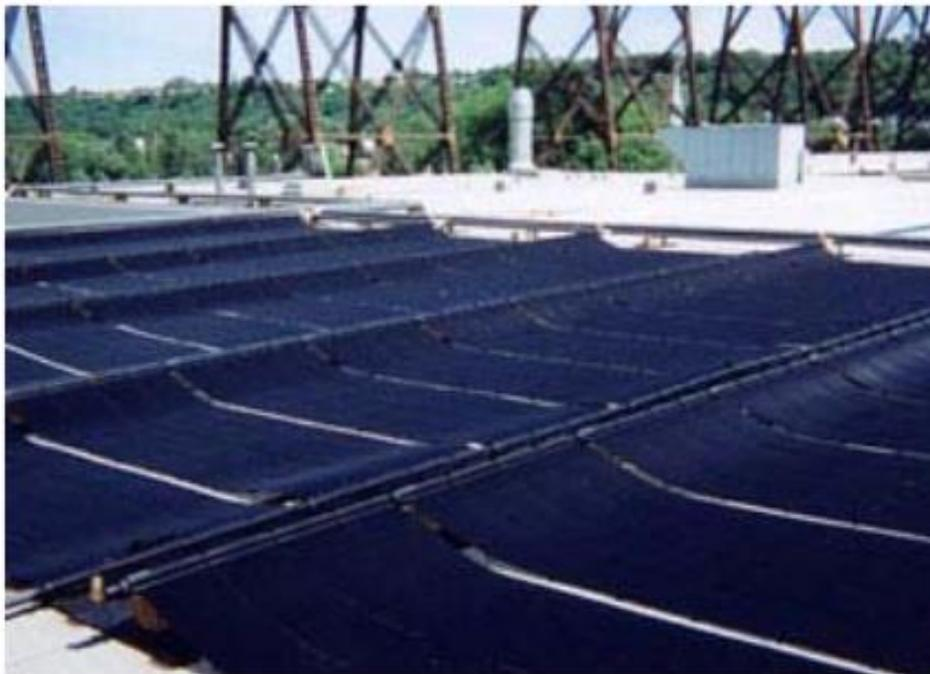
Figura 1-23: Colector de placa plana sin cubierta (Orna Hernández, 2012)
