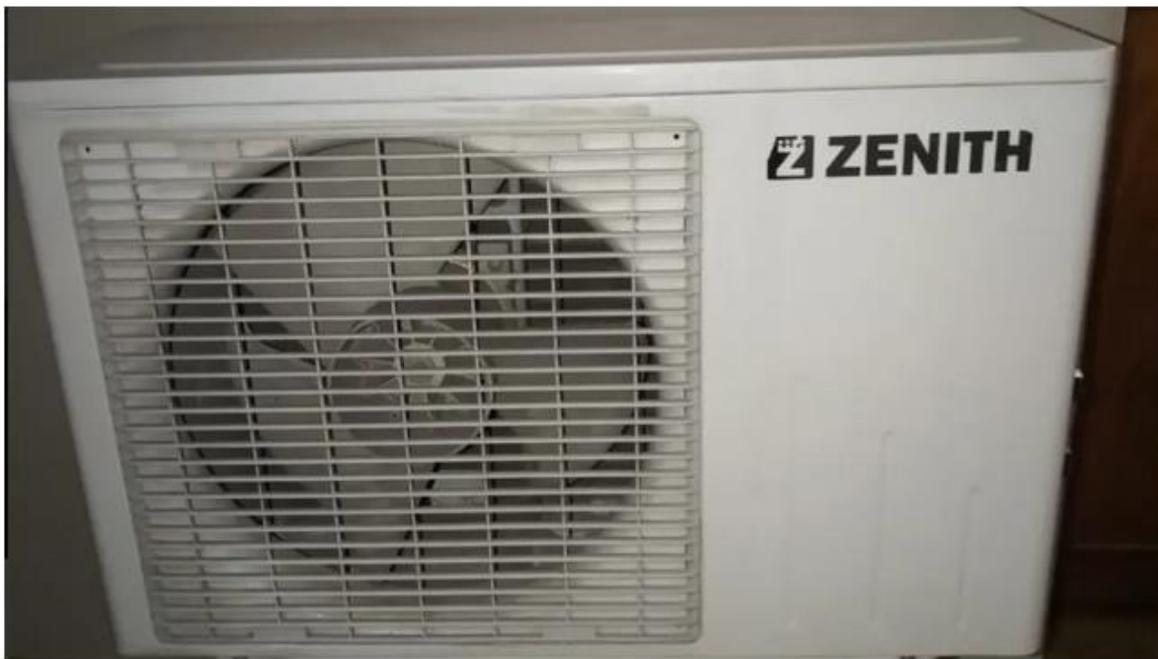
Figura 2-5: Condensador del modelo de aire acondicionado a compresión mecánica, de referencia.
