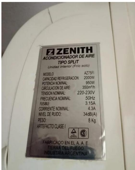
Figura 5-37: Características técnicas del modelo de aire acondicionado a compresión mecánica, de referencia.
