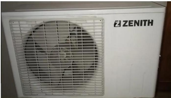
Figura 5-39: Condensador del modelo de aire acondicionado a compresión mecánica, de referencia.
