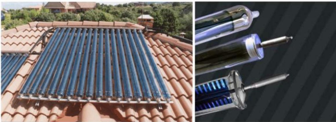
Figura 1-29: a) Colector Solar de Tubo de Vacío Heat Pipe («Captadores TUBOS DE VACÍO», 2020). b) Distintos tipos de Tubos de Calor («Captadores TUBOS DE VACÍO», 2020)
