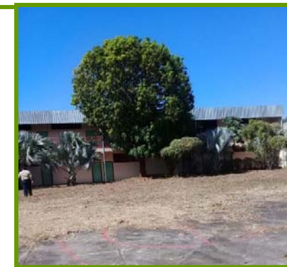
Imagen 19. Fachada principal de la edificación existente.
