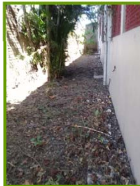
Imagen 16. Costado este del terreno, fachada posterior de la edificación existente.
