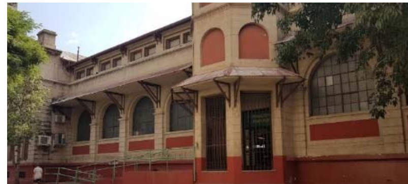
Imagen 30. Detalle de accesos, fachada Este del Registro Civil de Córdoba.
