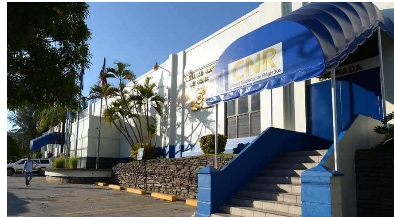
Imagen 10. Fachada principal del Centro Nacional de Registros sobre la 1a Calle Poniente, San Salvador. Fuente: https://goo.gl/maps/pCBG356eBKr2ziKk7
