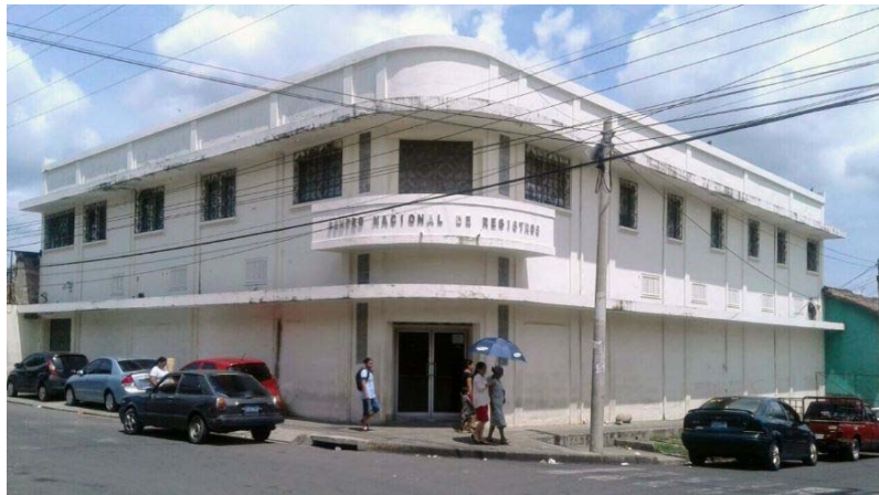
Imagen 12. Instalaciones CNR La Paz.
