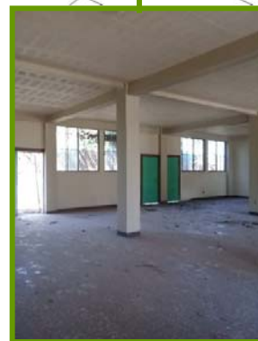
Imagen 17. Interior primera planta de edificación existente, ex Liceo Viroleño.
