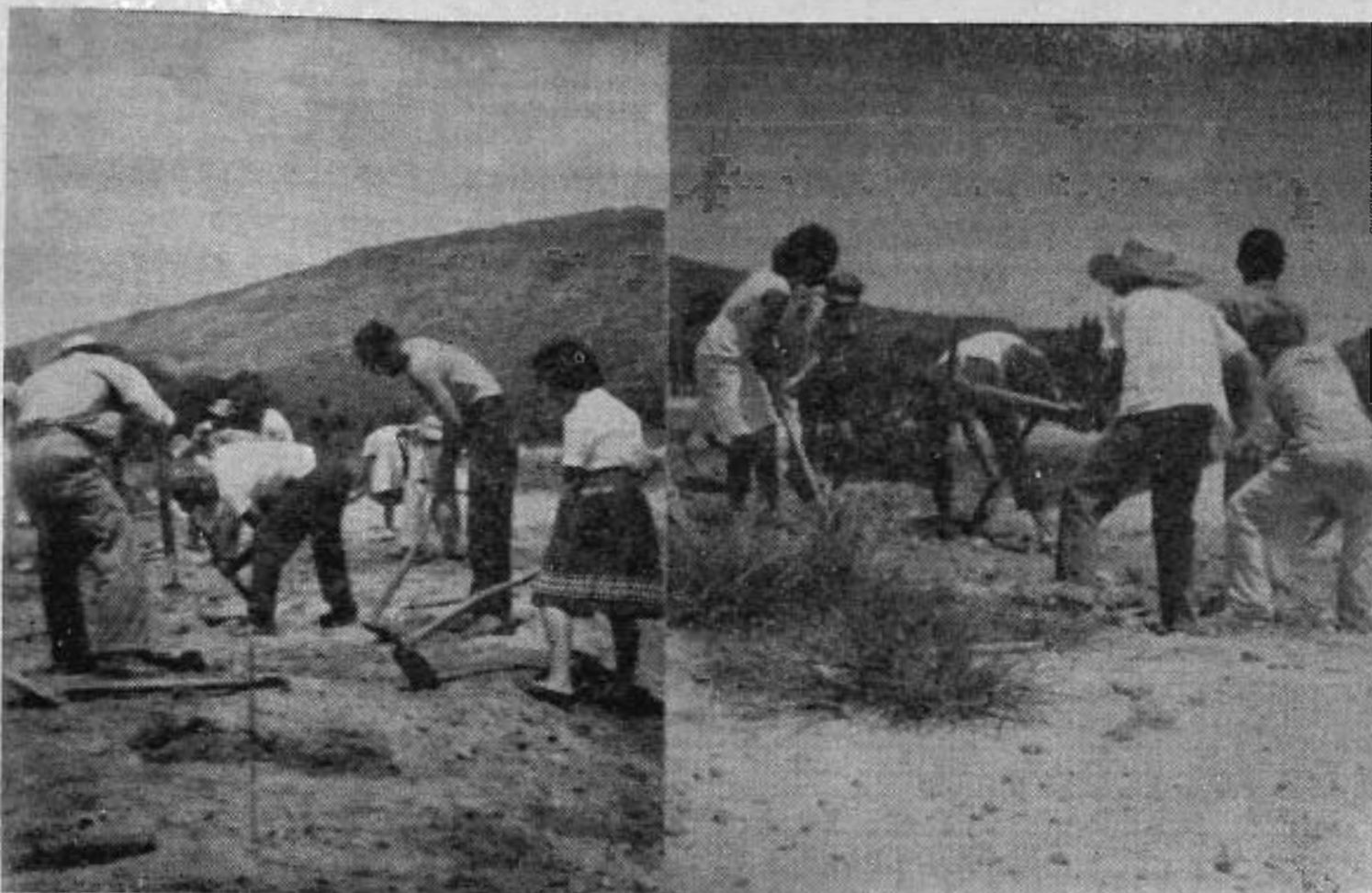
TRABAJAN EN TERRACERIA.—Grupo de trabajadores voluntarios laborando activamente en el predio contiguo al edificio de la Rectoría, lado norte, en donde se ha comenzado a sembrar flores y árboles ornamentales. La terracería de esa sección prácticamente ha quedado concluida.
