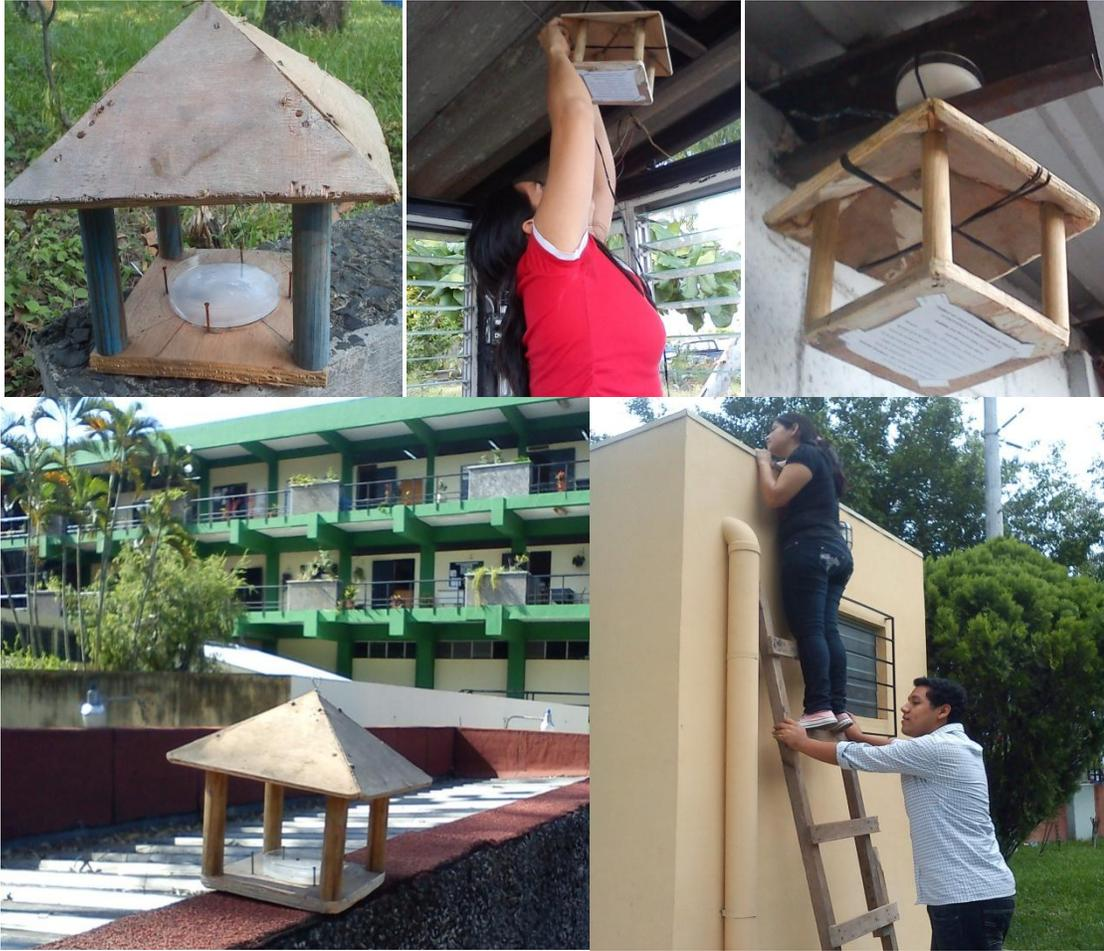
Figura N° 22 Colocación de las Placas Receptoras en algunos de los sitios de muestreo
