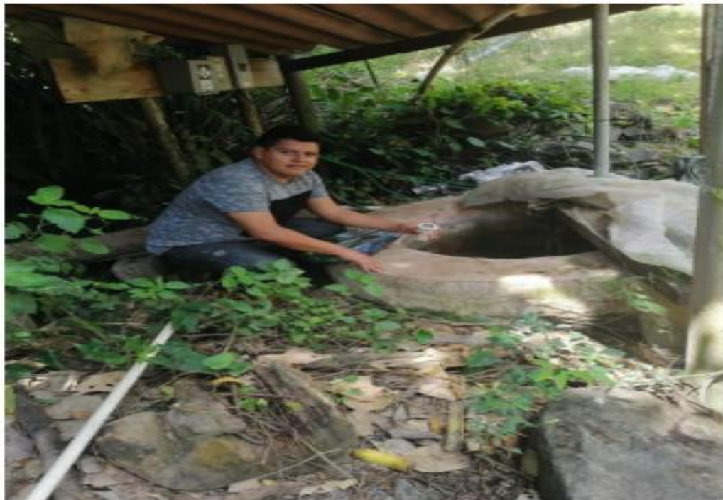
Anexo A8. Pozo artesanal que abastece de agua potable todas las instalaciones de la finca Buena Vista
