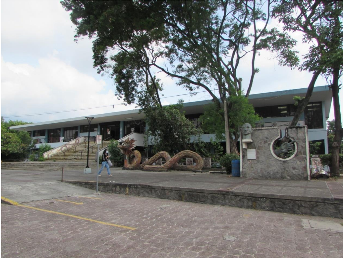
VIII. Imagen 8. Fotografía del exterior del edificio de la Escuela de Artes, UES. Tomada por Luis Monterrosa, 2021.
