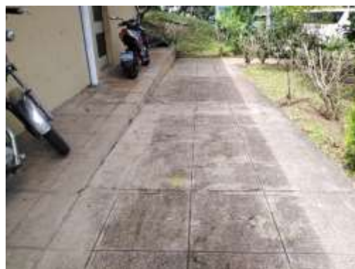
Ilustración 6: Rampa de acceso peatonal actual
