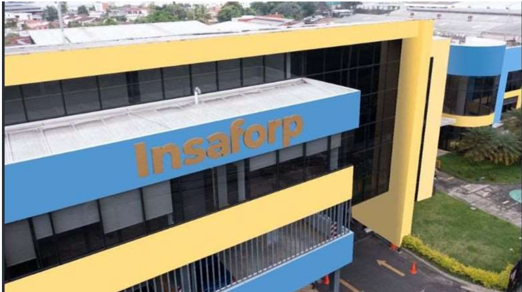
a) Edificio del Parqueo
