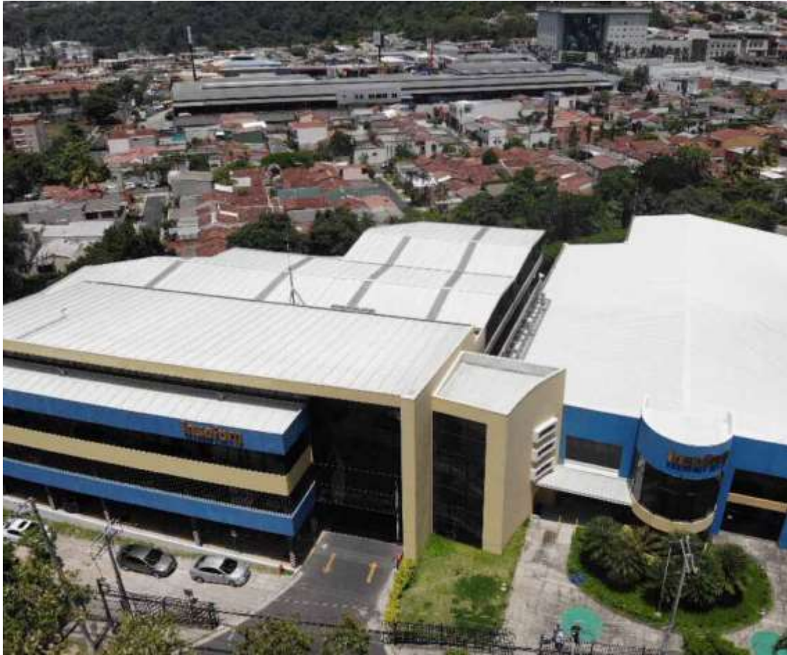
Figura 3.1. a) Edificio de Parqueo y b) Edificio de Oficinas del Insaforp.
