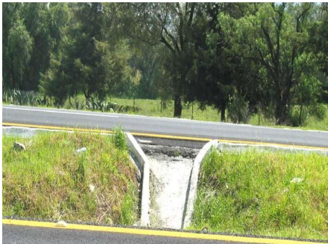
**Ilustración 2.3.** Lavadero que descarga el agua lluvia hacia canal natural al costado de la carretera, fuente base Google imágenes, [www.google.com](http://www.google.com), 2021.
