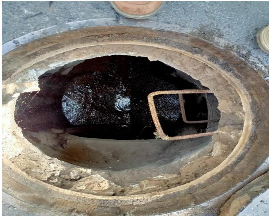
**Fotografía 4.2** Verificación de altura de pozo y del estado en su interior para decidir si es punto de introducción del robot. Fuente: Elaboración propia.
