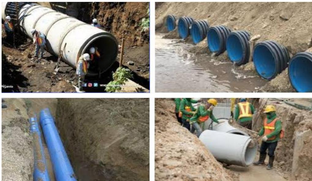
**Ilustración 2.5** Ejemplos de diversos diámetros de tuberías de drenaje subterráneo, elaboración propia sobre imágenes de base Google imágenes, [www.google.com](http://www.google.com), 2021.
