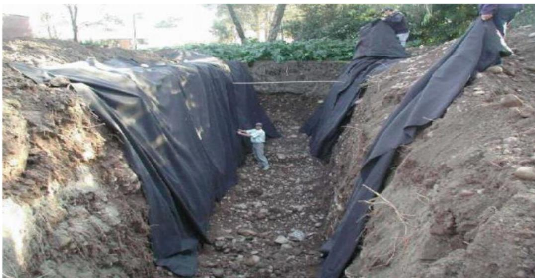
**Ilustración 2.13.** Ejemplo del Zanja de infiltración, fuente base de datos Google imágenes [www.google.com](http://www.google.com),2021
