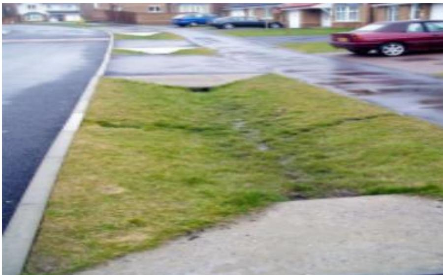
**Ilustración 2.11.** Ejemplo de zanja de pasto para bajas velocidades de flujo, civilgeeks.com (2016)
