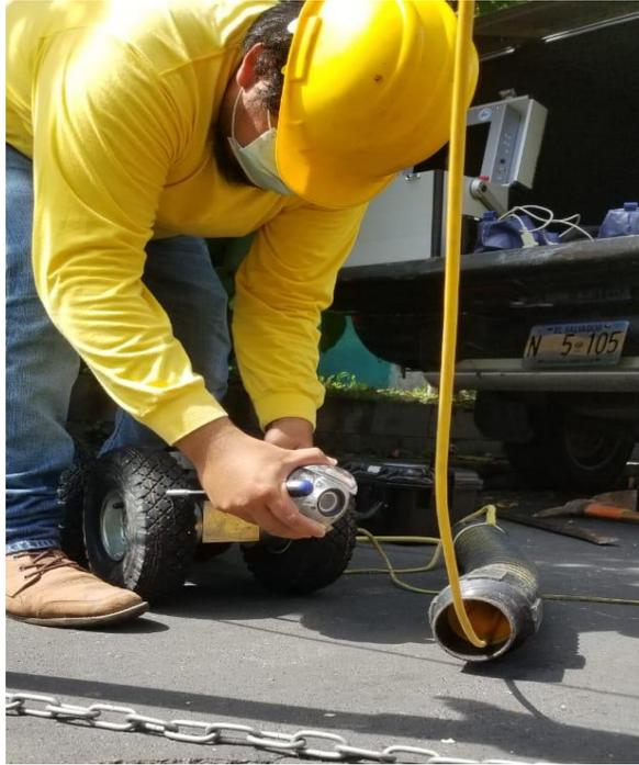
**Fotografía 4.5** Instalación de cámara al tractor en proceso de preparación para la inspección. Fuente: Elaboración propia.
