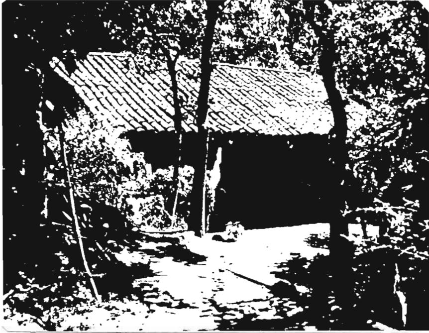
Fig. No. 6.- Vivienda con pared de bahereque y techo de teja.-
