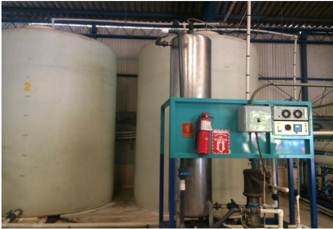
Máquina Ozonizadora y tanques de almacenamiento
