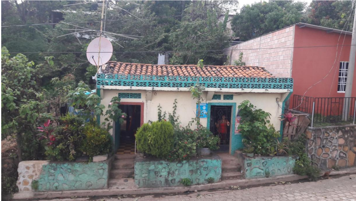
Figura 7: Vivienda semiurbana, ubicada en Barrio El Nuevo, Torola, Morazán.
