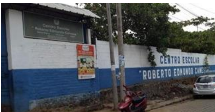
Figura 54: Centro Escolar “Roberto Edmundo Canessa” ubicado sobre el final de la 7ª Avenida Sur, Barrio El Calvario, contiguo al Instituto Nacional de Santa Elena.
