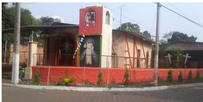
Figura 52: Parroquia El Calvario, ubicada sobre el final de la 5ª Avenida Sur y sobre la 7ª Avenida Sur, Barrio El Calvario.
