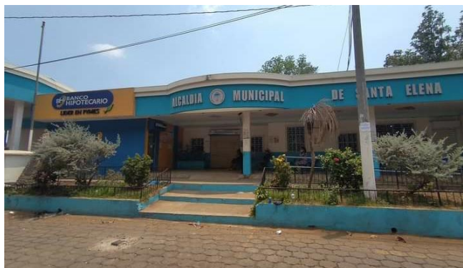
Figura 44: Alcaldía Municipal de Santa Elena, ubicada sobre la 2ª Calle Poniente, en el Barrio El Calvario.
