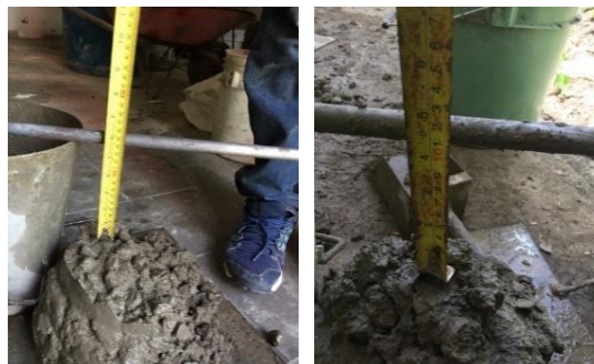
b) Medición del asentamiento del concreto.
