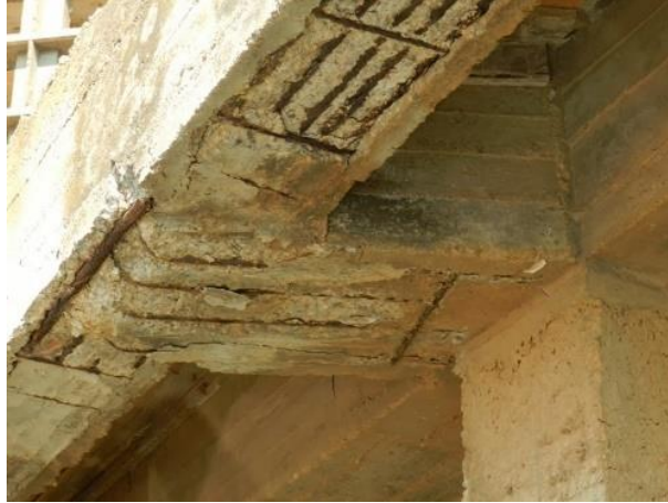
Figura 2.37: Corrosión localizada por iones de cloruro.
