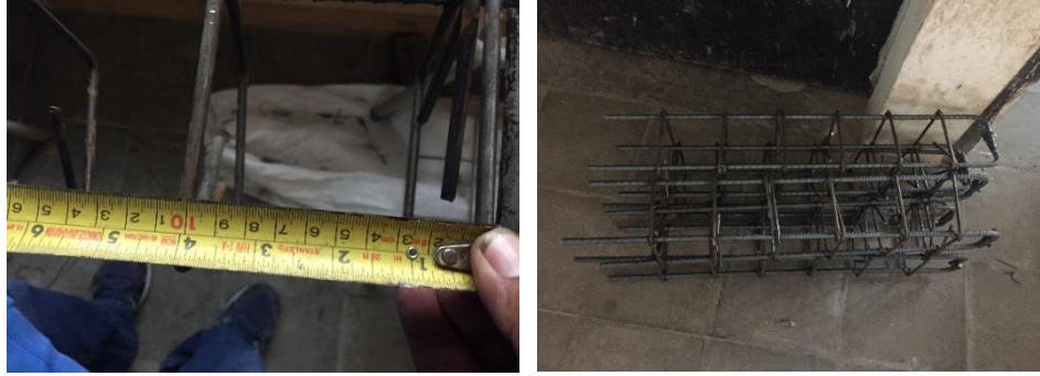
b) Preparación y armado del refuerzo según los requerimientos del ACI 318.
