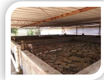
El agua residual pasa por distintos tipos de procesos, entre ellos el proceso de filtrado en donde se observan más de 2,000 filtros ubicados dentro de los tanques de la planta, en el cual llega a pasar a la separación de sólidos en una pila donde los desechos son tratados y separados del agua hasta llegar al proceso final que la transformación del agua para ser usada como regadíos.
