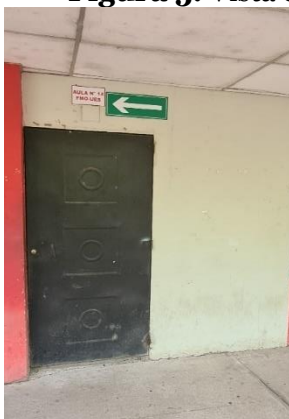
Figura 5. Vista exterior del aula 14
