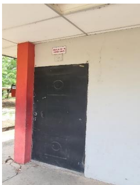
Figura 3. Vista exterior del aula 9
