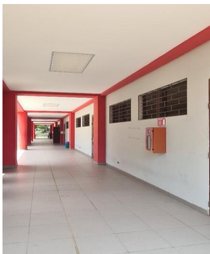
Figura 7. Vista exterior de módulo de aulas 31, 32 y 33
