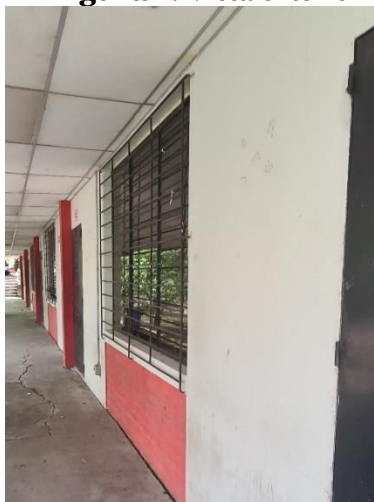
Figura 1. Vista exterior del aula 5
