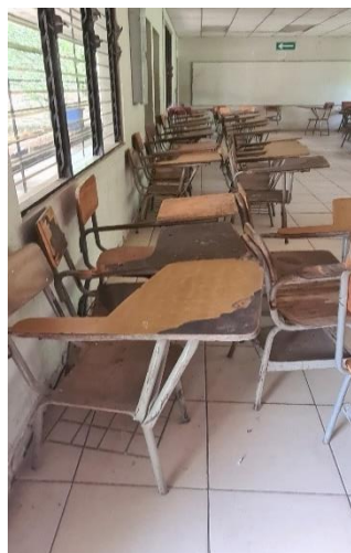
Figura 2. Vista interior del aula 5
