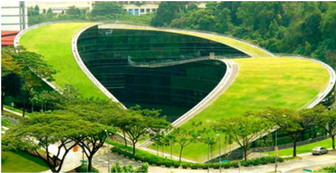
Cubierta verde del edificio de la Escuela de Arte, Diseño y Audiovisuales de Singapur
